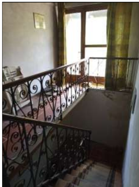
Foto 44 vano scala P1-P2
