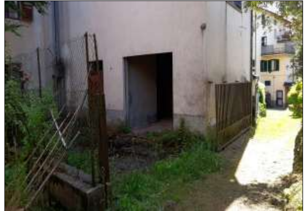
Foto 25 resede a comune - ingresso cantina a comune
