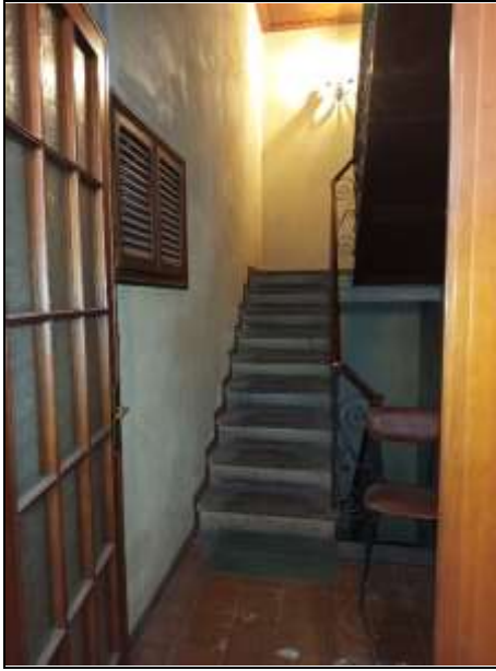
Foto 13 vano scala per accedere al P1
