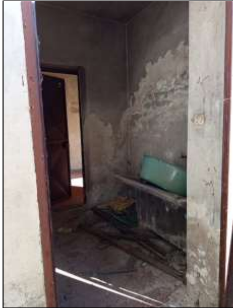
Foto 20 caldaia a comune
