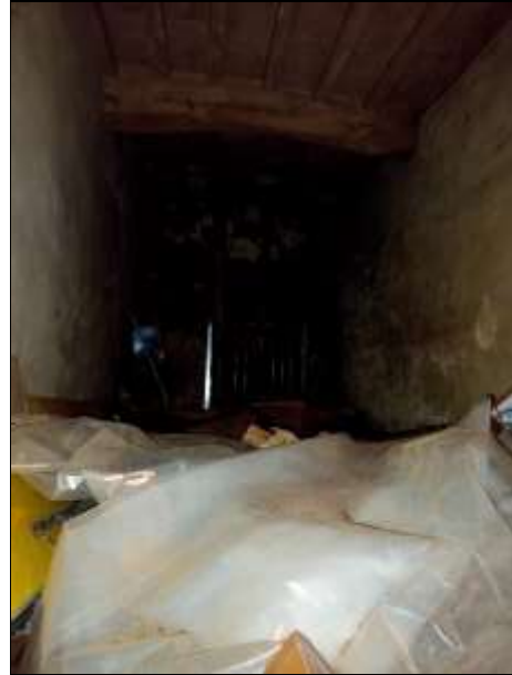
Foto 17 disimpegno a comune
