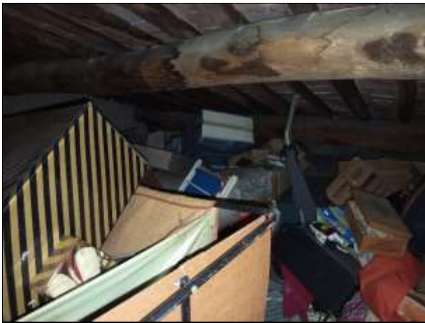
Foto 53 sottotetto non abitabile
