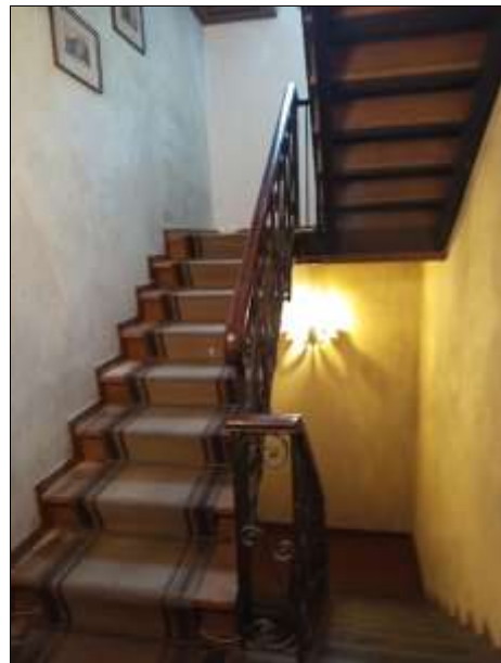
Foto 27 vano scala P1-P2
