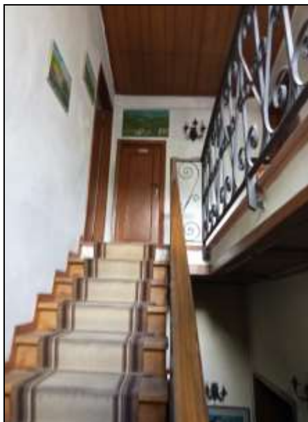
Foto 43 vano scala P1-P2
