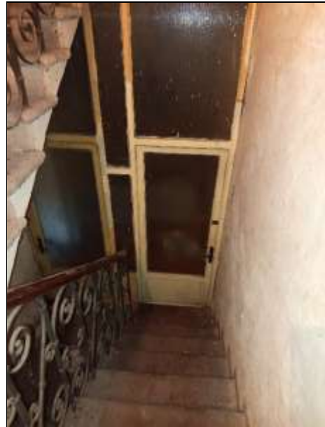
Foto 15 vano scala tra Pt e PS1 a comune
