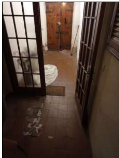
Foto 12 ingresso a comune
