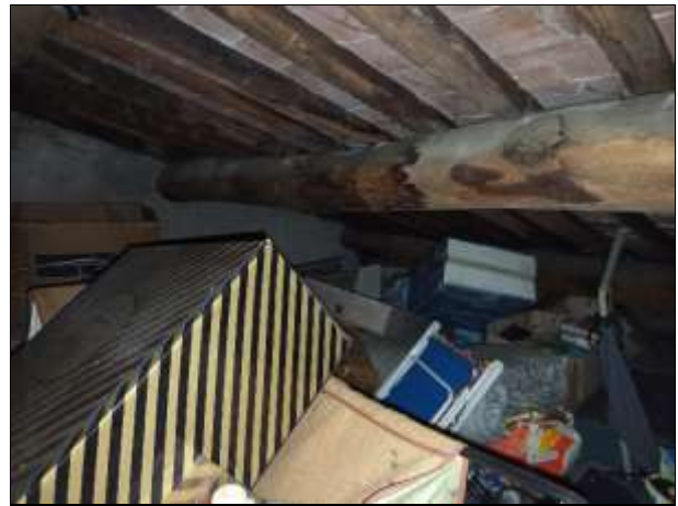
Foto 54 sottotetto non abitabile
