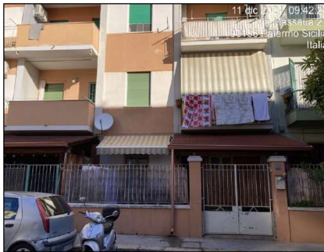
Foto n. 1 – Prospetto sulla via Massaua
