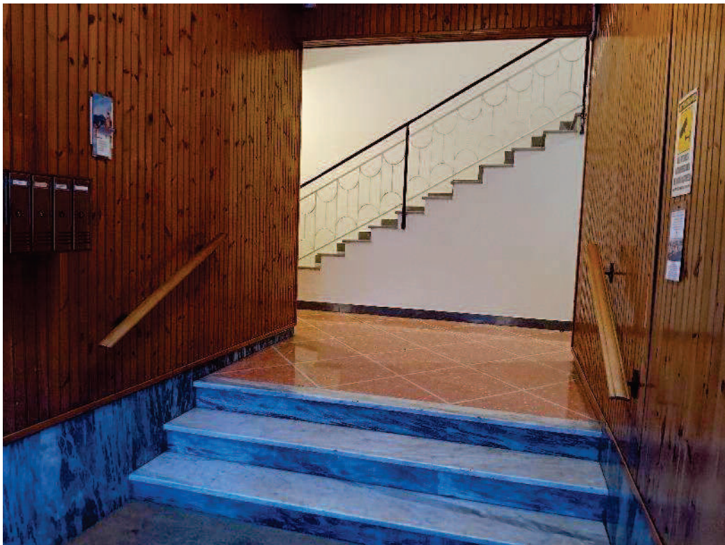
VISTA ATRIO INGRESSO CONDOMINIALE
