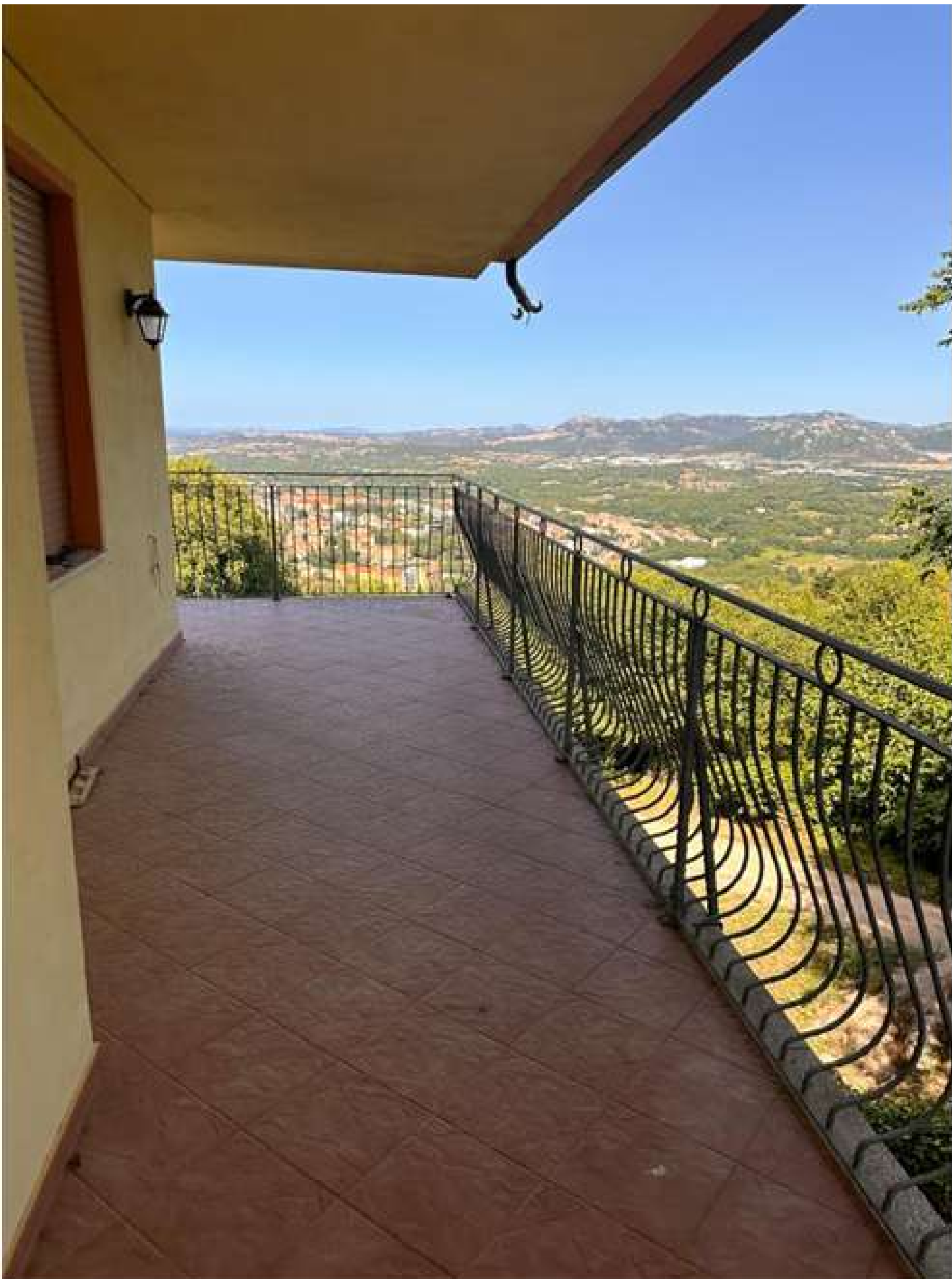
Foto 16: Intera balconata lato nord
