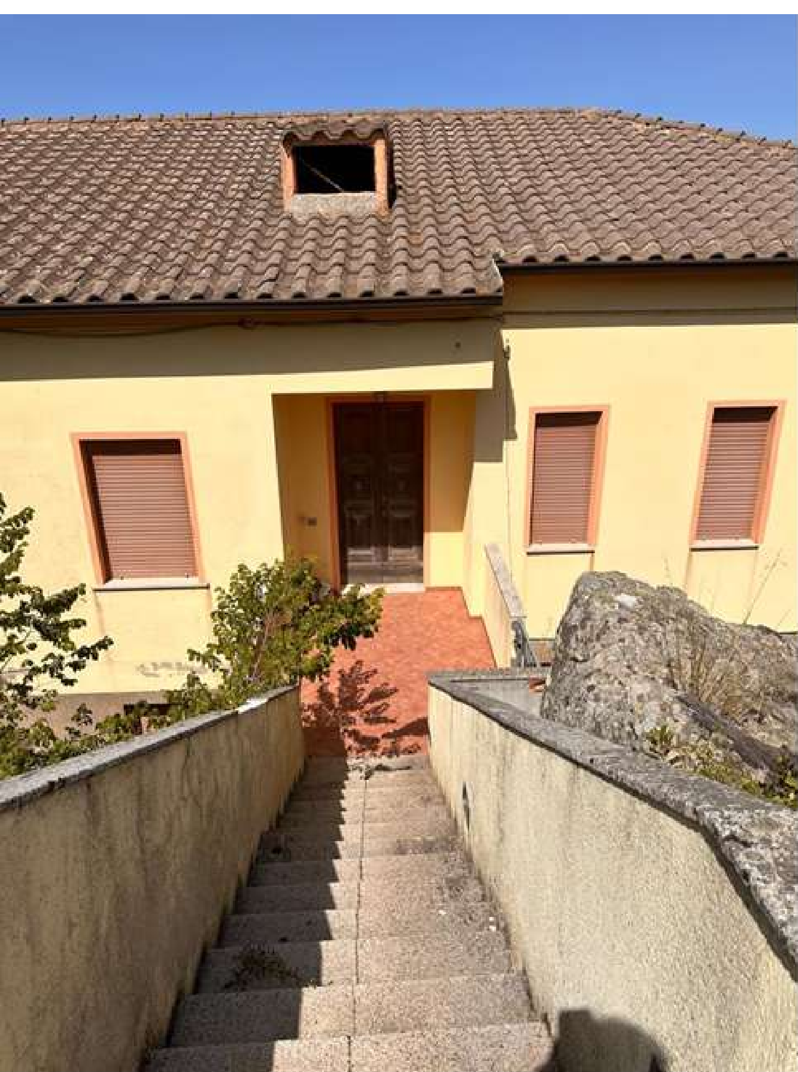
Foto 1: Scalinata in granito per l'accesso all'immobile costituito dal Piano Primo dell'intero compendio
