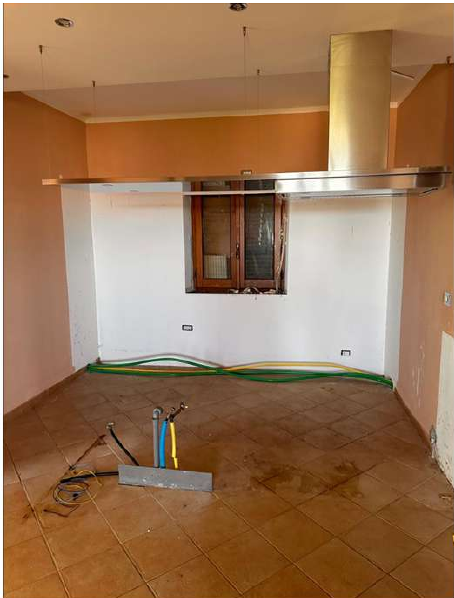
Foto 13: Soggiorno-Cucina e finestra che si affaccia lato est
