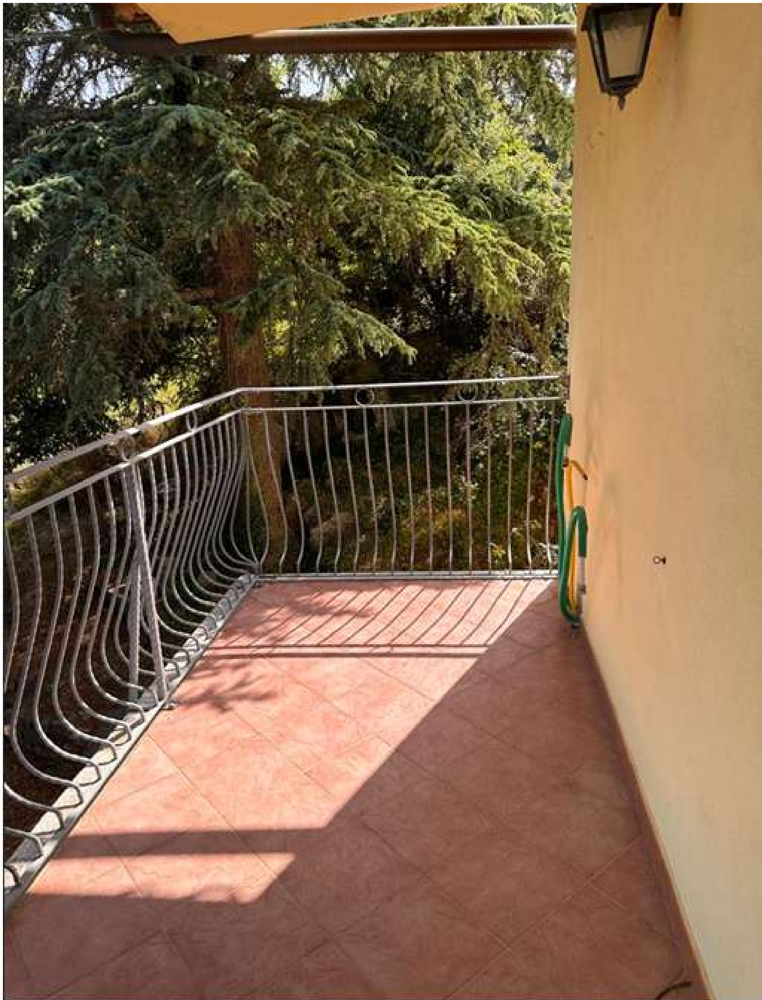
Foto 15: Balconata lato nord
