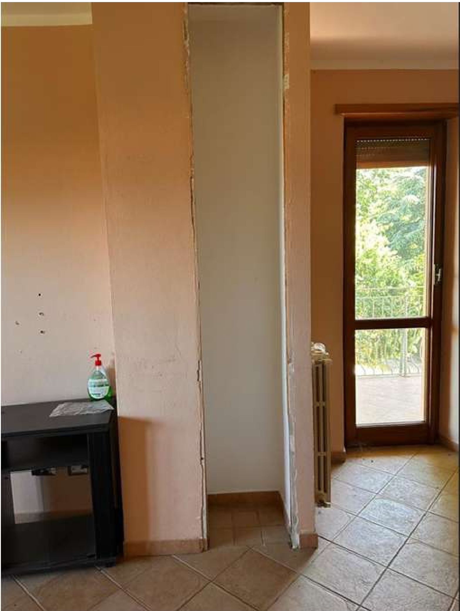
Foto 12: Porta - finestra del Soggiorno-Cucina che conduce sulla balconata lato nord
