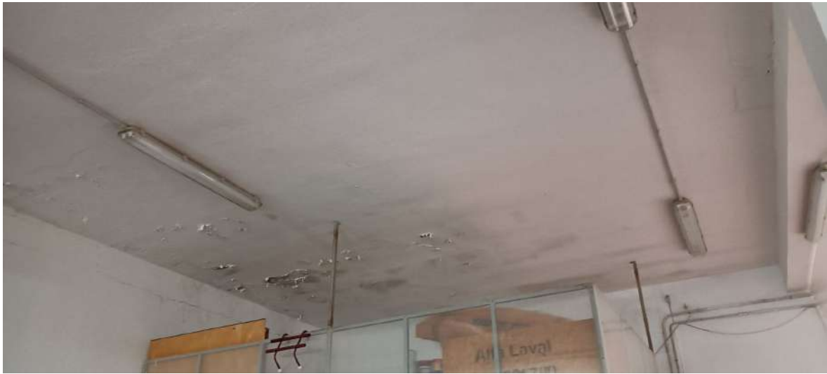
Fotografia n° 16 – particolare intradosso solaio
