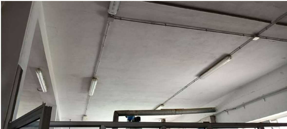
Fotografia n° 17 – particolare intradosso solaio
