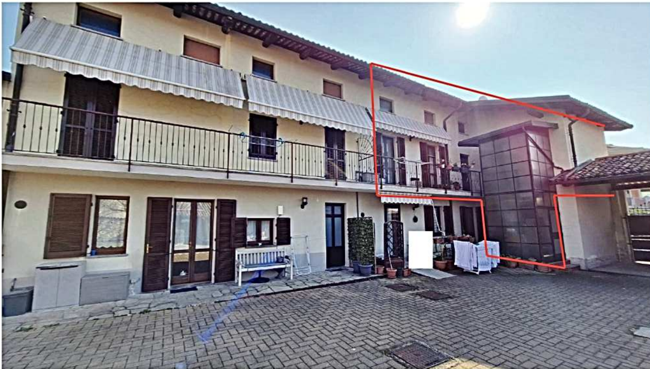
3) Facciata lato ovest
