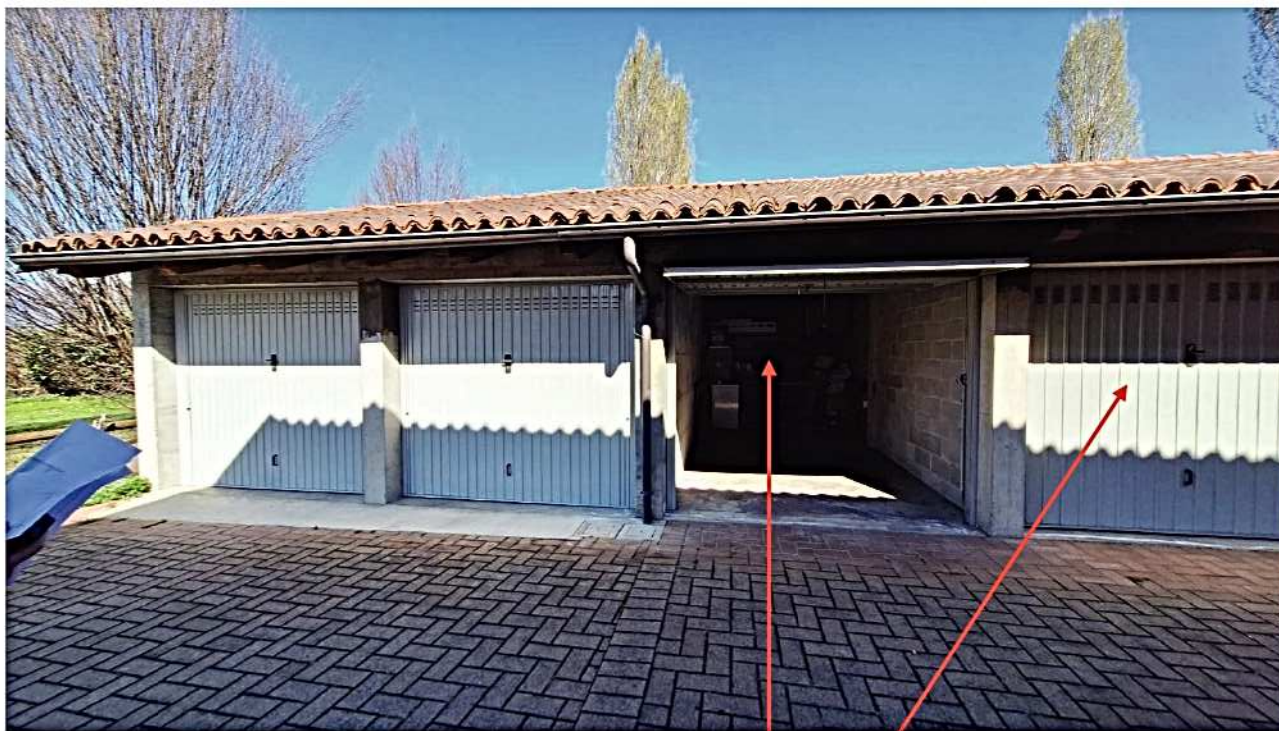
32) Autorimessa sub. 16 – sub. 15
