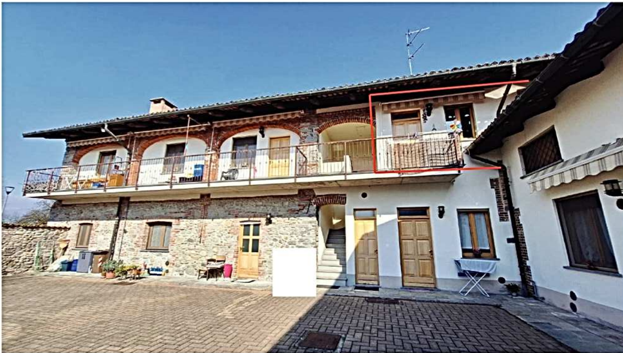
3) Vista alloggio 1° P. lato sud
