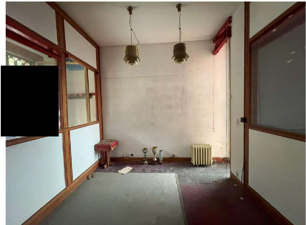
Foto 7. - Vista Piano terra
