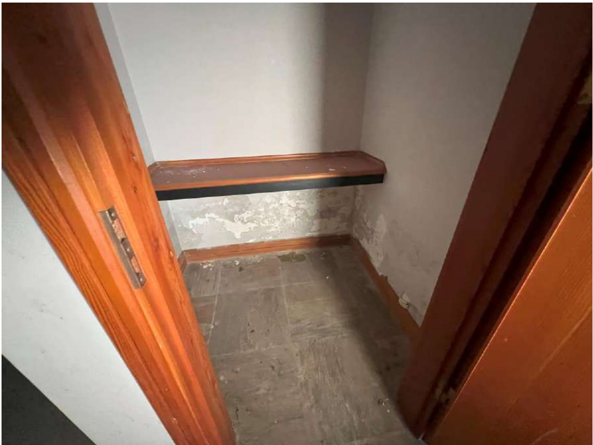
Foto 13. - Piano seminterrato: ripostiglio
