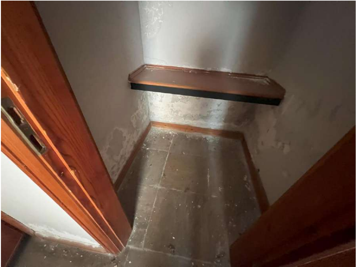
Foto 14. - Piano seminterrato: ripostiglio
