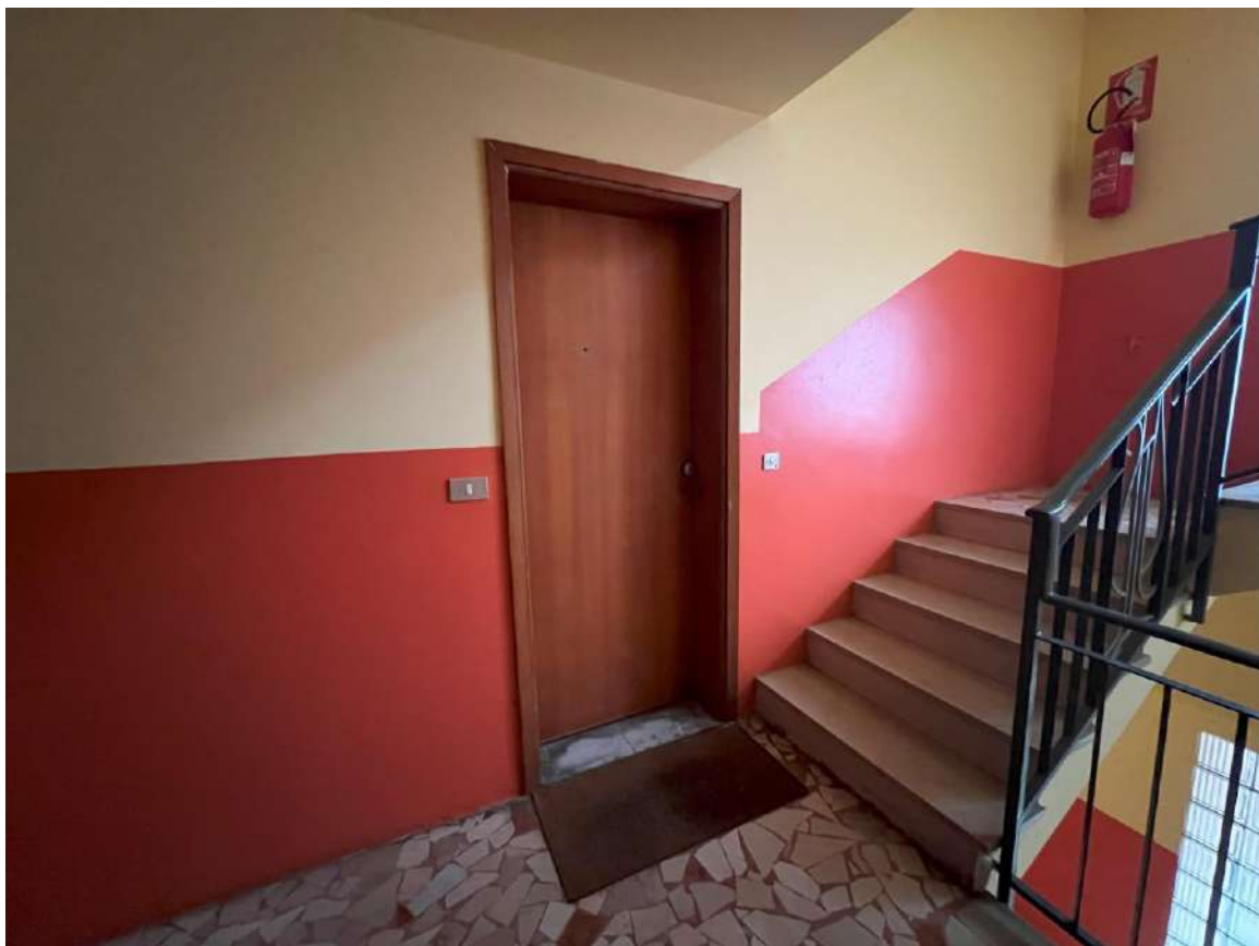
Foto 17. - Accesso da vano scala condominiale a piano primo seminterrato
