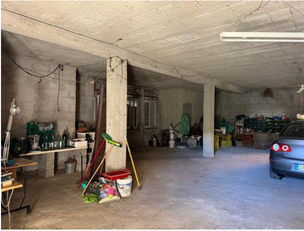
Foto 9 – Interni - P. Seminterrato Loc. Sgombero
