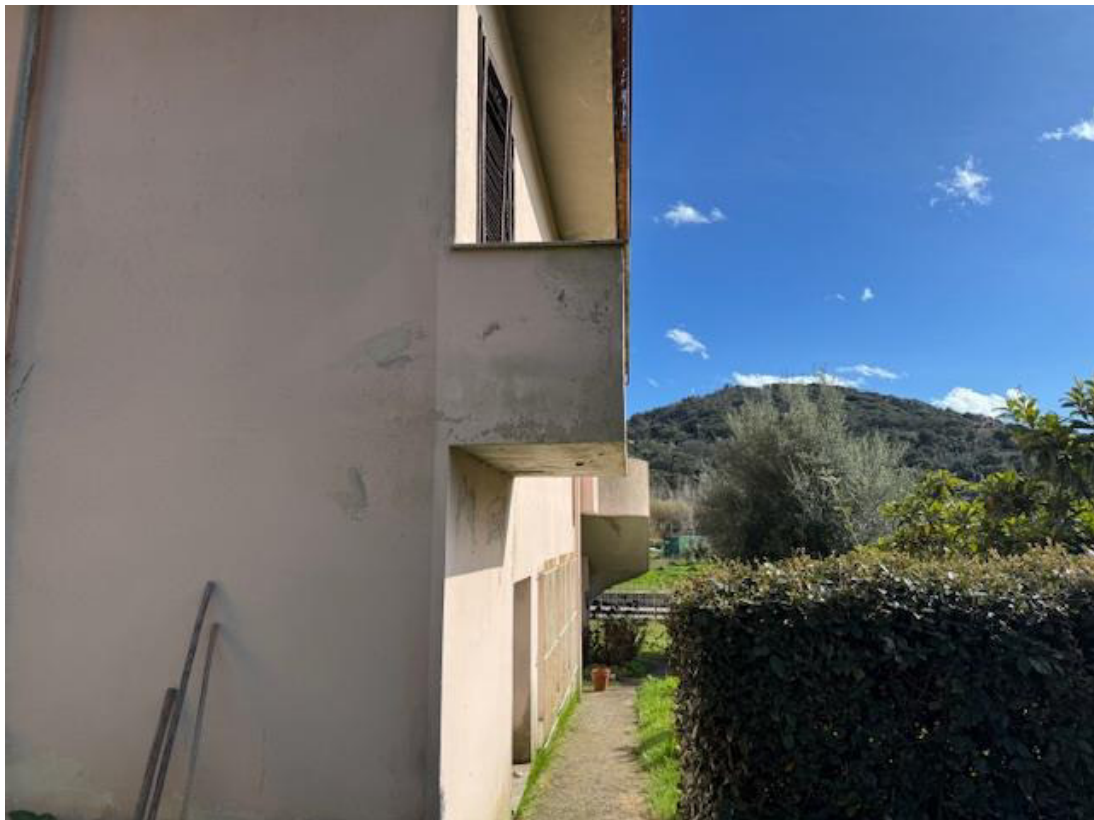
Foto 8 – Vista facciata laterale
