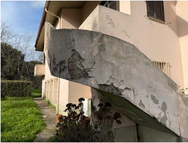
Foto 11 – Scala esterna di Accesso al P. Terra
