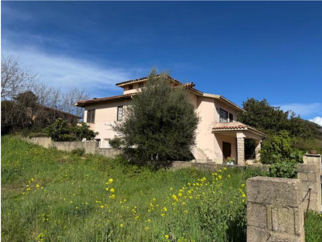
Foto 7 – Vista facciata laterale
