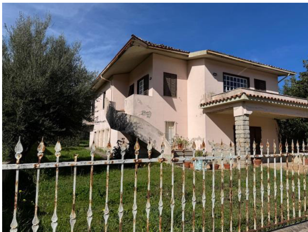
Foto 6 – Vista facciata principale
