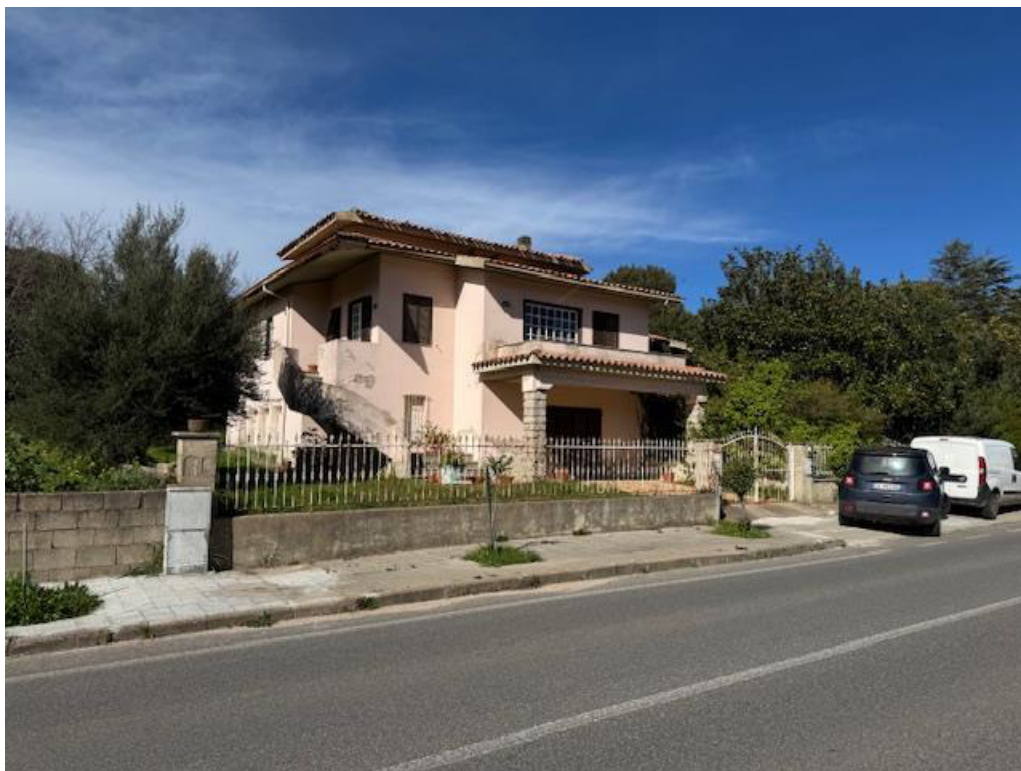
Foto 5 – Vista facciata principale
