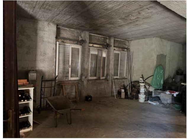
Foto 10 – Interni - P. Seminterrato Loc. Sgombero
