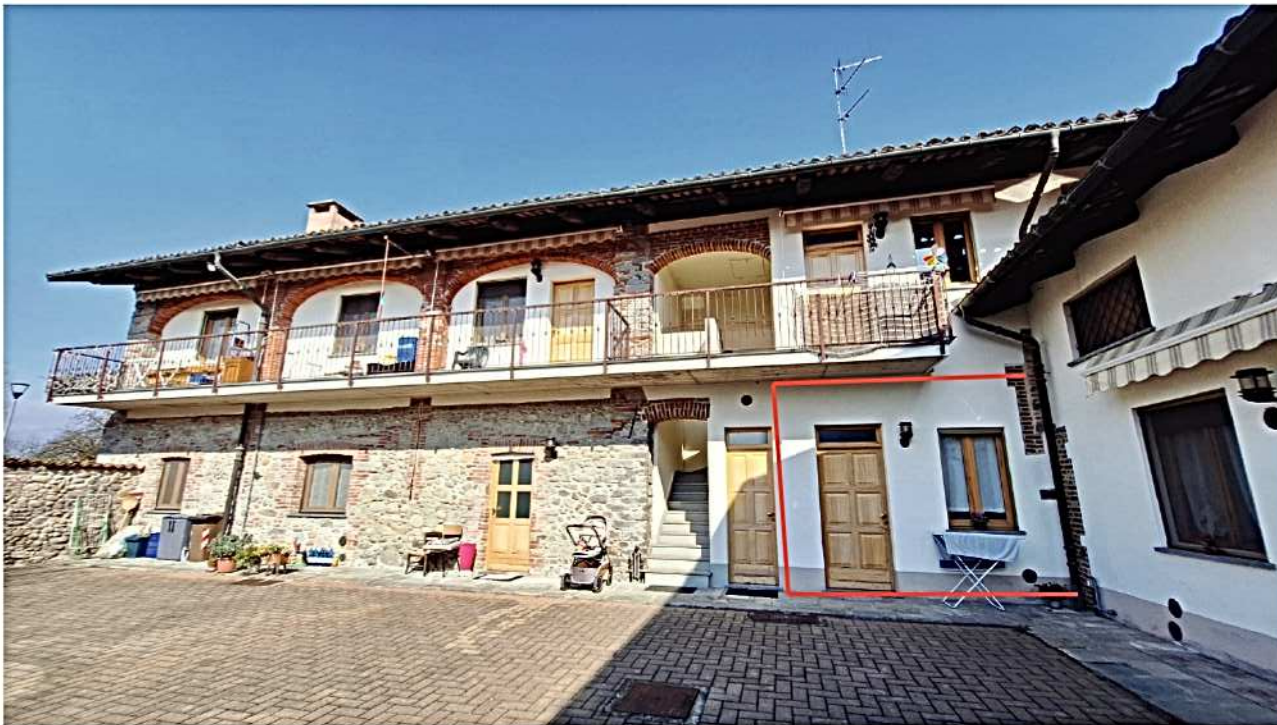
3) Vista facciata sud con ingresso al P.T.
