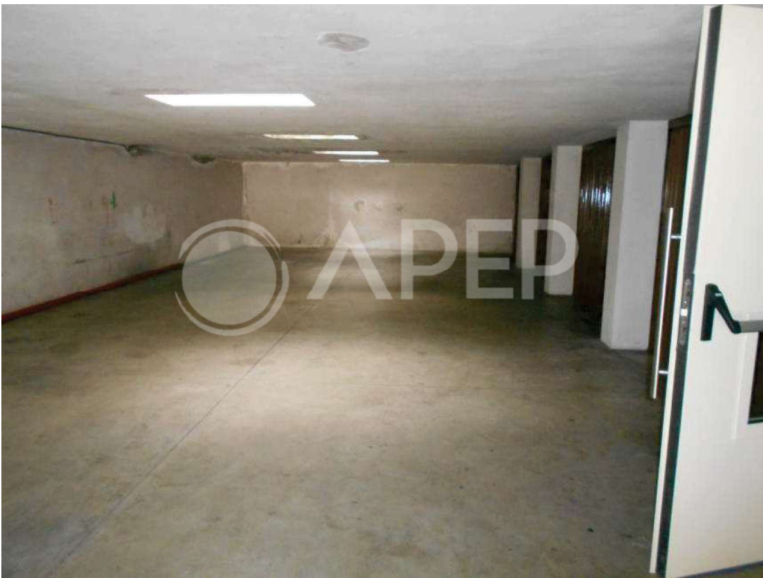
Foto 28: corsia di manovra dell'autorimessa interrata
