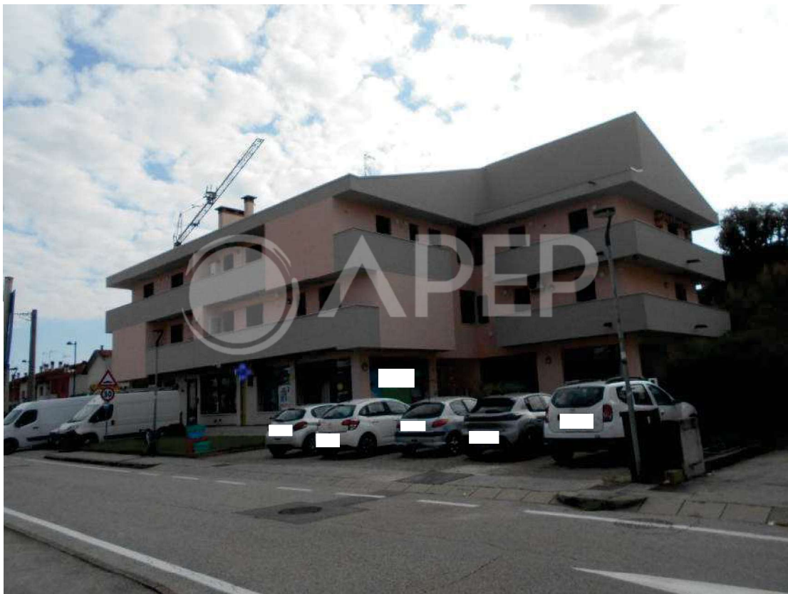
Foto 5: fabbricato condominiale, vista da via Vivaldi
