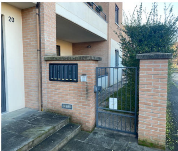
Vista Esterna n.3
