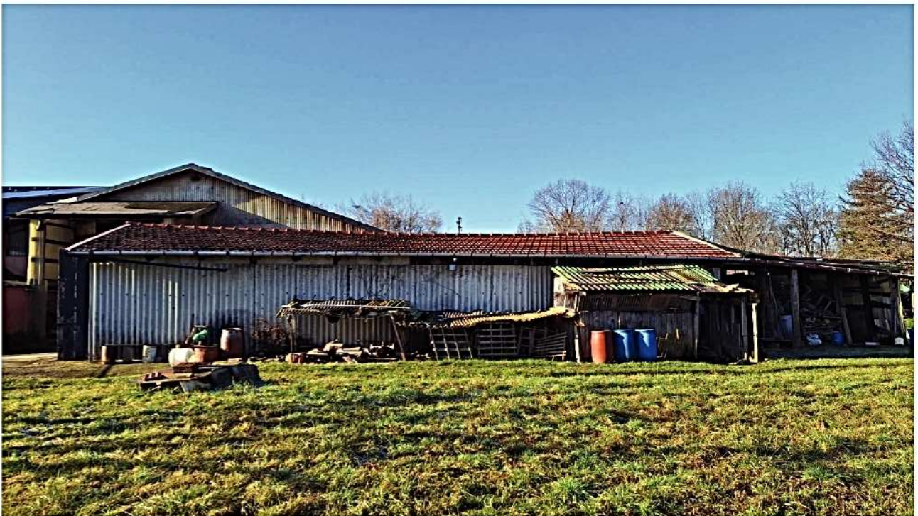
7) Vista complessiva lato est
