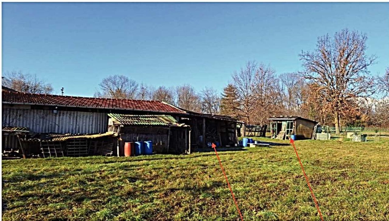
8) Vista testata nord del lato est con baracca abusiva in testata e in alto lato dx
