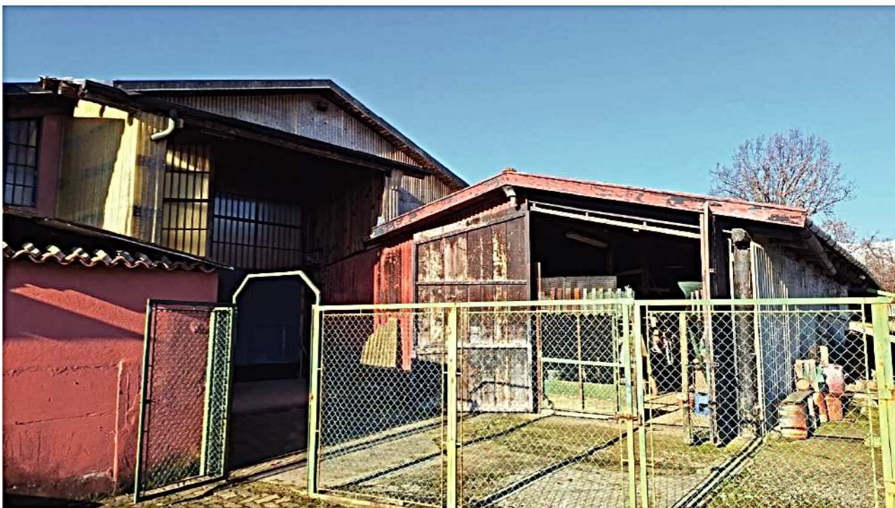
5) Vista ingresso lato sud
