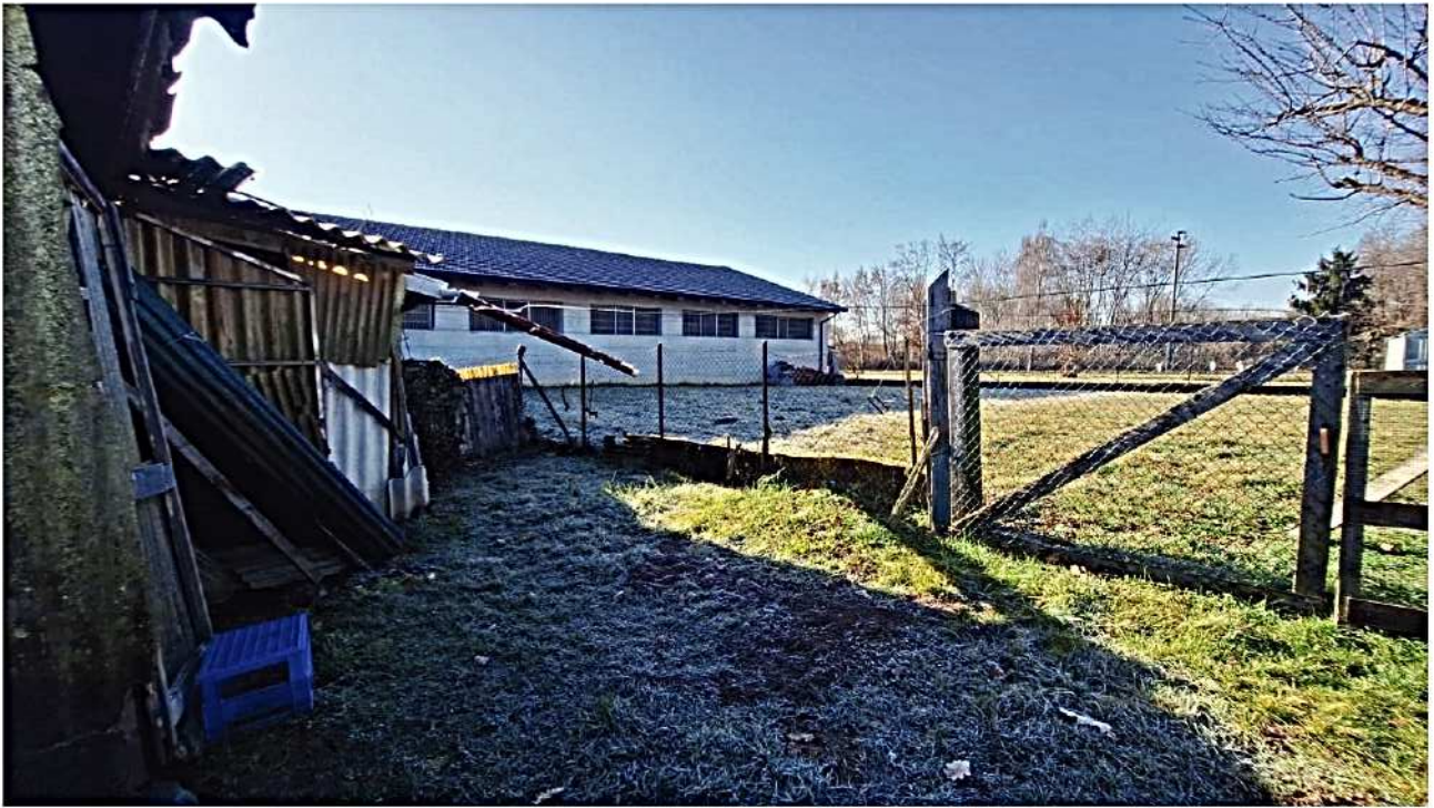
10) Vista terreno lato ovest
