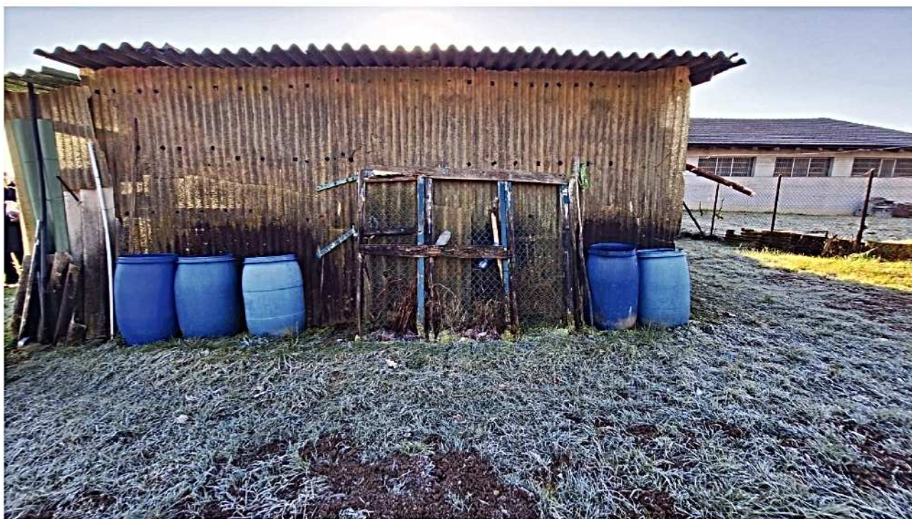
9) Vista del lato nord testata tettoia non autorizzata
