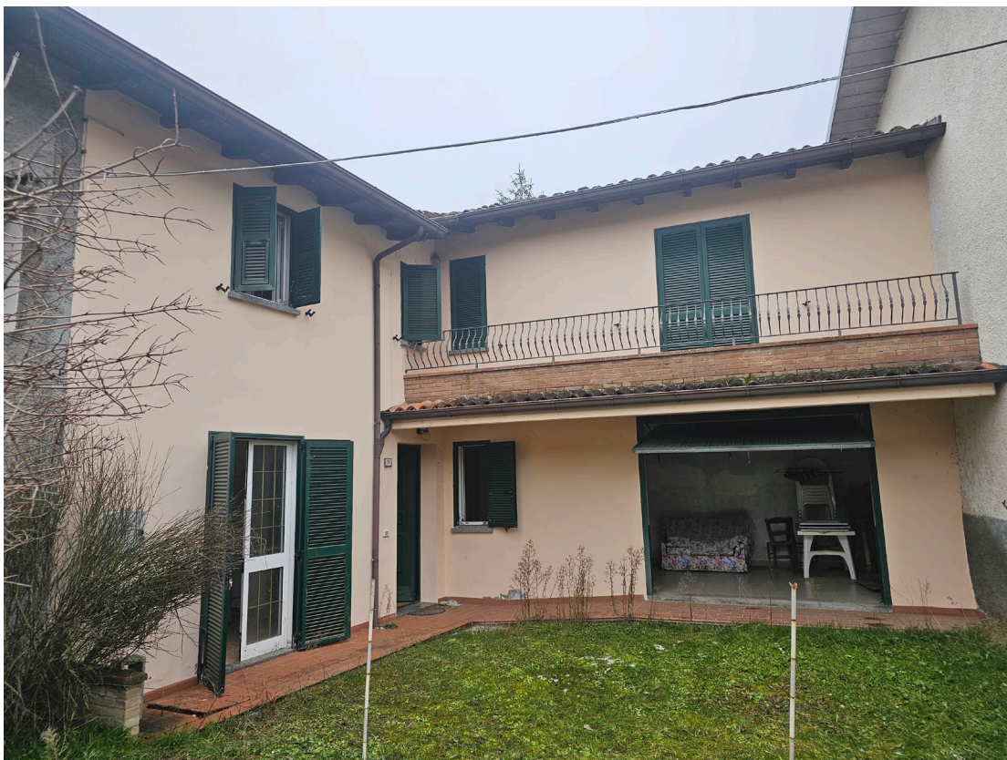
Esterno 2: Prospetti sud ed ovest con porzione area cortiliva (sub.3 BCNC)
