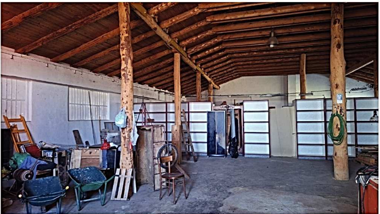
19) Edificio lato nord
