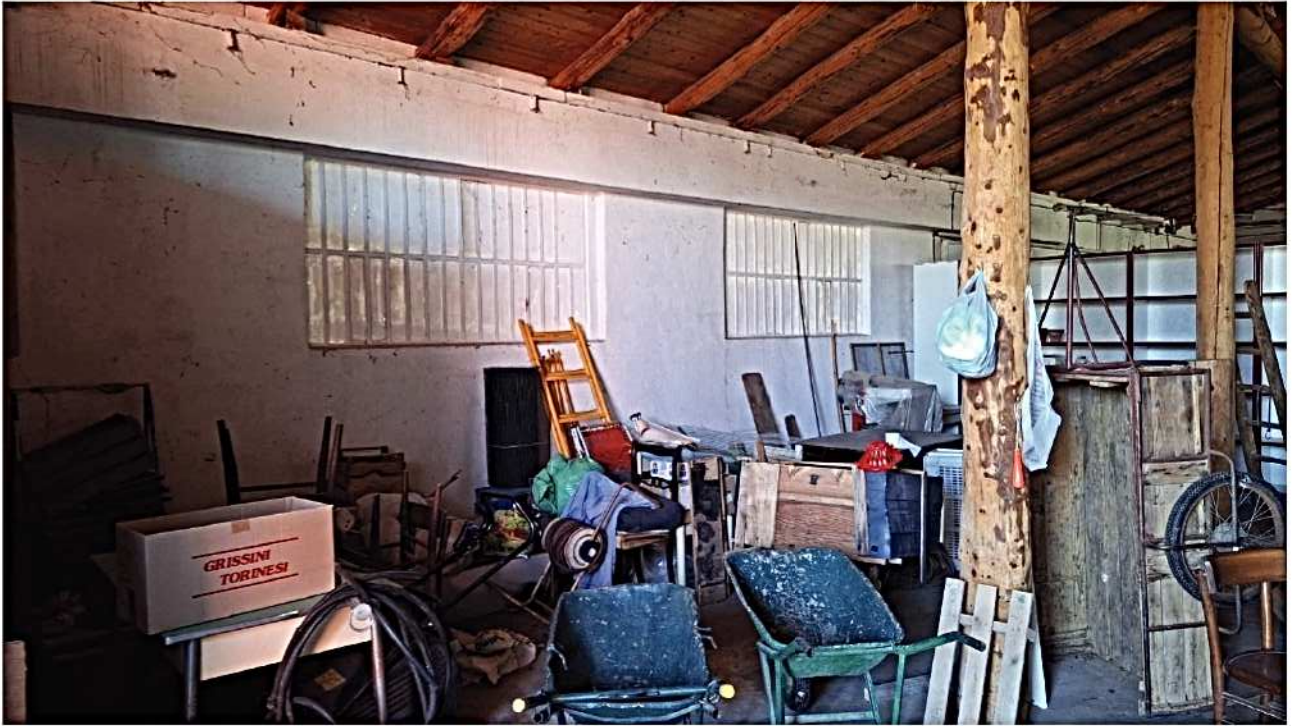
20) Edificio lato nord porzione in esecuzione
