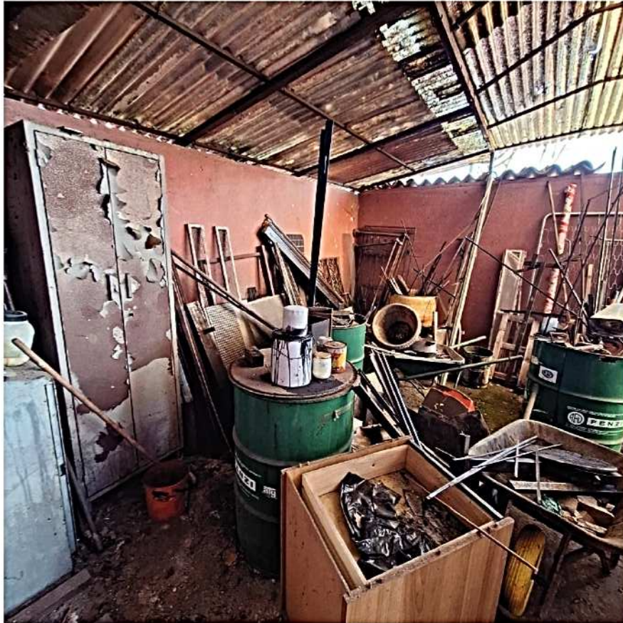
22) Deposito sotto tettoia lato nord-est
