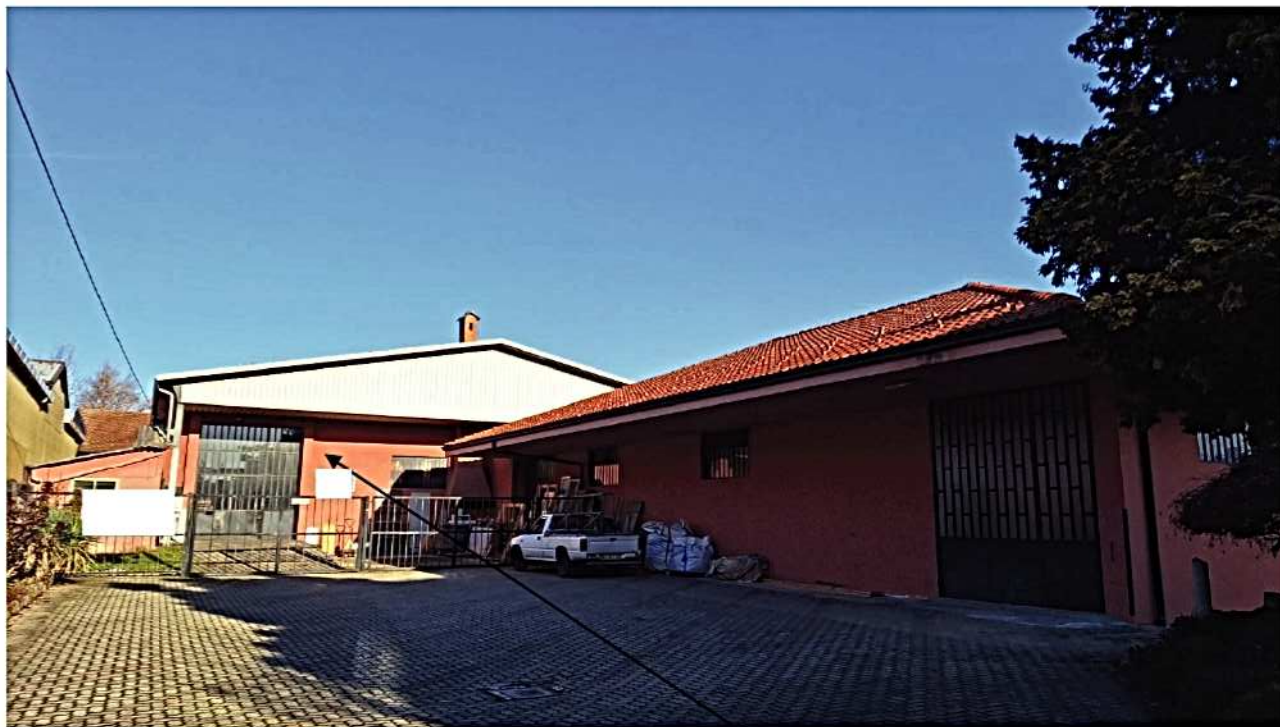
6) Facciata sud lotto 2
