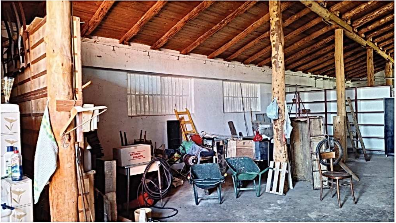
18) Retro edificio sul lato nord
