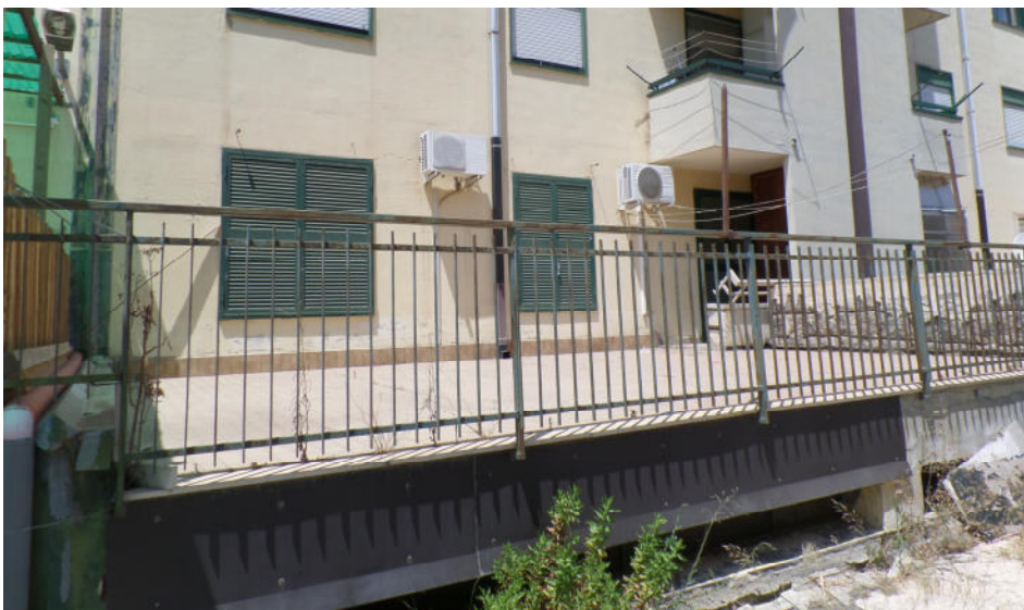
Foto n° 3. Vista Posteriore Palazzina "B": Interno 2
