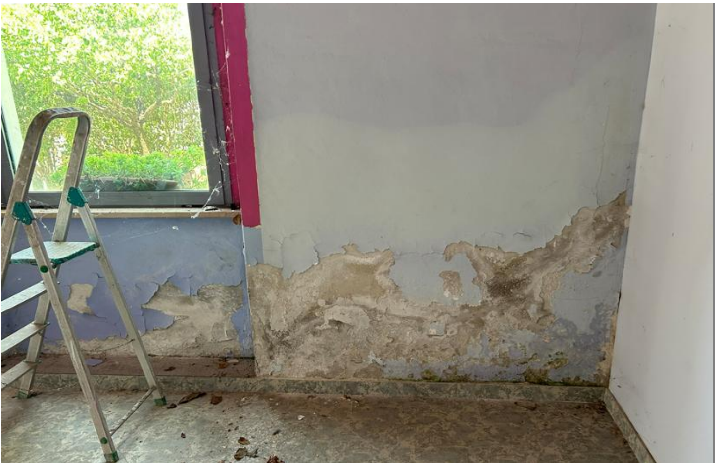
Dettaglio infiltrazioni
