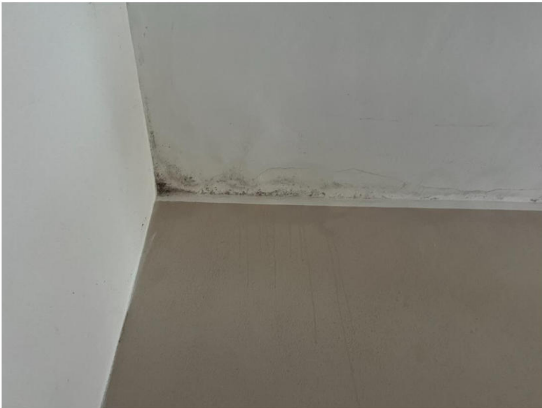
Foto 15. Particolare fenomeni di muffa camera da letto
