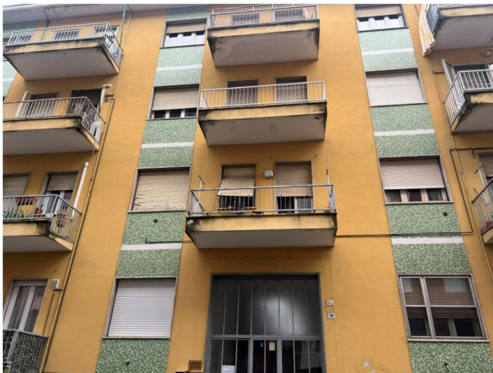
Foto 1. Fabbricato di cui fa parte l'immobile oggetto di stima
