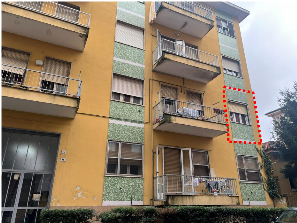
Foto 5. Identificazione dell'appartamento sul prospetto ovest
