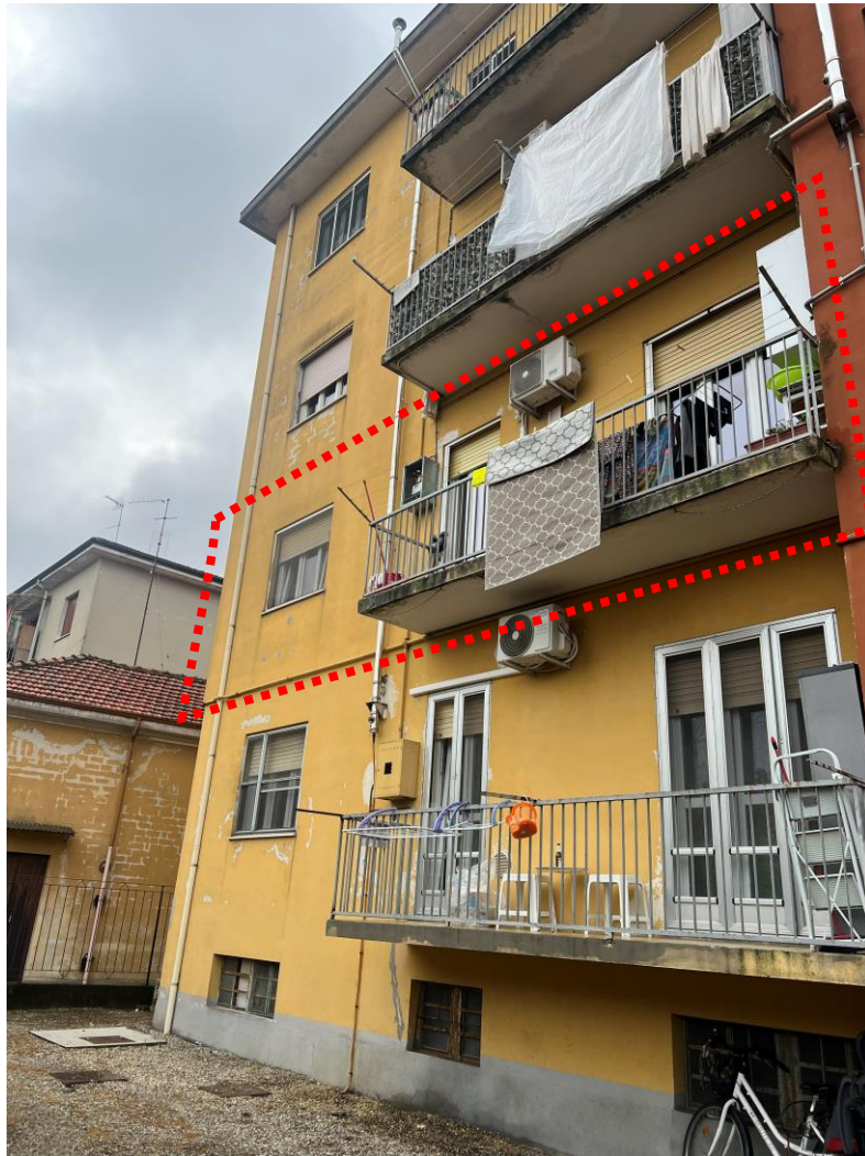
Foto 3. Identificazione dell'appartamento sul prospetto est
