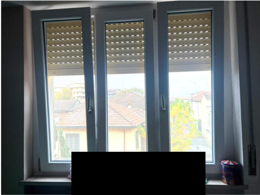
Foto 14. Particolare infissi esterni
