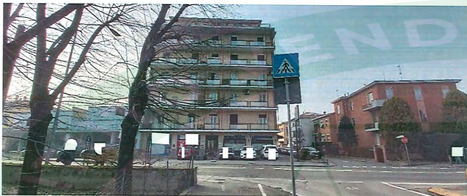
Foto 4: Prospetto su strada del fabbricato di Via San Leonardo n.68
