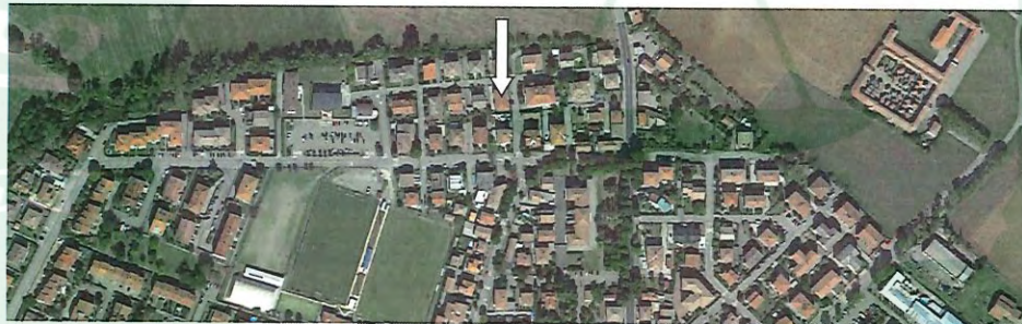
Foto 5: Ubicazione da fotopiano del fabbricato di Via Parmigianino n.5 all'incrocio con Via Michelangelo
