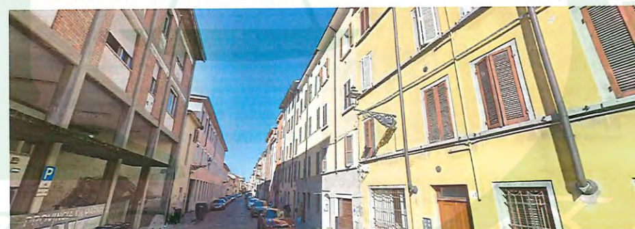
Foto 2: Prospetto su strada del fabbricato al civico 52 di Via Corso Corsi
