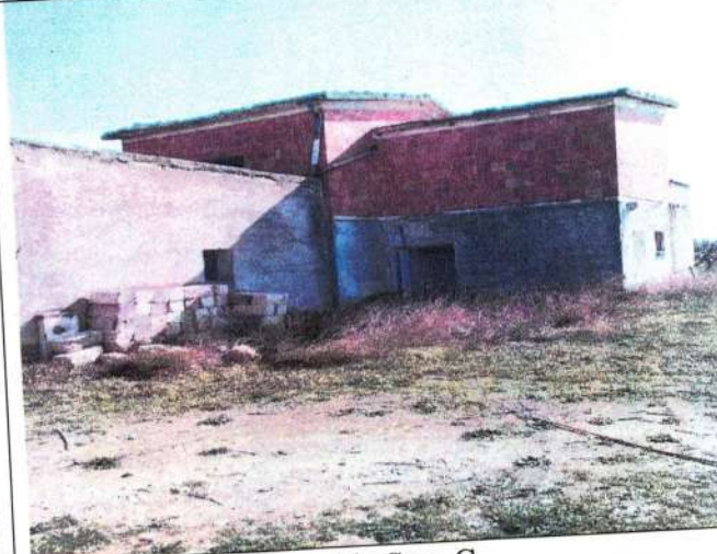
Fabbricato fgl 87 p.lla 601 (ex106) del comune di Bernalda Sez. C.
