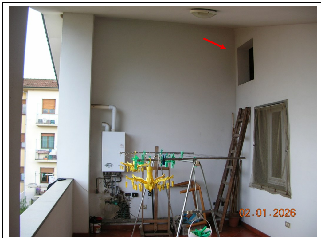
Foto 52 – Apertura per l'accesso al sottotetto
