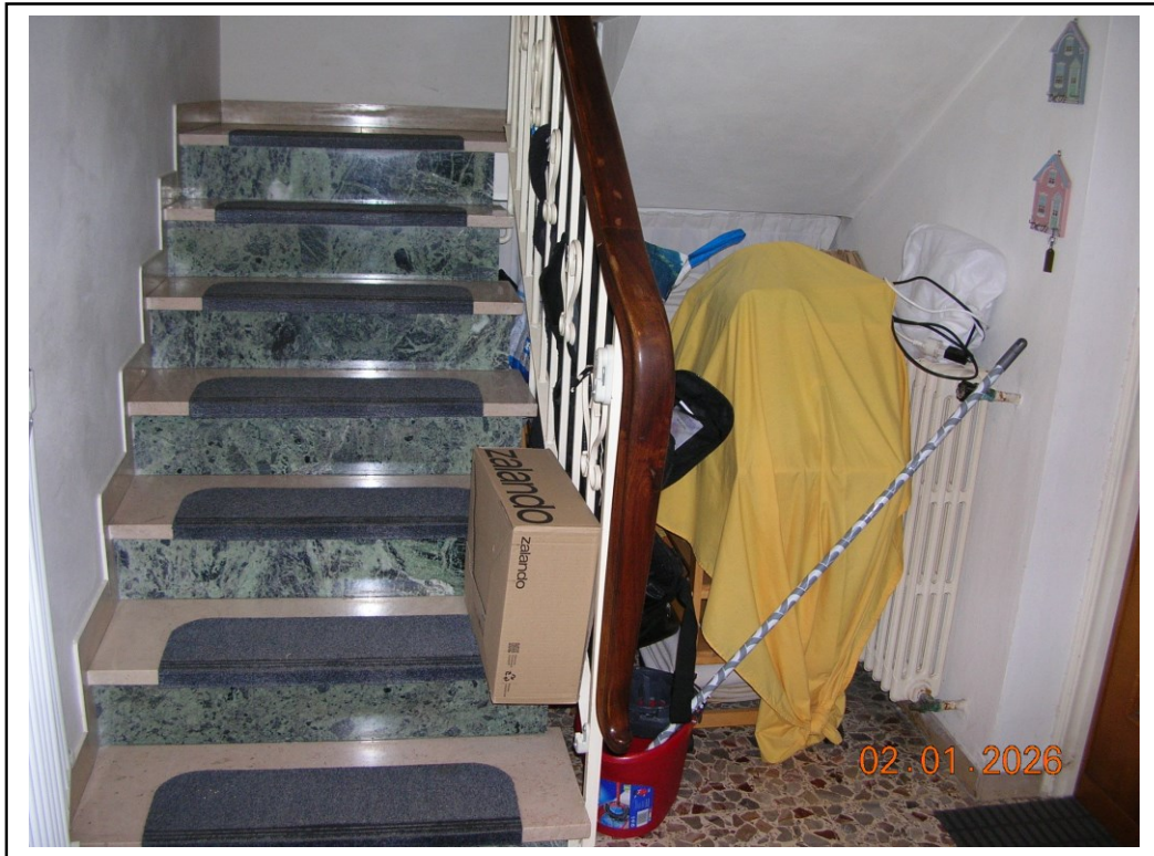
Foto 26 – Scala d'accesso al piano primo
