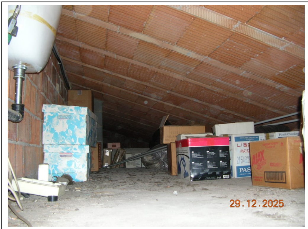
Foto 53 – Intercapedine parziale realizzata nel sottotetto
