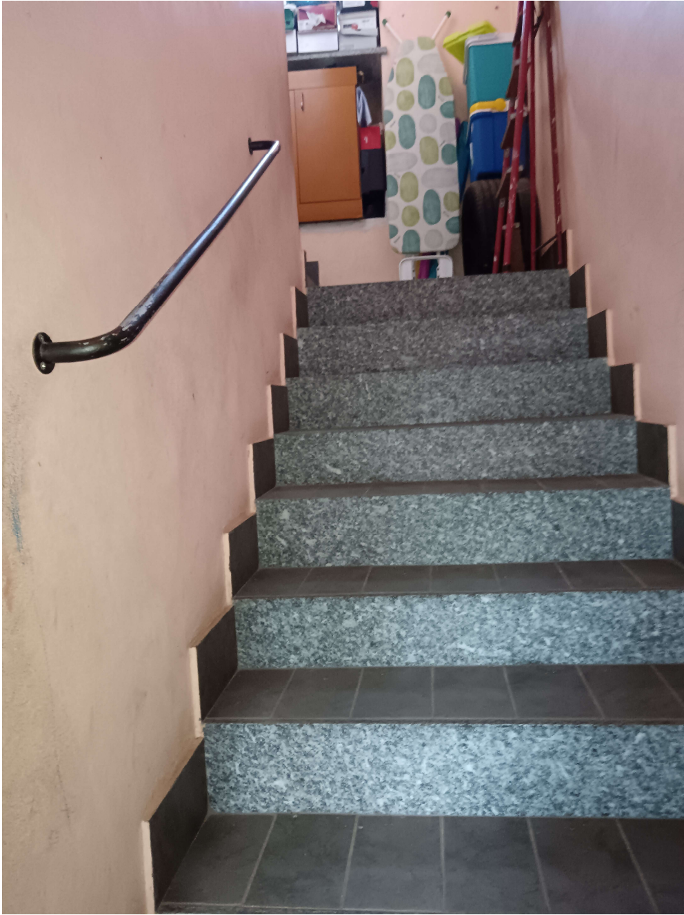
SCALA DI ACCESSO AL PIANO SUPERIORE
