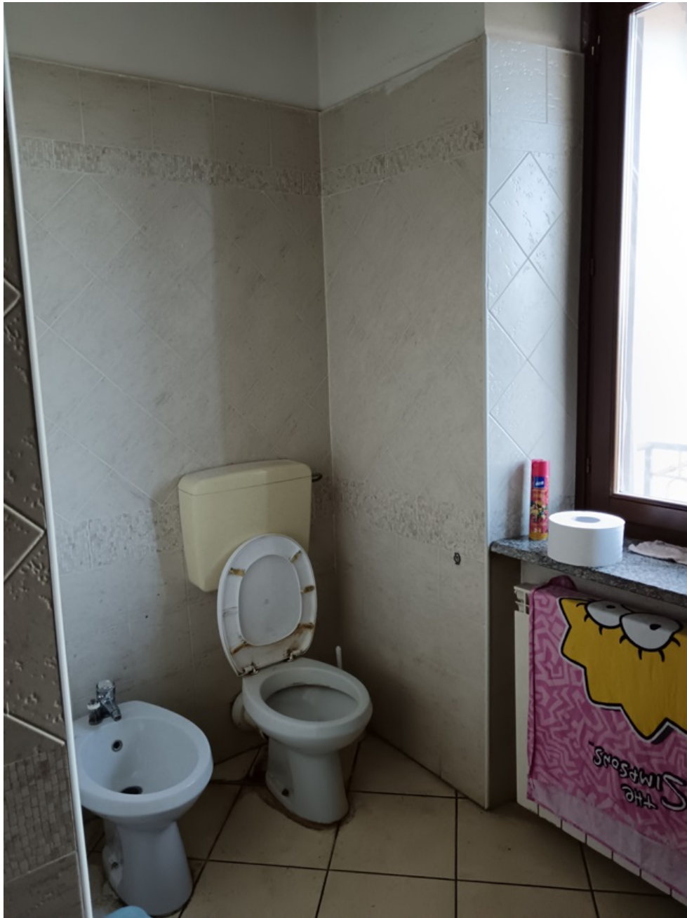
PARTICOLARE BAGNO PRIMO PIANO
