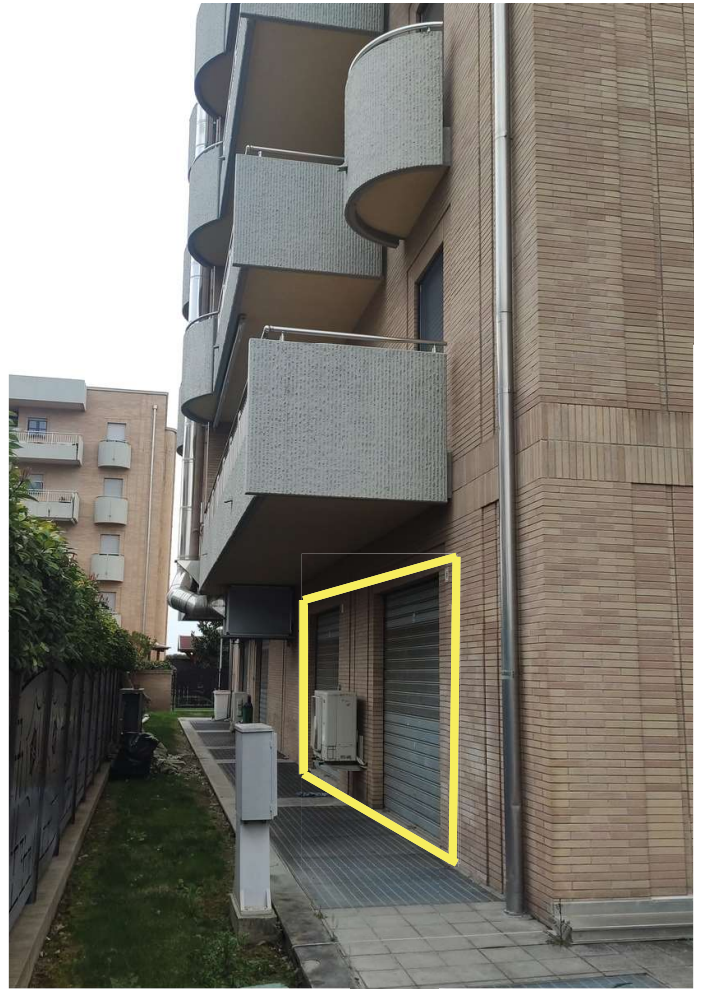
Foto 4 - Prospetto Ovest (civici 8i, 8 l)
