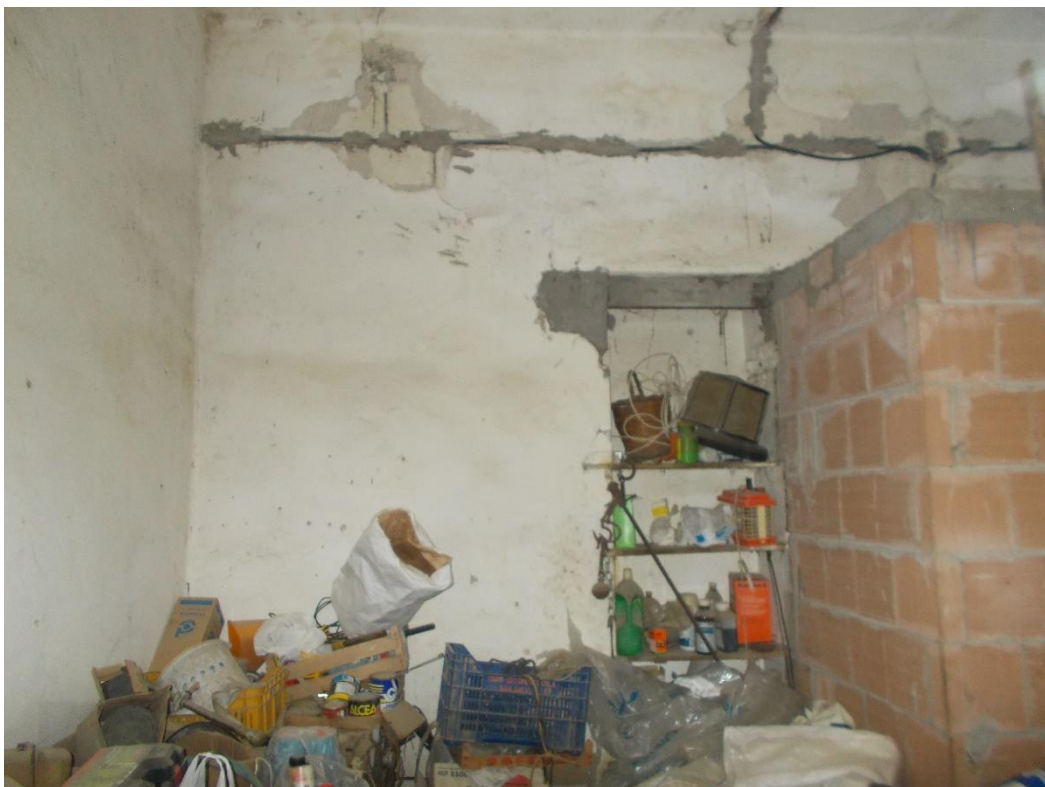
Foto n. 10 – Muratura perimetrale bagno
