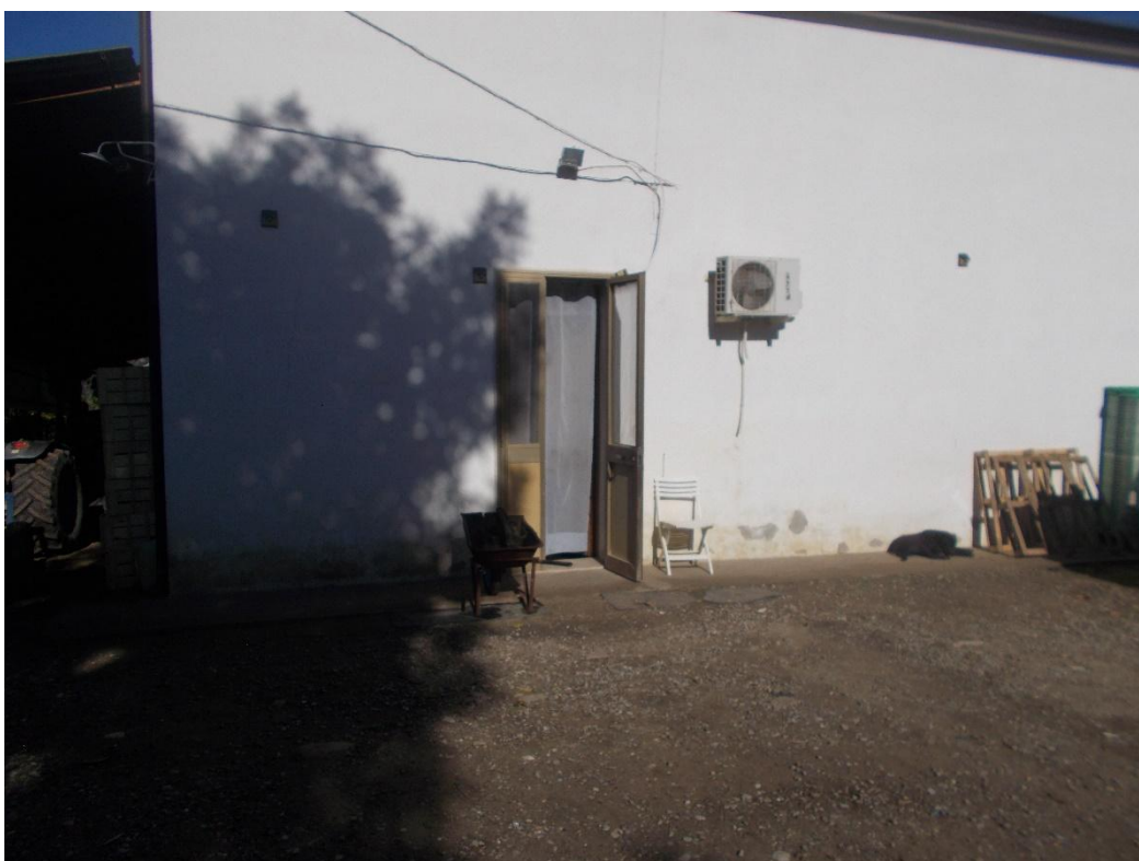
Foto n. 2 – Porta esterna di entrata locale deposito
