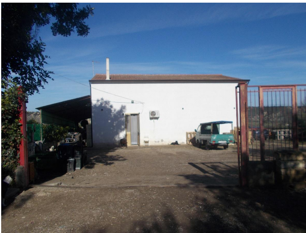
Foto n. 1 – Esterno Fabbricato casa colonica
