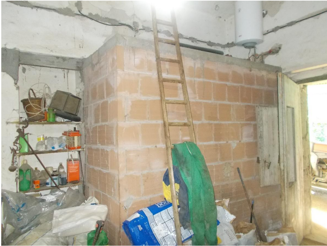
Foto n. 9 – Muratura perimetrale bagno
