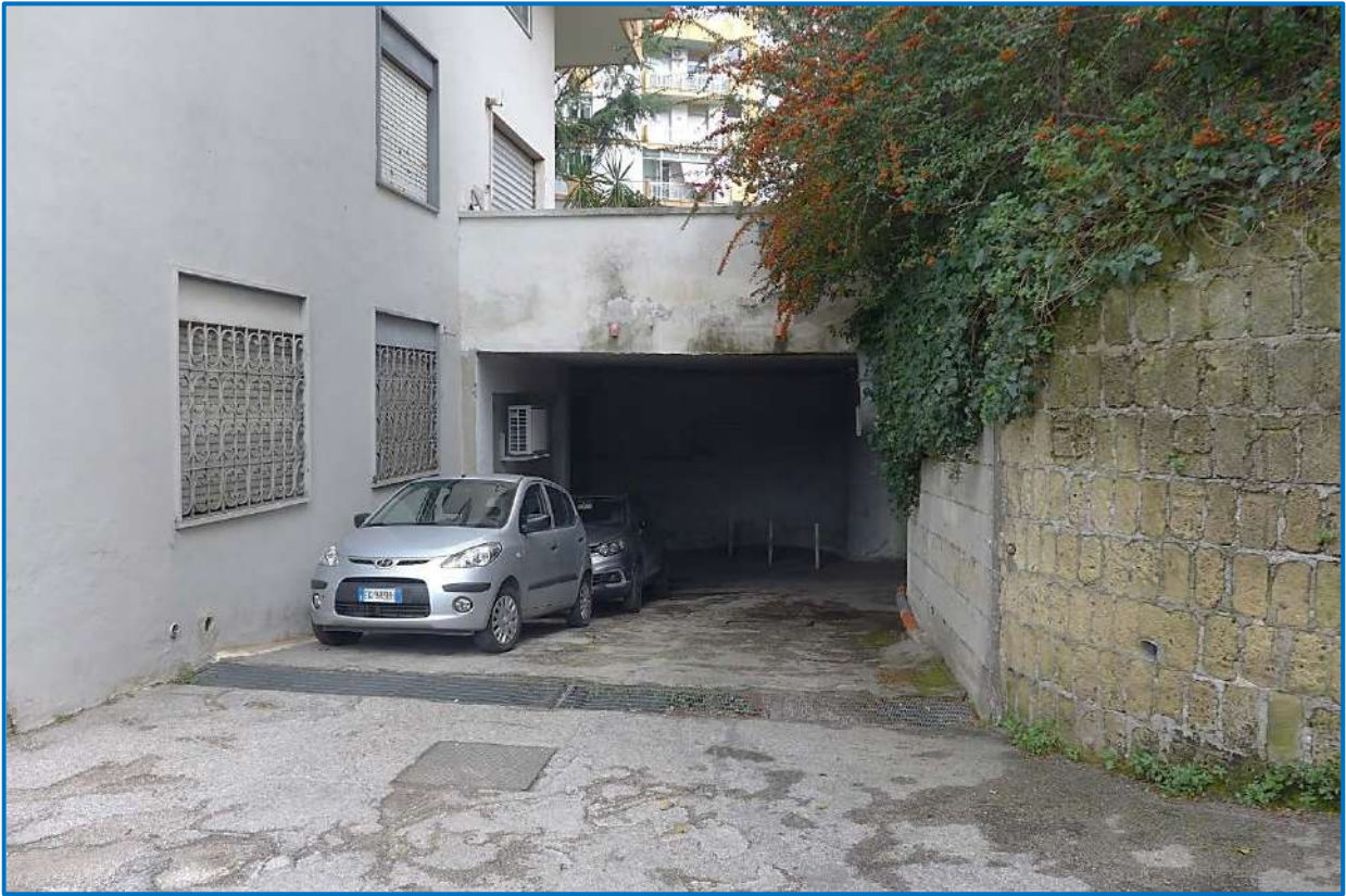
Foto n. 30 – Ingresso ai box auto
