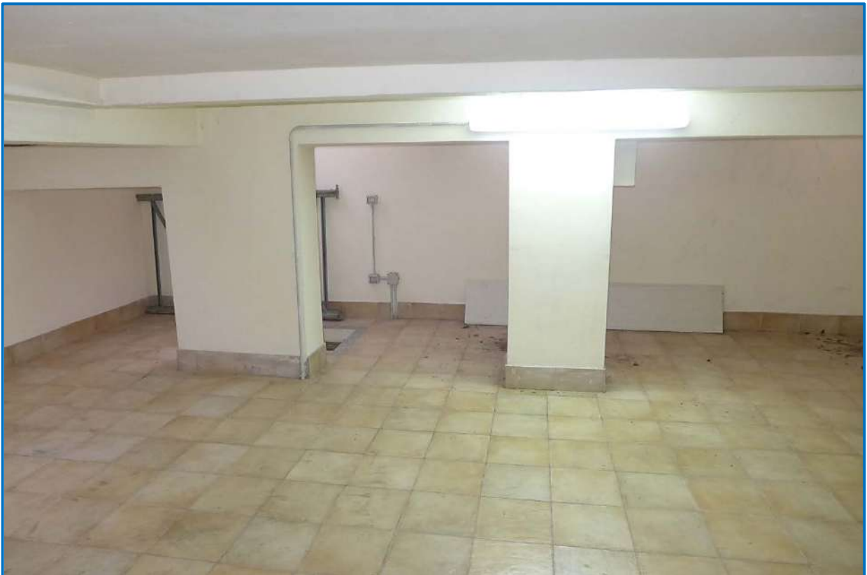
Foto n. 45 – Piano ammezzato (vista vs botola con scaletta)
