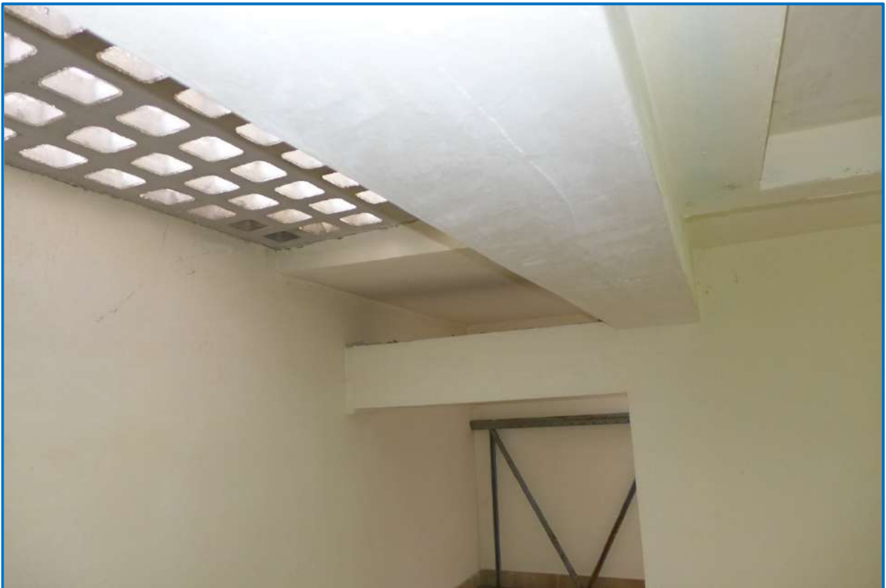
Foto n. 47 – Apertura con vetro cemento
