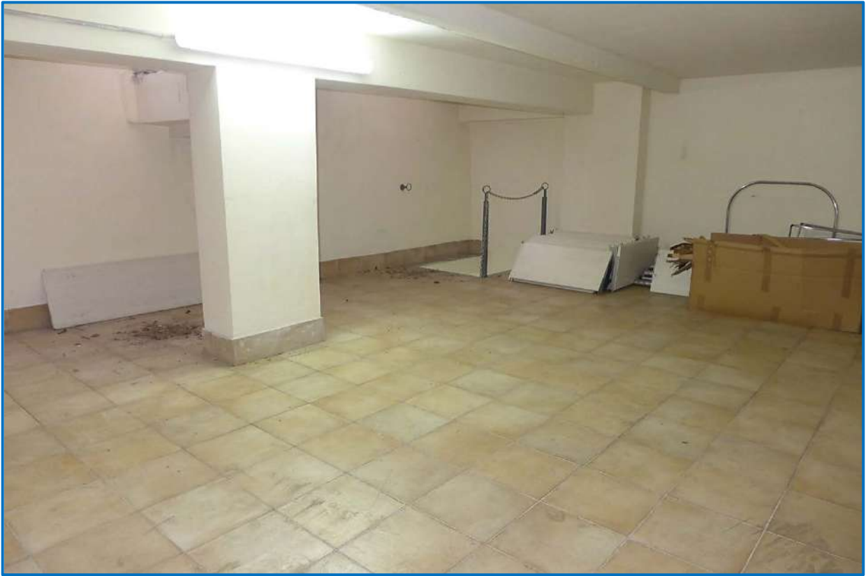
Foto n. 46 – Piano ammezzato (vista vs botola senza scaletta)
