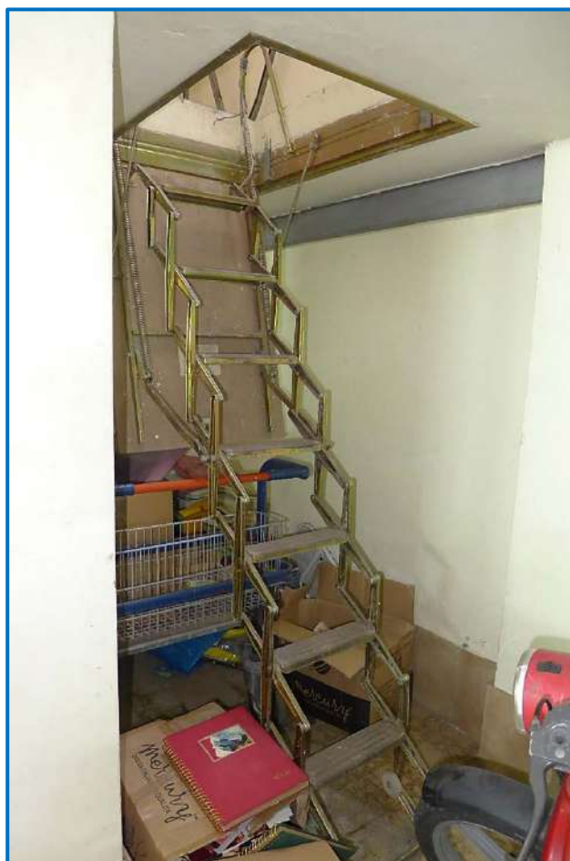
Foto n. 40 – Botola con scaletta interna
