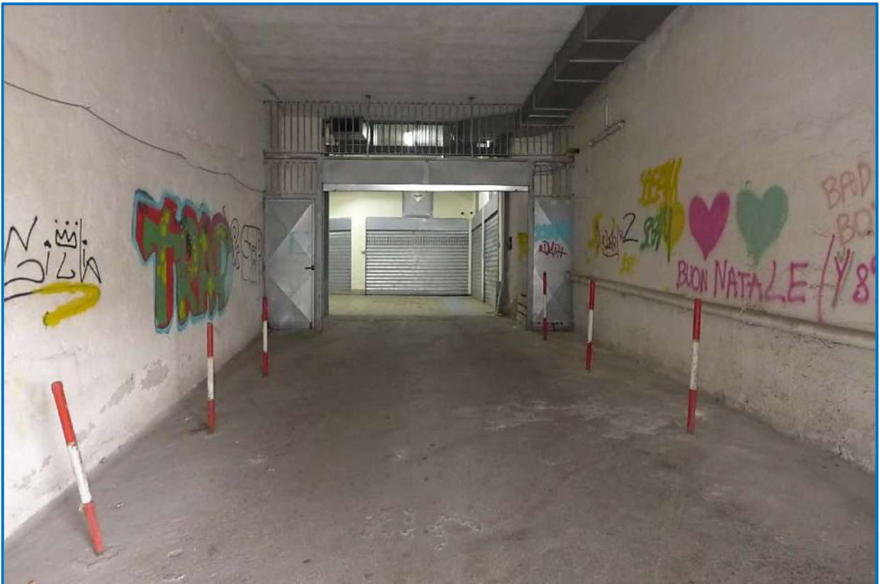
Foto n. 31 – Accesso corridoio destro (ingresso ai box auto)
