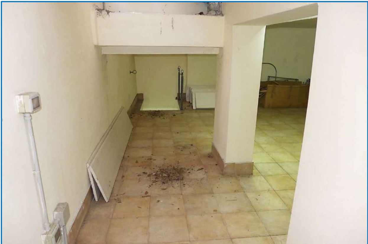
Foto n. 43 – Piano ammezzato (altra vista)
