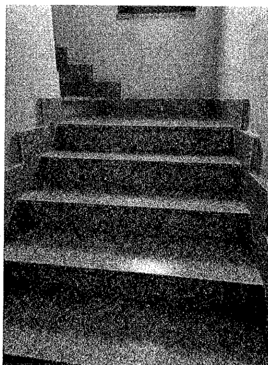
Fotografia F.4 - SCALE DI ACCESSO AL PIANO PRIMO
