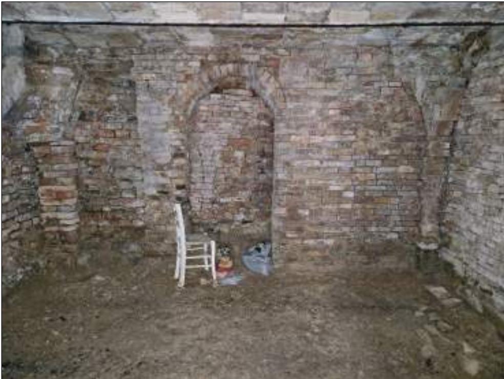
Foto 20: cantina (lato sud)
