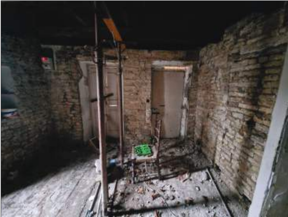
Foto 25: piano terra (stanza lato nord) e contatore energia elettrica
