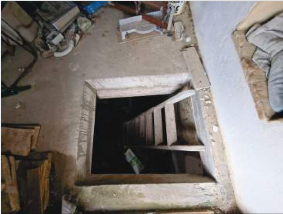
Foto 33: botola per accesso al piano secondo (sottotetto) dal piano primo
