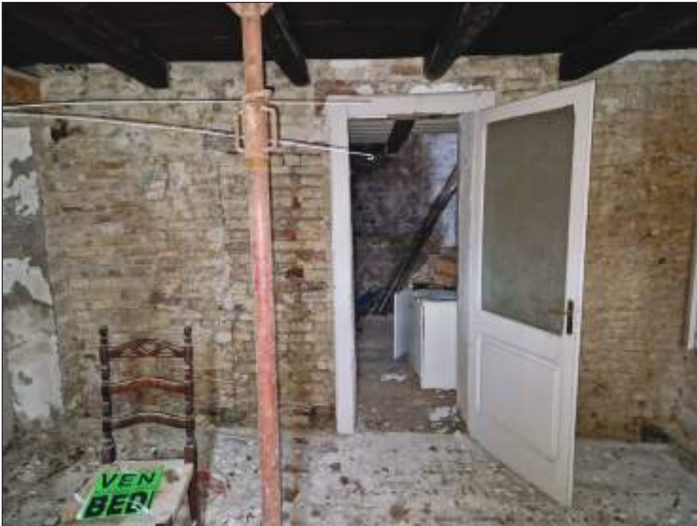
Foto 26: piano terra (stanza lato nord)
