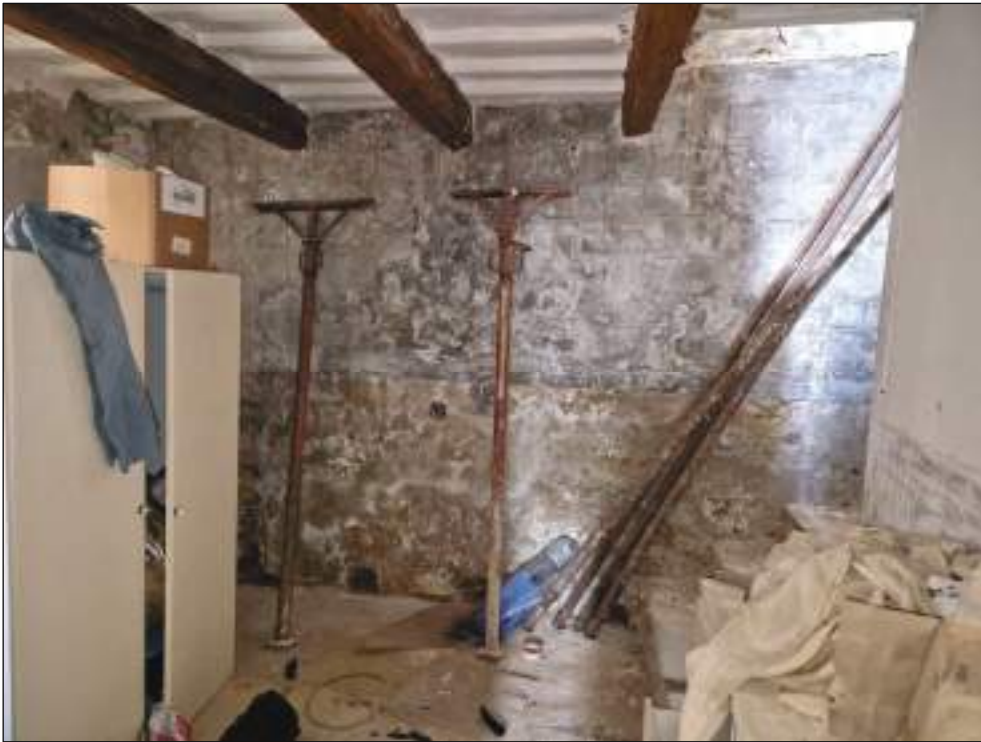
Foto 23: piano terra (stanza lato sud)
