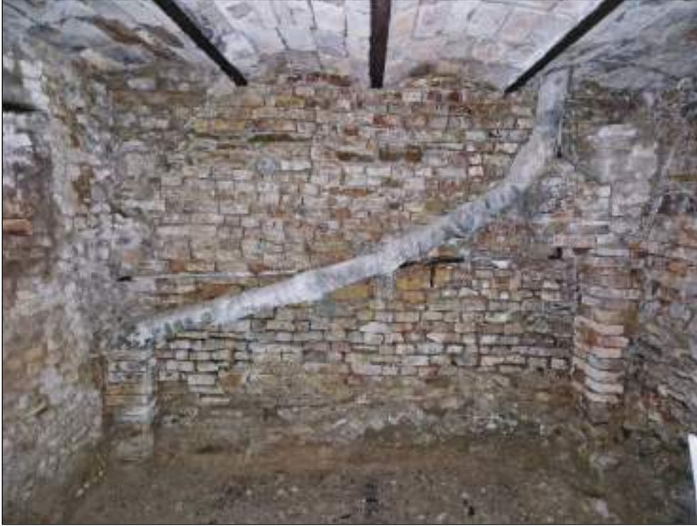
Foto 21: cantina (lato sud) e solaio (soffitto)
