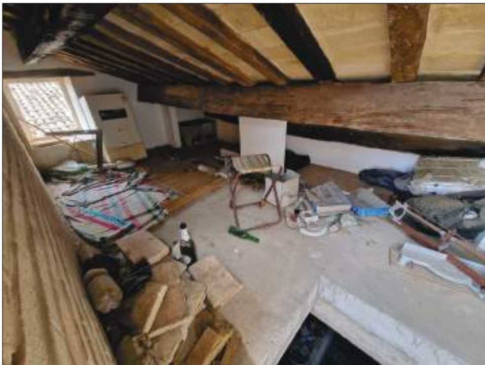
Foto 32: piano secondo (sottotetto)
