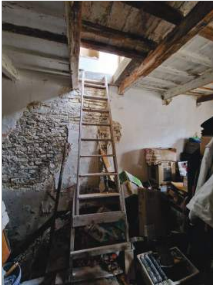
Foto 31: botola per accesso al piano secondo (sottotetto) e terrazza
