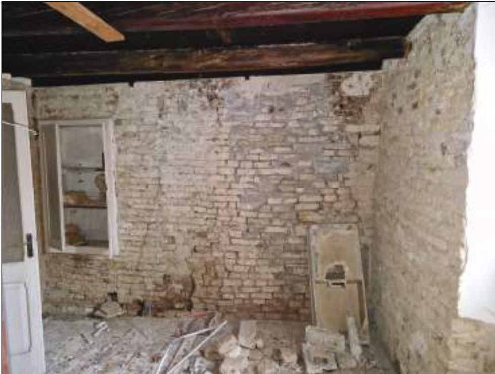
Foto 27: piano terra (stanza lato nord)
