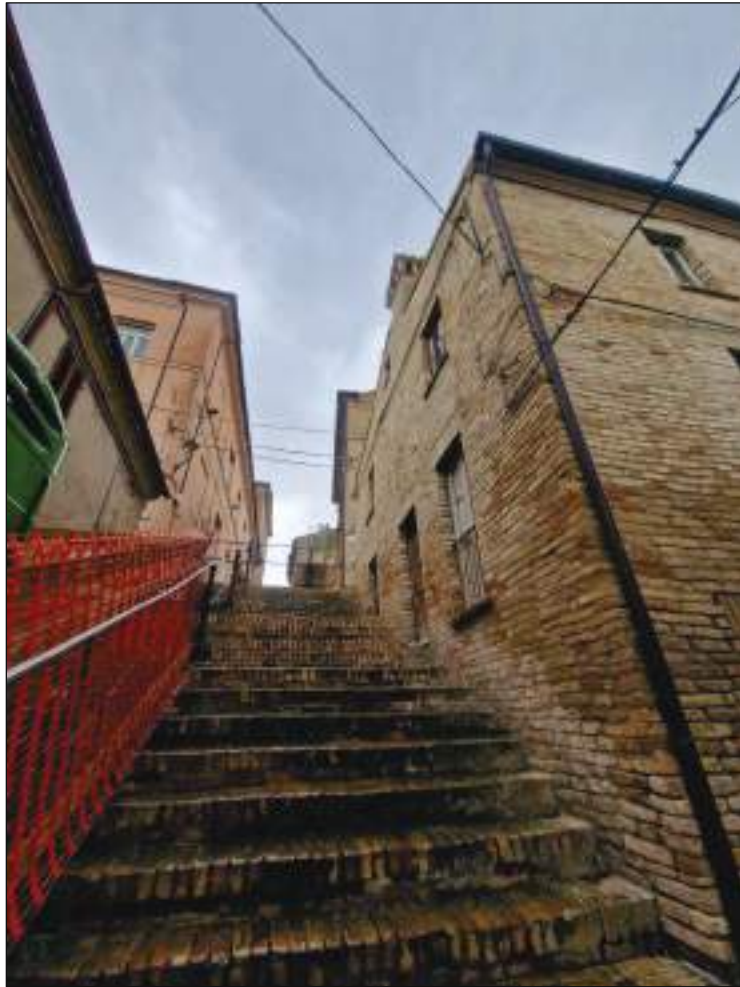
Foto 15: prospetto est (su scalinata Via Sant'Agostino n.18)
