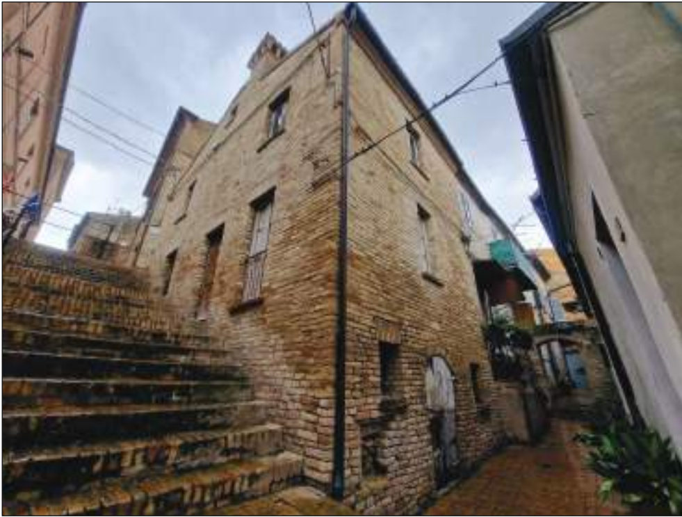
Foto 13: prospetto est (su scalinata Via Sant'Agostino n.18) e prospetto nord
