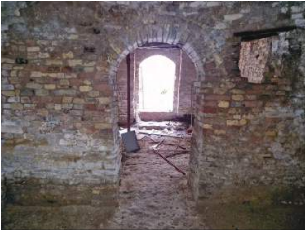
Foto 19: cantina (lato sud)
