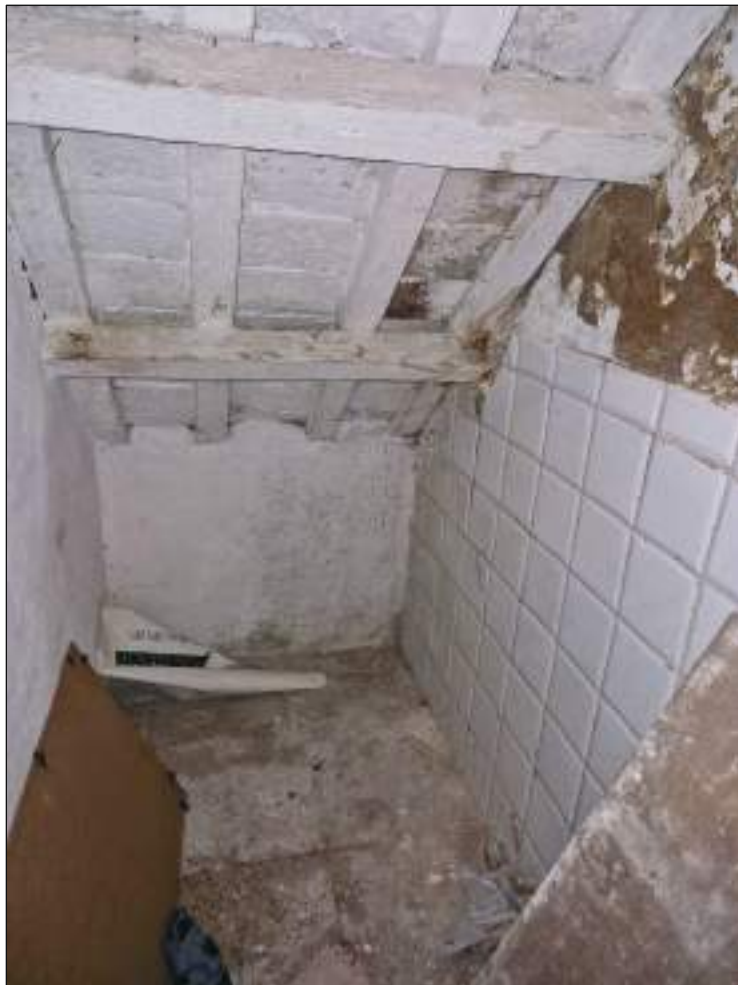
Foto 24: piano terra (sottoscala di collegamento tra piano terra e piano primo)
