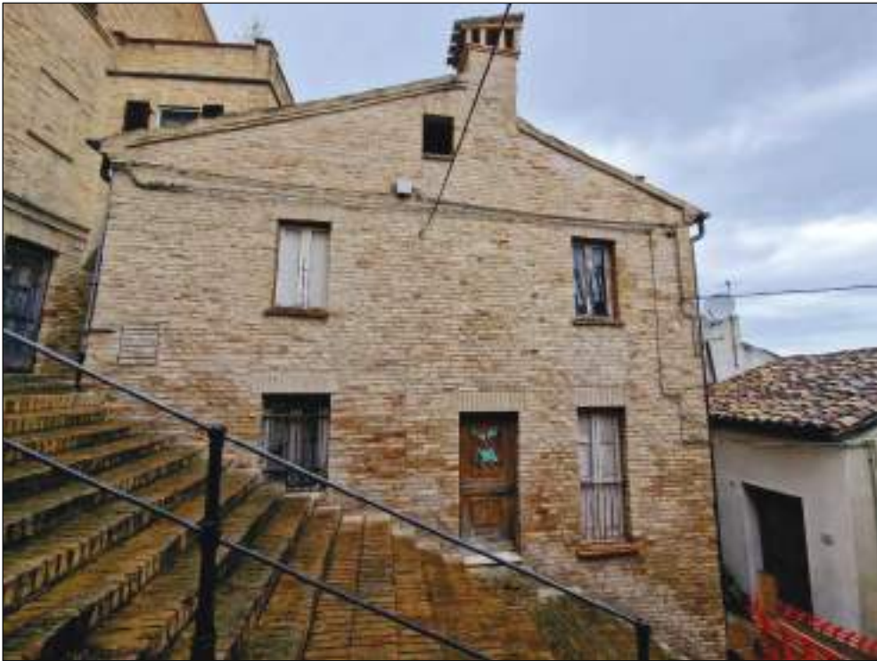
Foto 12: prospetto est (su scalinata Via Sant'Agostino n.18)
