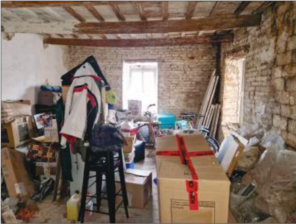
Foto 29: piano primo (vista da lato sud a lato nord)
