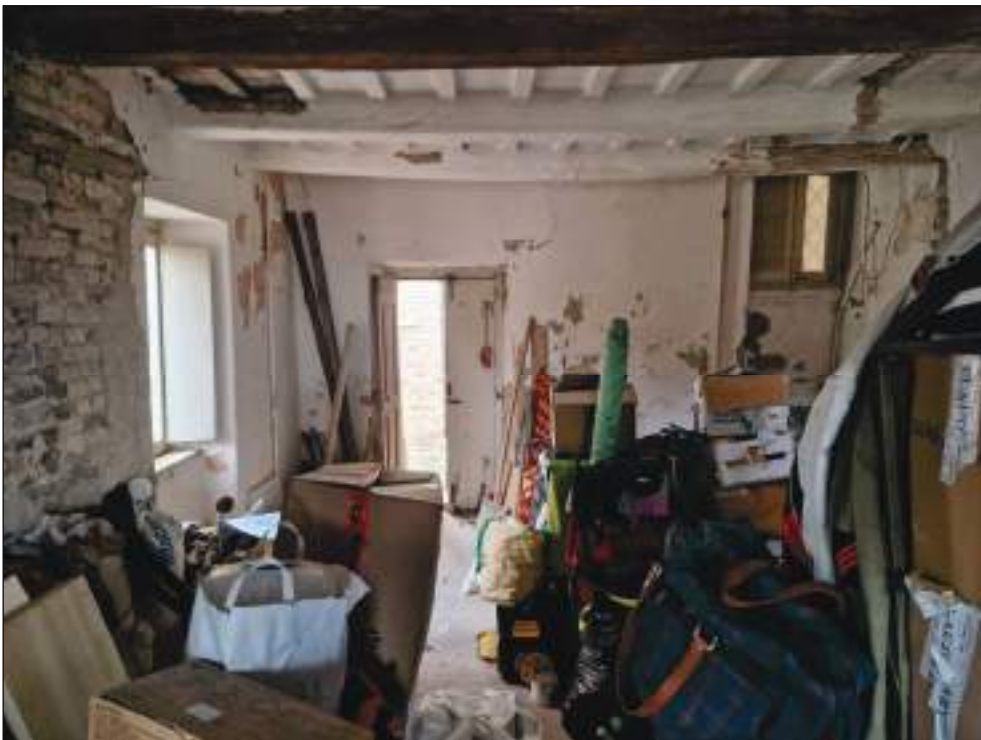
Foto 28: piano primo (vista da lato nord a lato sud) e ingresso principale Vicolo del Forno n. 15
