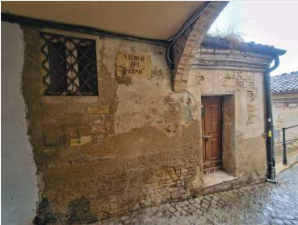
Foto 9: prospetto sud (su Vicolo del Forno)
