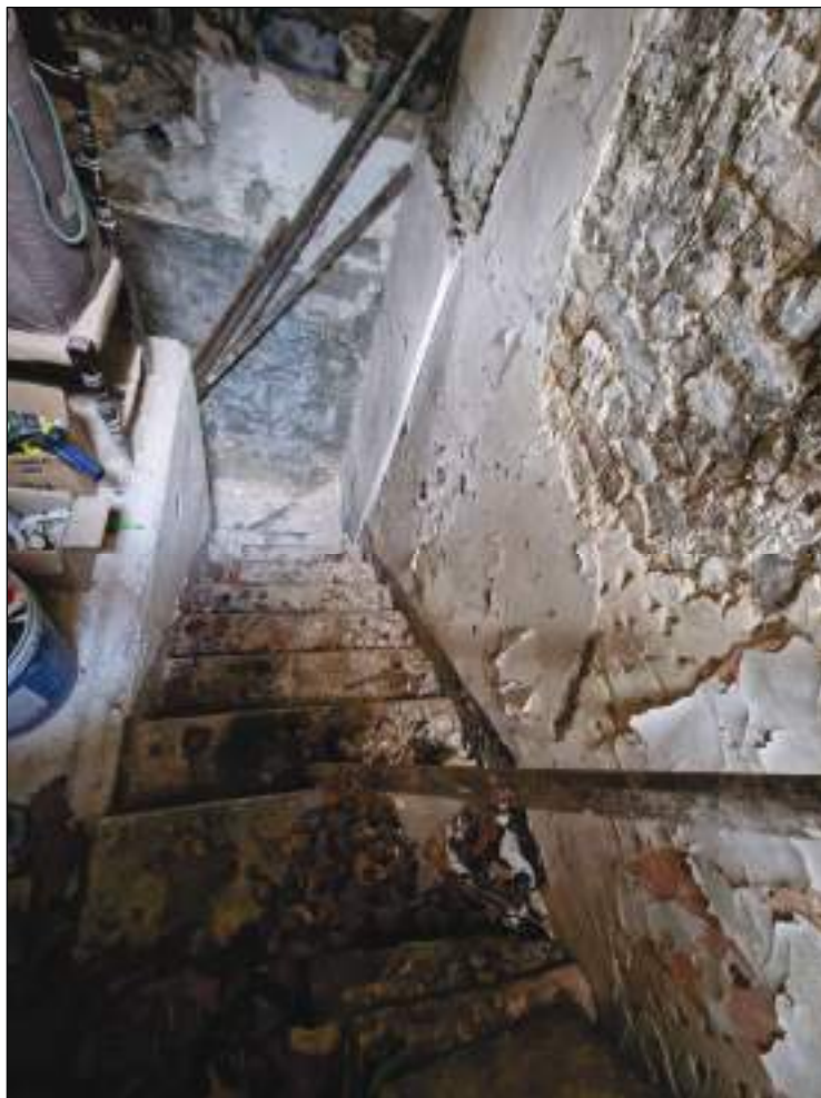
Foto 30: scala di collegamento piano primo - piano terra
