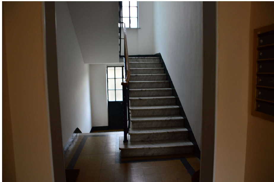
SCALA INGRESSO CONDOMINIO
