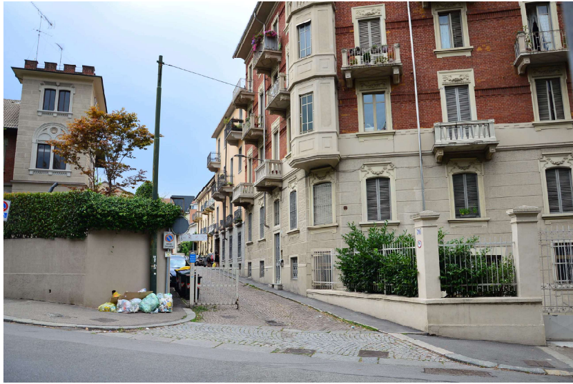
ACCESSO ALLA VIA INTERNA DA C.SO SVIZZERA
