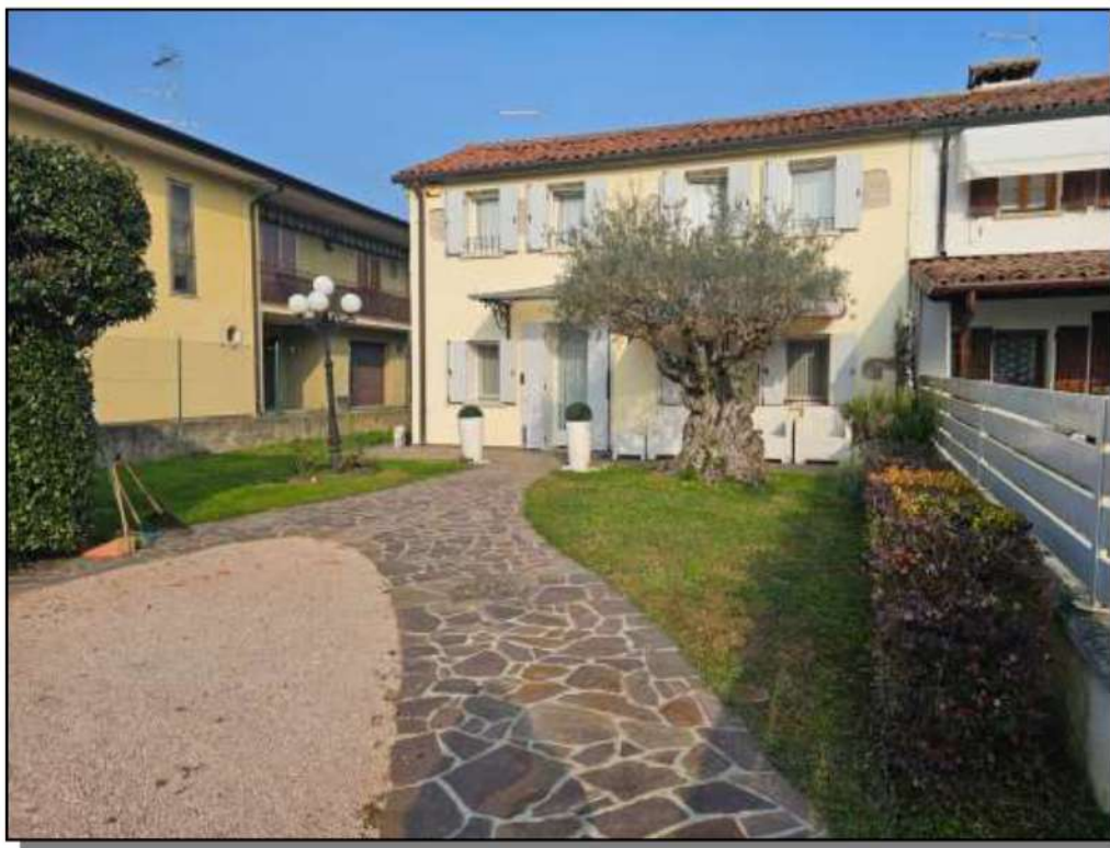
Veduta del fronte principale dell'immobile oggetto di esecuzione immobiliare.
