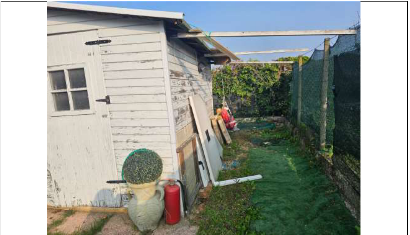
28 Vista dell'angolo Sud-Est del deposito attrezzi;
