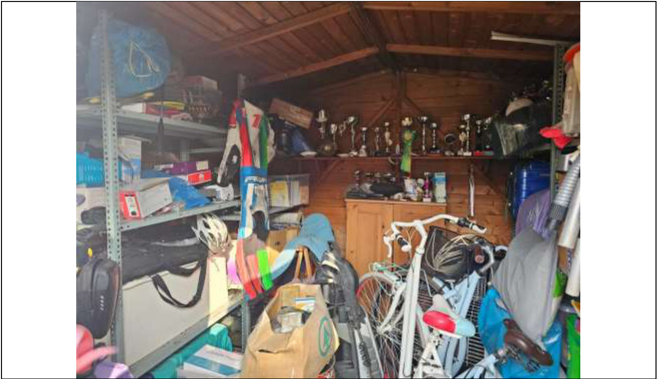
27 Vista interna del deposito attrezzi edificato in abuso;
