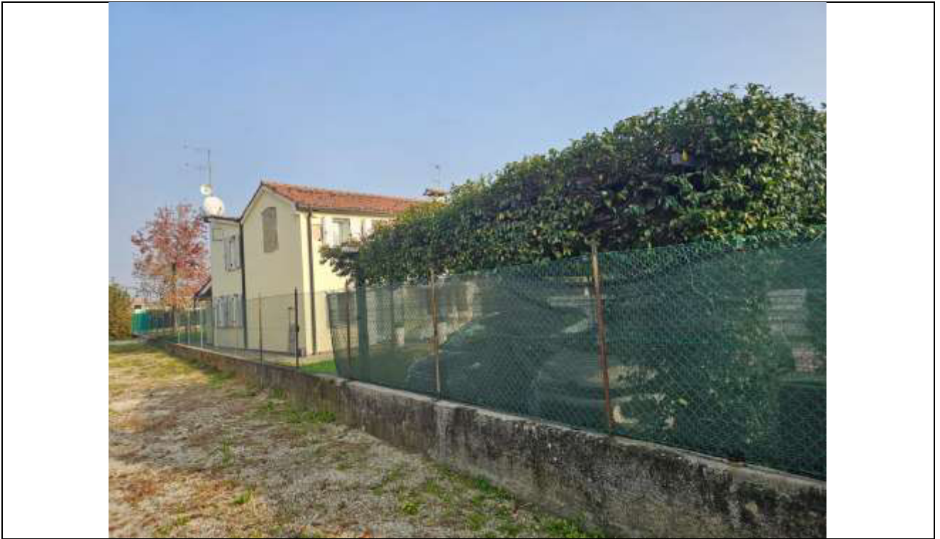
09 Vista del confine a Ovest, verso la pergola autorizzata, si vede anche il prospetto ovest dell'abitazione oggetto di valutazione e dell'andamento della copertura;
