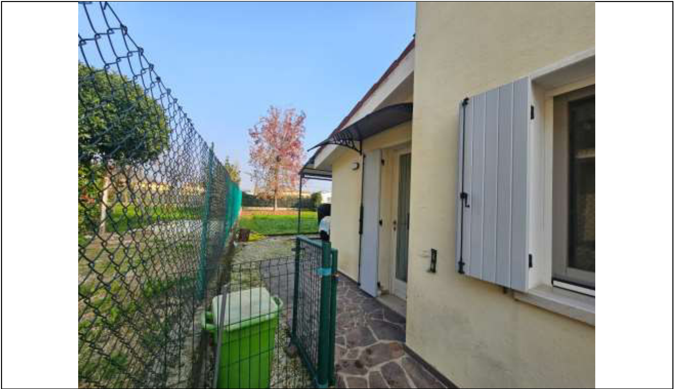
15 Vista di porzione del prospetto Ovest dell'abitazione, si nota la pensilina a protezione della porta di accesso, abusiva, oggetto di rimozione;
