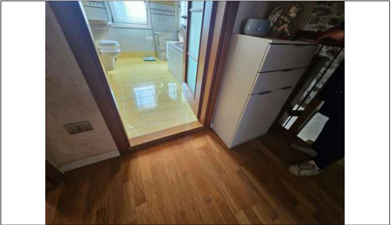
45 Particolare dello scalino per l'accesso al bagno;
