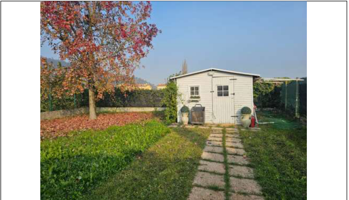
26 Vista del deposito attrezzi edificata in abuso, oggetto di rimozione;
