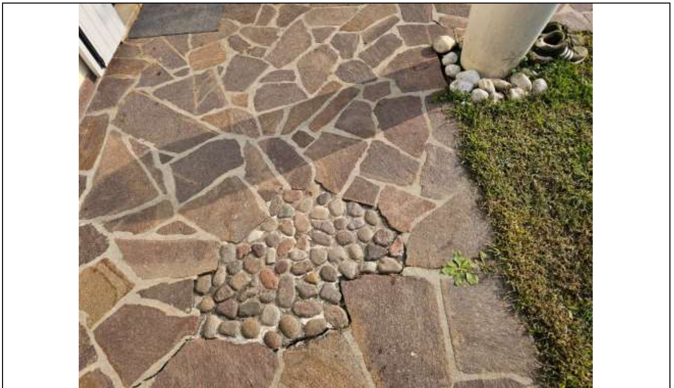
14 Particolare del marciapiede dell'abitazione con due distinti materiali e metodo di posa degli stessi;
