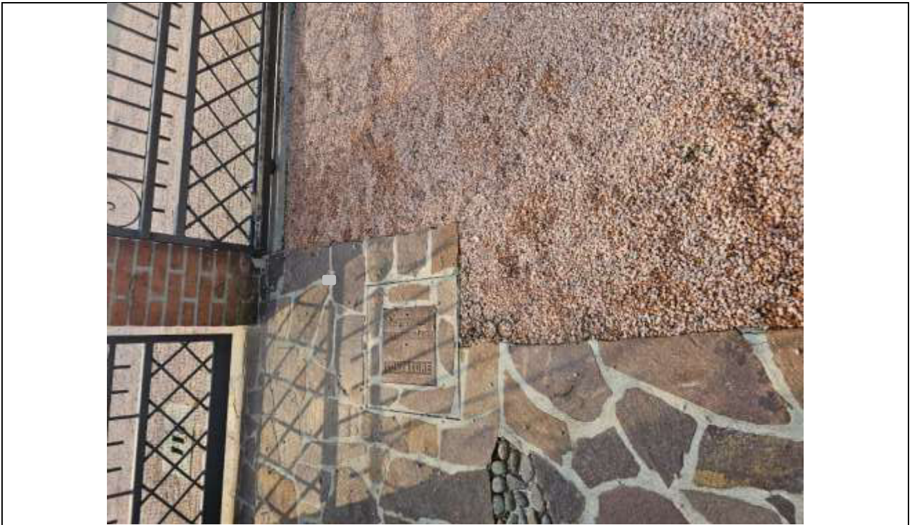
06 Particolare del tombino posto in prossimità all'accesso pedonale e delle pavimentazioni dell'area esterna;
