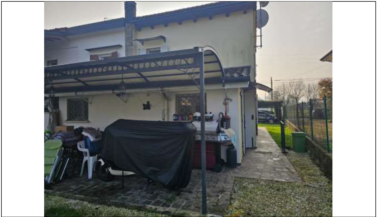
17 Vista del fronte Nord, si nota la pergola metallica e le pensiline a protezione di porte e finestre, abusive, oggetto di rimozione; si notano inoltre le macchie sulla parete esterna, al piano primo;
