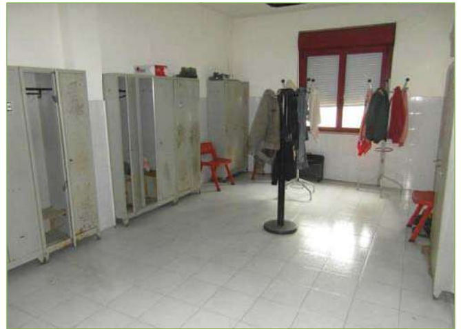
Foto n° 47: Palazzina – P. Terra – Spogliatoio
