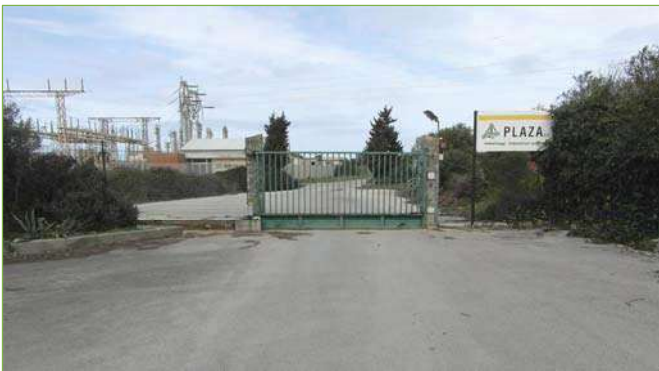
Foto n° 8: Cannello carrabile lato Nord
