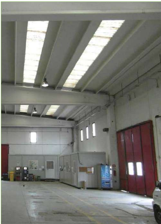
Foto n° 95: Capannone di nuova edificazione – Interno
