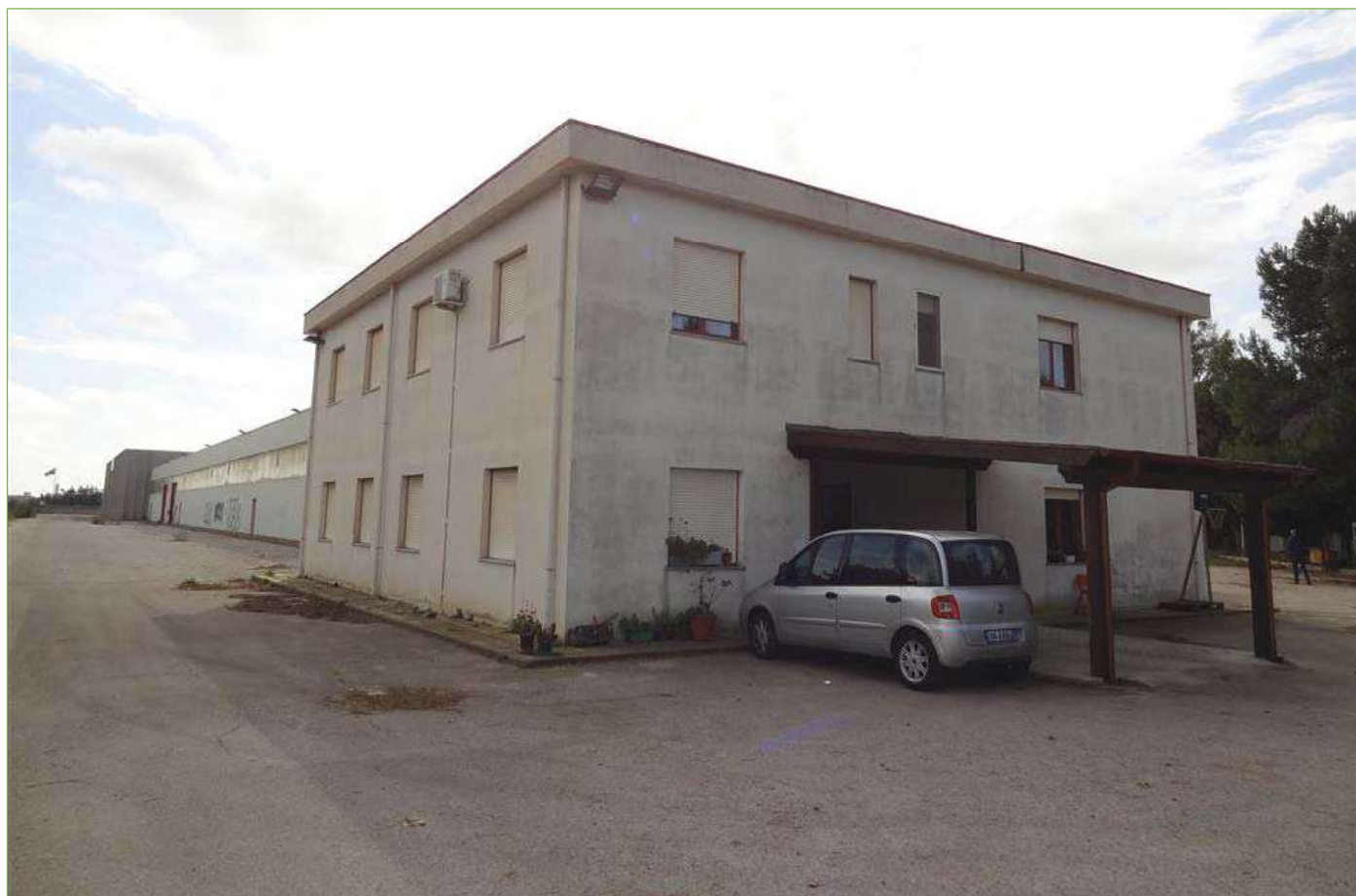
Foto n° 3: Vista del fabbricato dall'ingresso Nord
