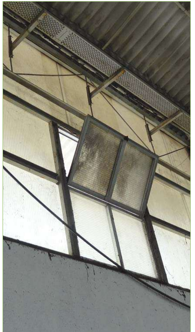
Foto n° 39: Capannone principale – Finestratura
