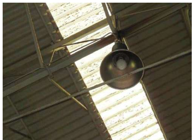
Foto n° 28: Capannone principale – Manto di copertura
