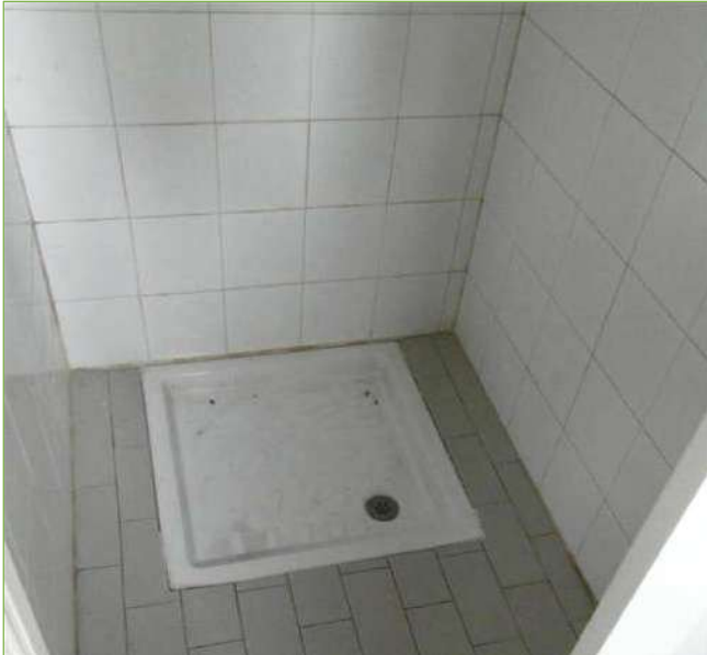
Foto n° 51: Palazzina – P. Terra – Servizi igienici
