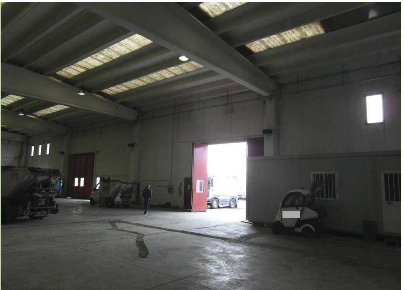
Foto n° 93: Capannone di nuova edificazione (Sub.4) – Portelloni lato Ovest
