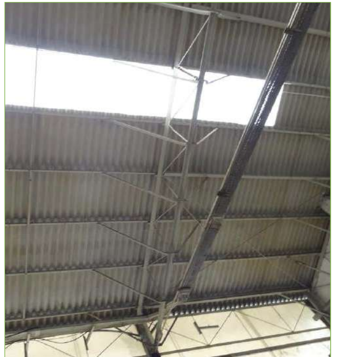
Foto n° 27: Capannone principale – Struttura di copertura
