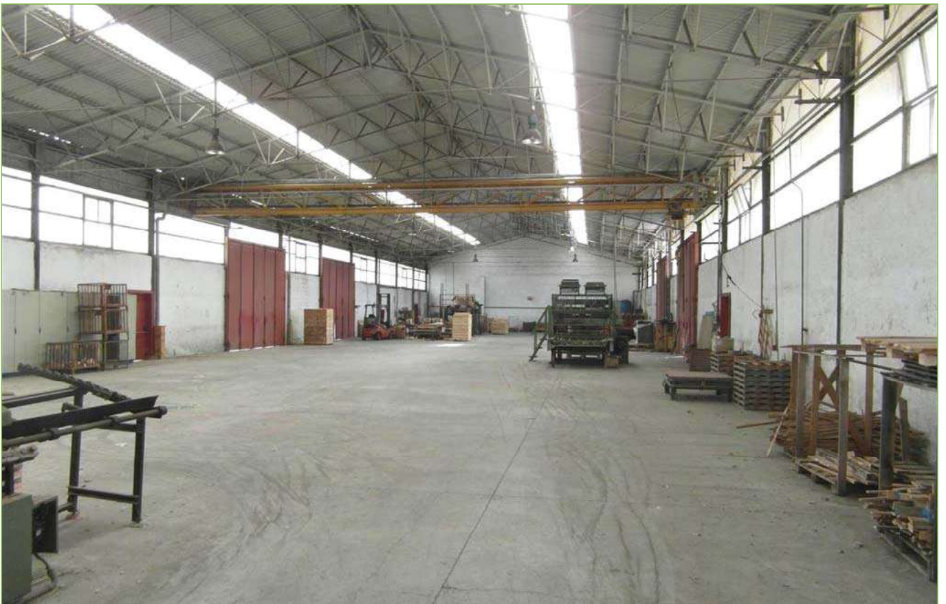
Foto n° 30: Capannone principale – Area produzione
