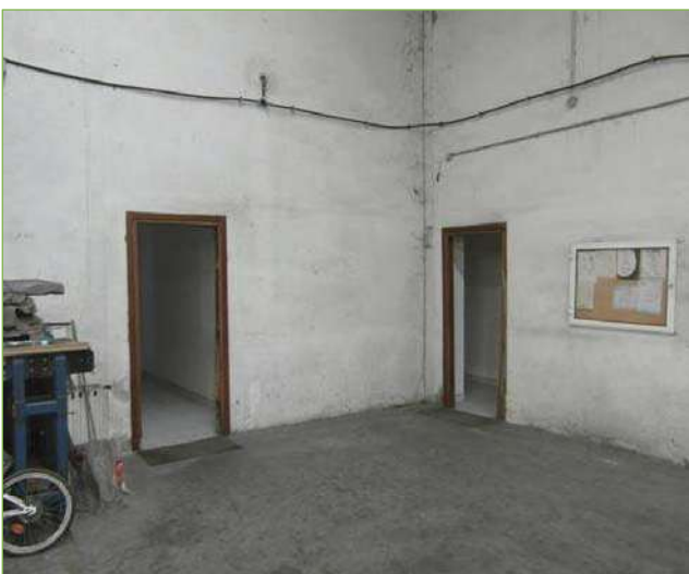
Foto n° 37: Capannone principale – Porte di collegamento alle zone servizi e uffici
