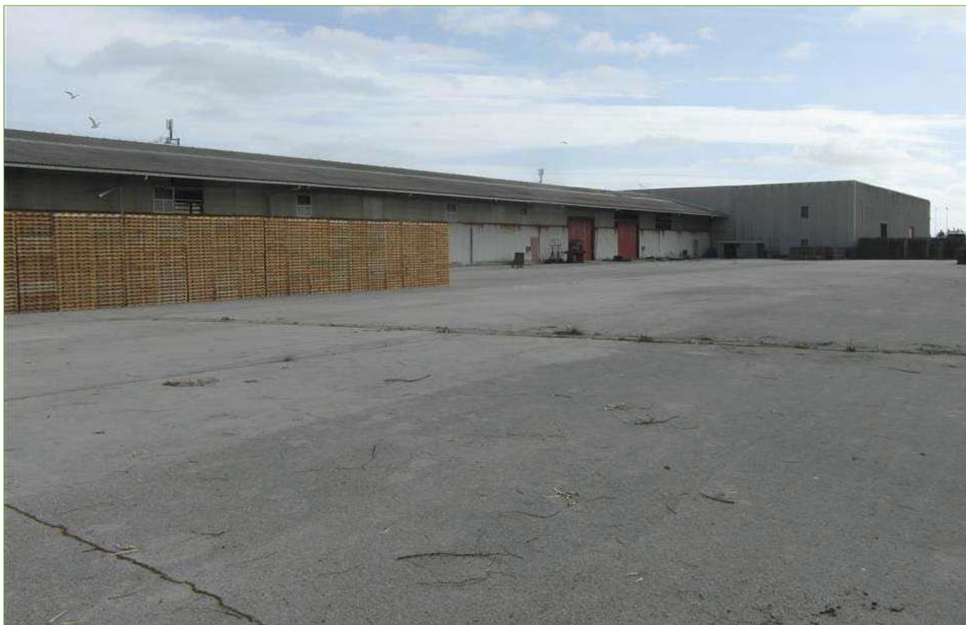
Foto n° 16: Capannone principale – Prospetto Ovest
