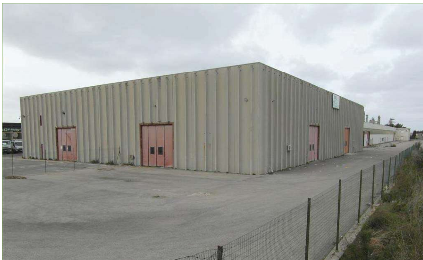
Foto n° 4: Vista del fabbricato da Sud-Est
