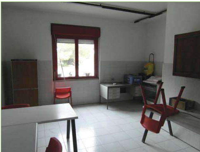
Foto n° 45: Palazzina – P. Terra – Sala mensa
