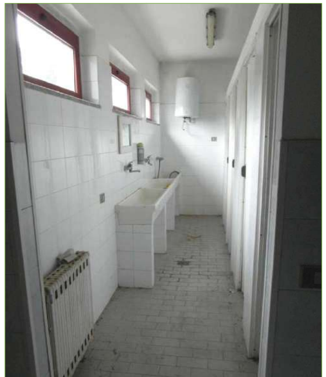
Foto n° 48: Palazzina – P. Terra – Servizi igienici
