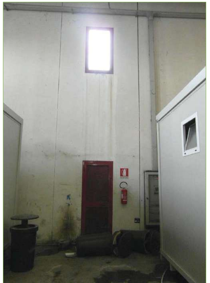
Foto n° 96: Capannone di nuova edificazione – Serramenti lato Nord
