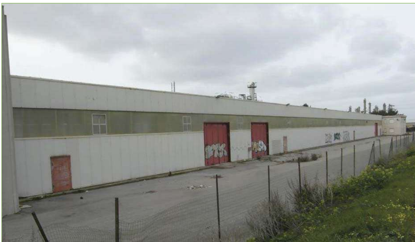
Foto n° 19: Capannone principale – Prospetto Est
