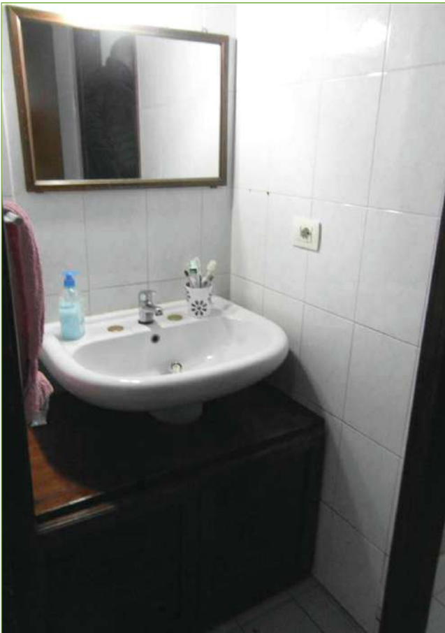
Foto n° 77: Palazzina – Piano I – Antibagno unità lato Ovest (appartamento Custode)
