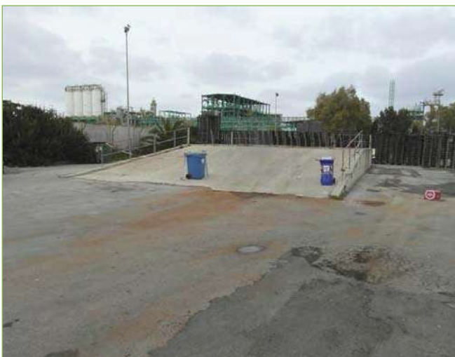
Foto n° 99: Rampa di carico materiali (Sub.4)
