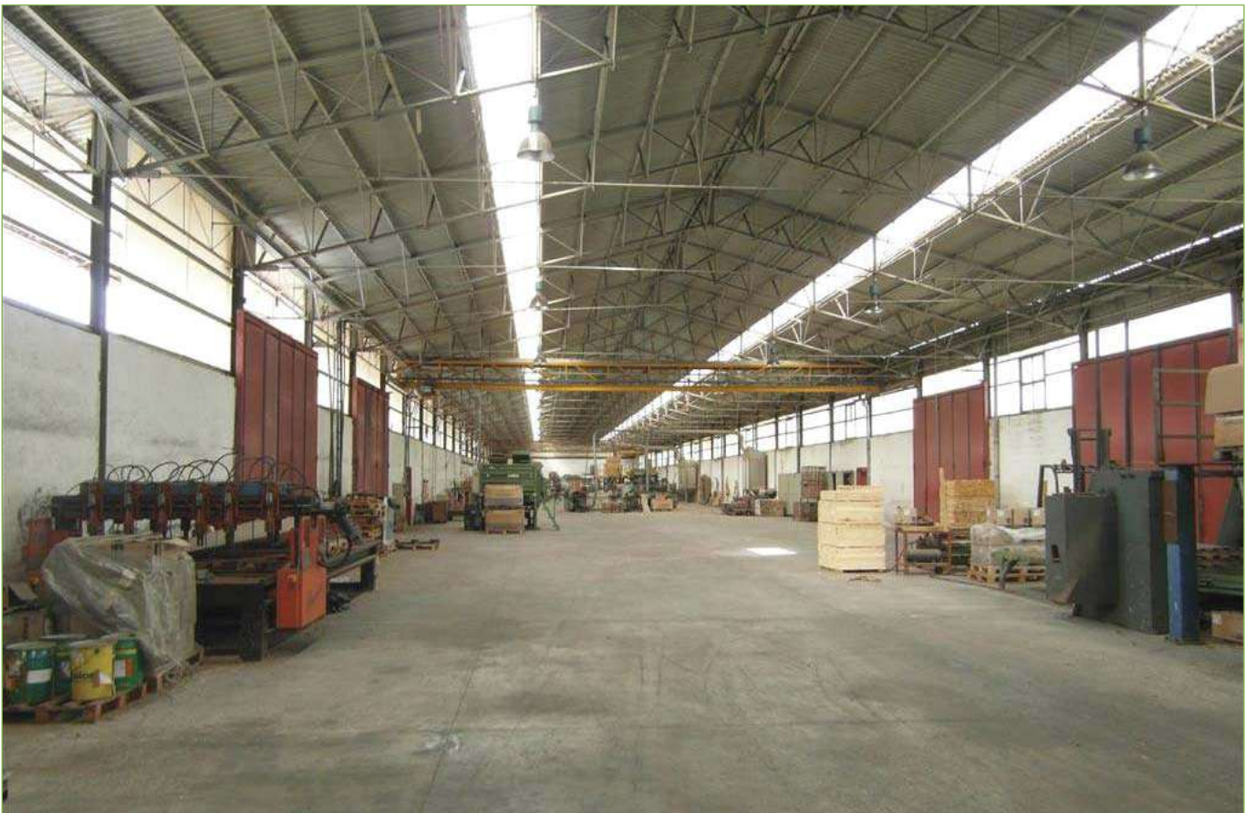
Foto n° 32: Capannone principale – Area produzione
