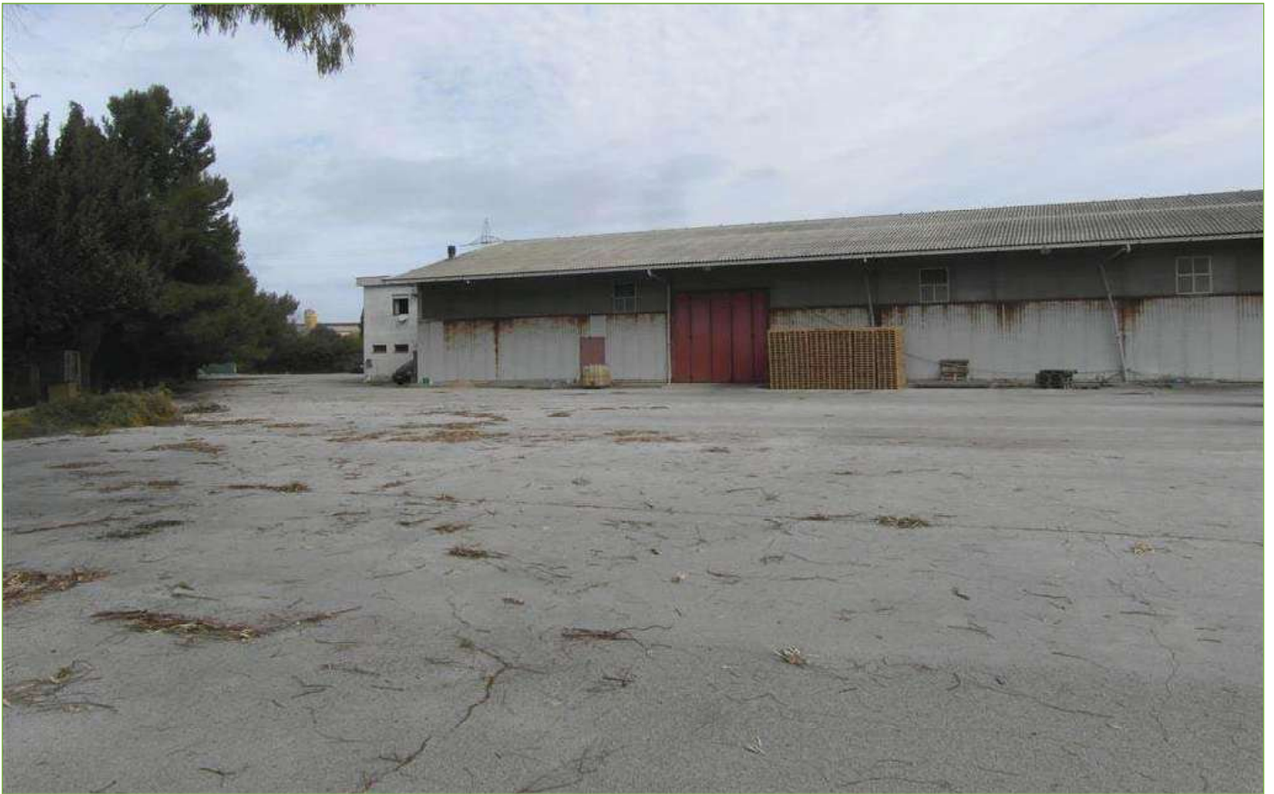
Foto n° 14: Capannone principale – Prospetto Ovest
