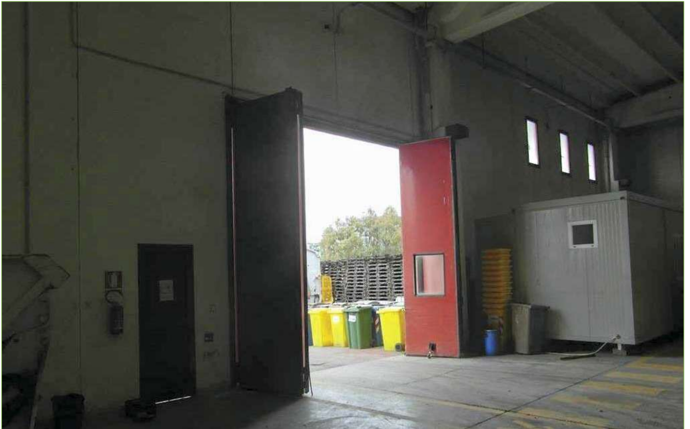
Foto n° 94: Capannone di nuova edificazione (Sub.4) – Portellone di accesso mezzi
