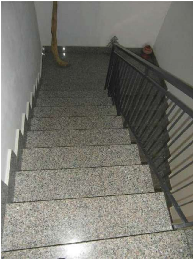
Foto n° 60: Palazzina – Scala interna
