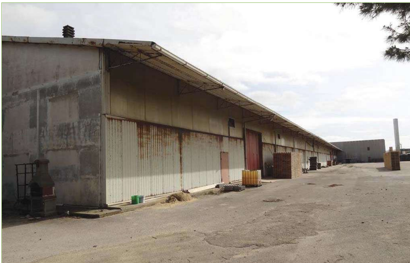
Foto n° 5: Vista del fabbricato da Nord-Ovest
