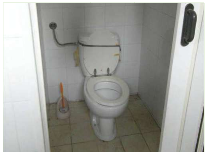
Foto n° 49: Palazzina – P. Terra – Servizi igienici
