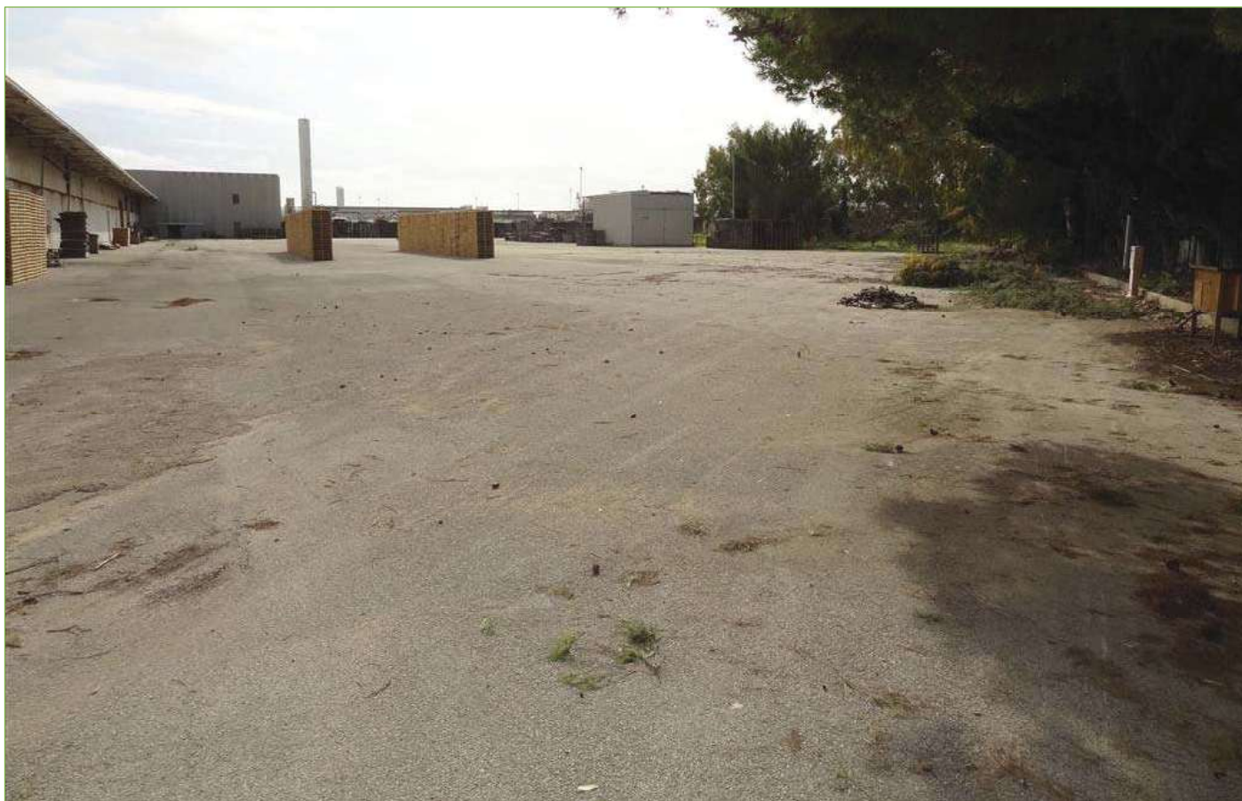
Foto n° 18: Piazzale lato Ovest (Sub.1)
