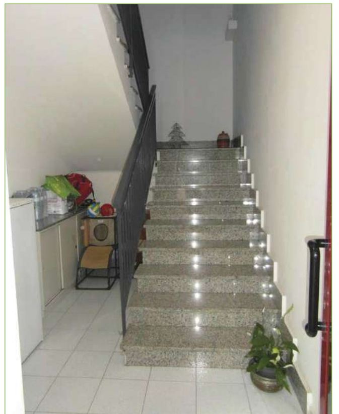
Foto n° 59: Palazzina – Vano scala
