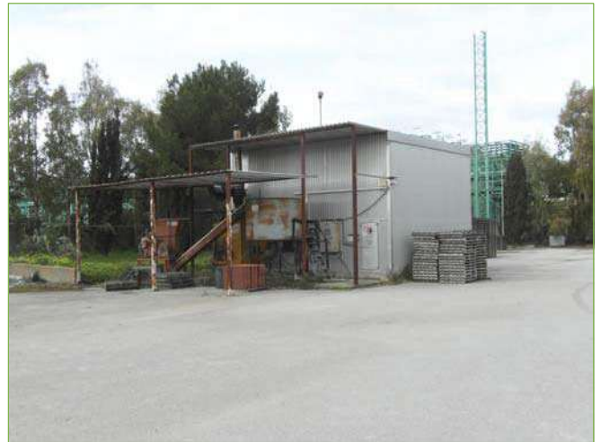
Foto n° 101: Essiccazione e sanificazione legno (Sub.1)
