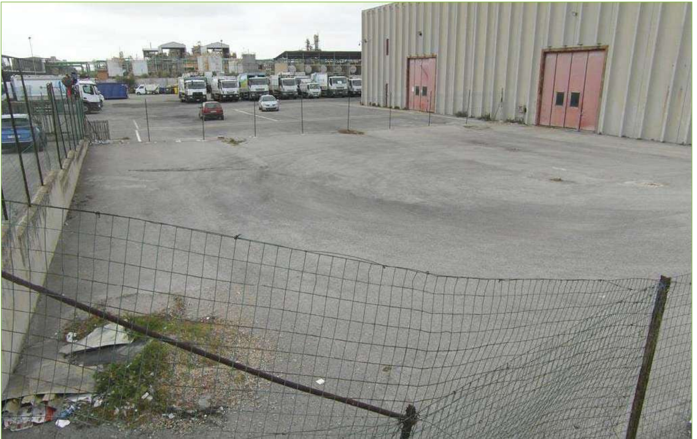
Foto n° 86: Piazzale lato Sud (Sub.5)
