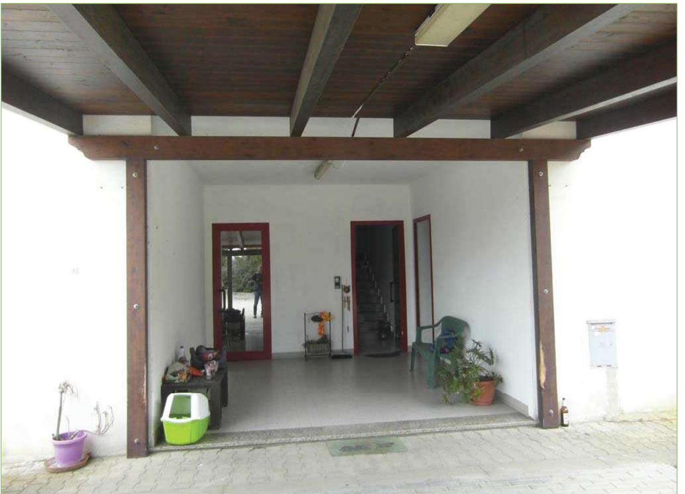
Foto n° 43: Palazzina – Atrio di ingresso
