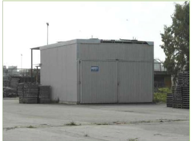
Foto n° 100: Essiccazione e sanificazione legno (Sub.1)
