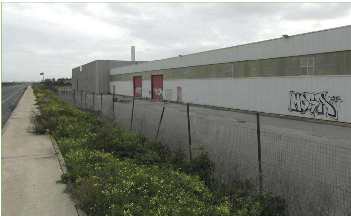
Foto n° 20: Capannone principale – Prospetto Est
