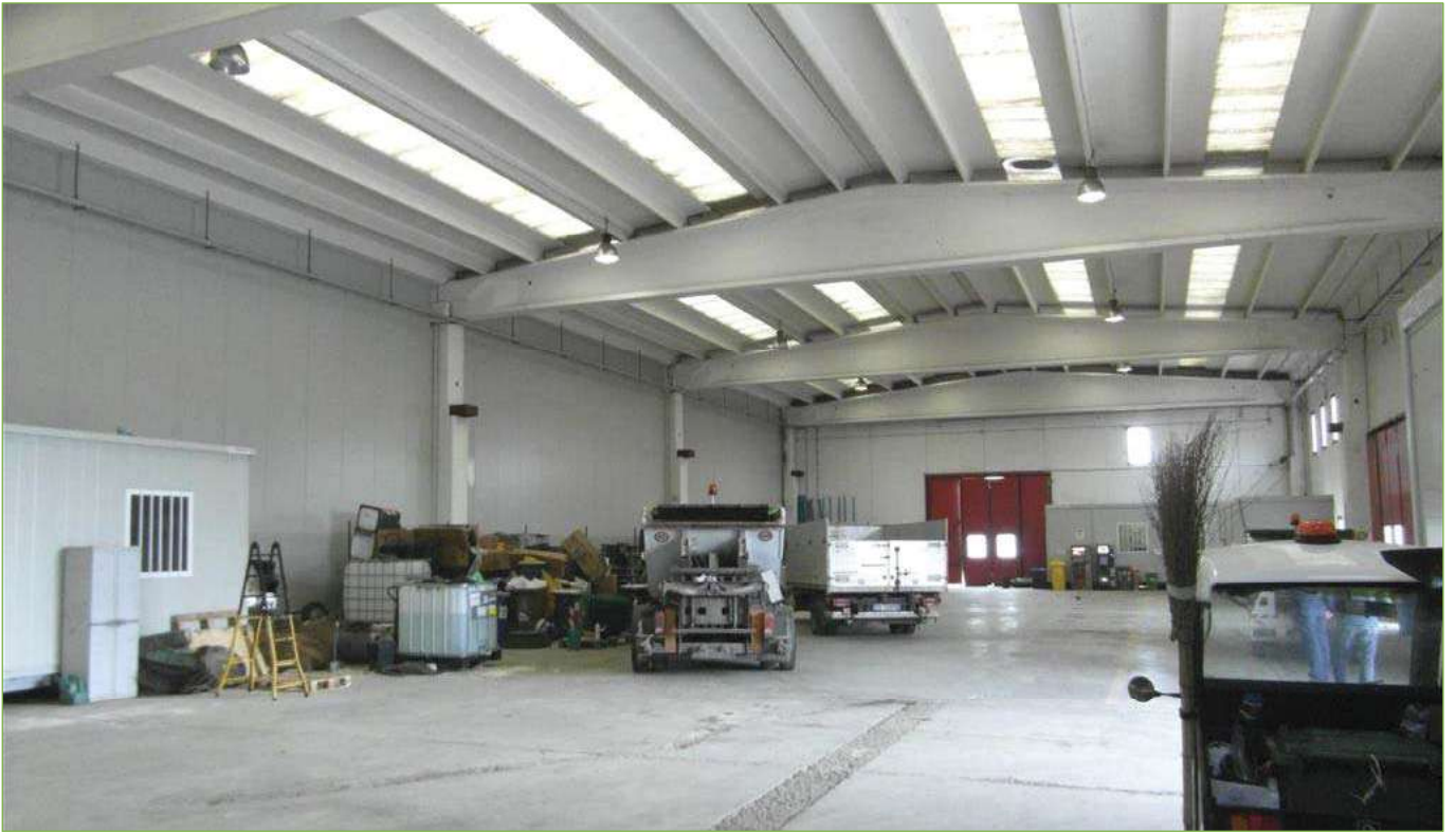
Foto n° 92: Capannone di nuova edificazione (Sub.4) – Interno
