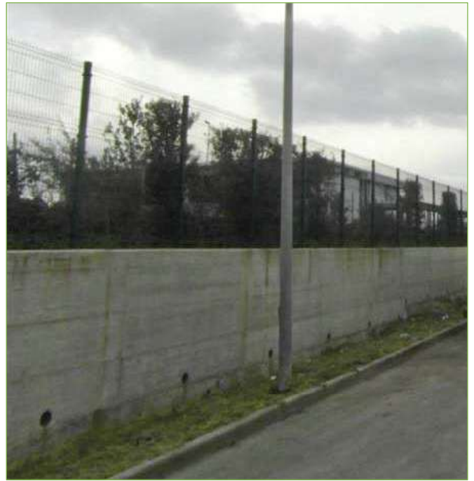
Foto n° 11: Recinzione lato Sud
