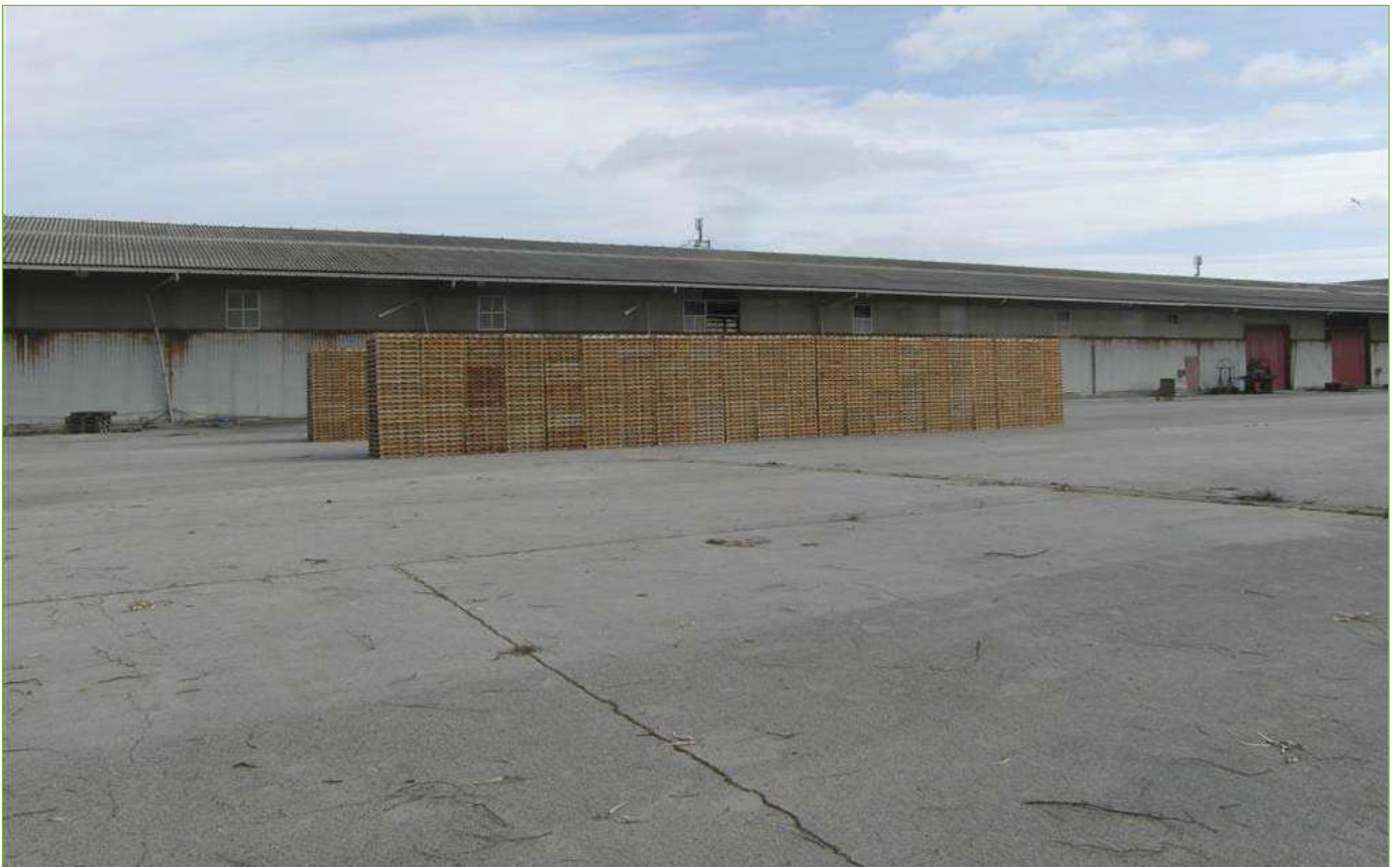
Foto n° 15: Capannone principale – Prospetto Ovest
