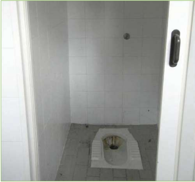
Foto n° 50: Palazzina – P. Terra – Servizi igienici
