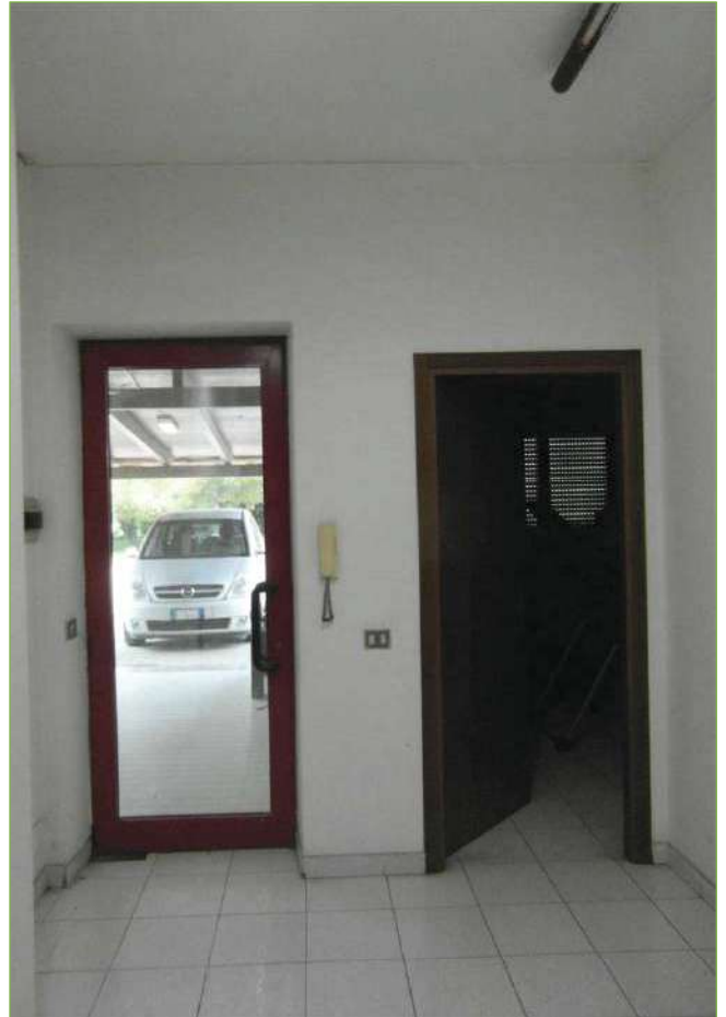
Foto n° 53: Palazzina – P. Terra – Ingresso zona uffici
