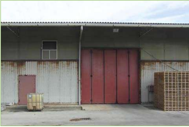
Foto n° 22: Capannone principale – Facciata lato Ovest
