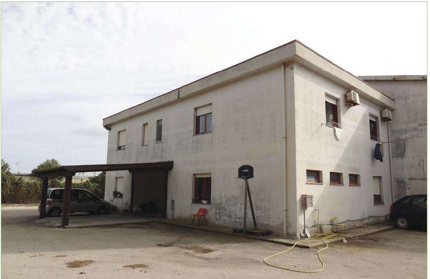
Foto n° 41: Palazzina – Prospetti Nord e Ovest
