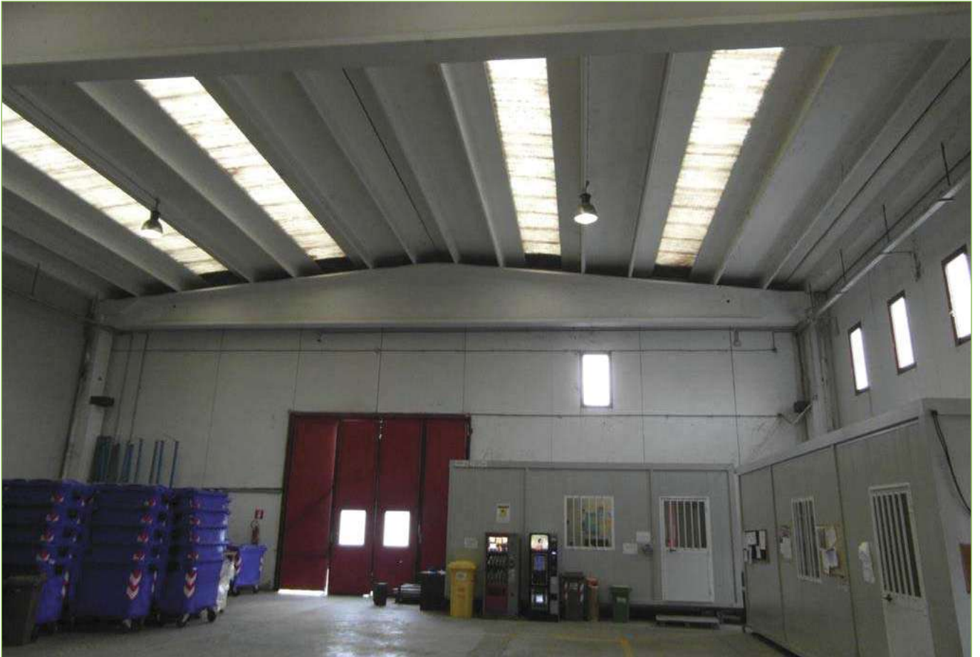
Foto n° 90: Capannone di nuova edificazione (Sub.4) – Interno
