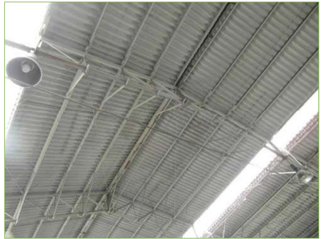
Foto n° 26: Capannone principale – Struttura di copertura
