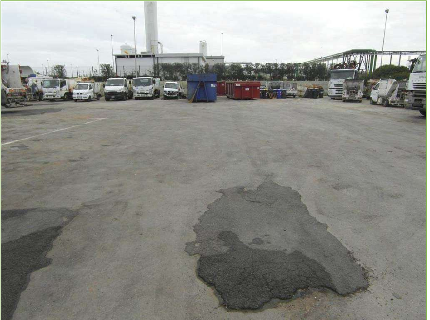
Foto n° 88: Piazzale lato Ovest (Sub.4)
