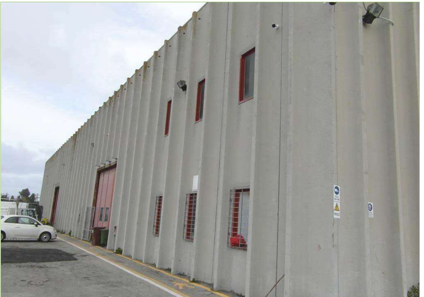
Foto n° 83: Capannone di nuova edificazione – Prospetto Ovest
