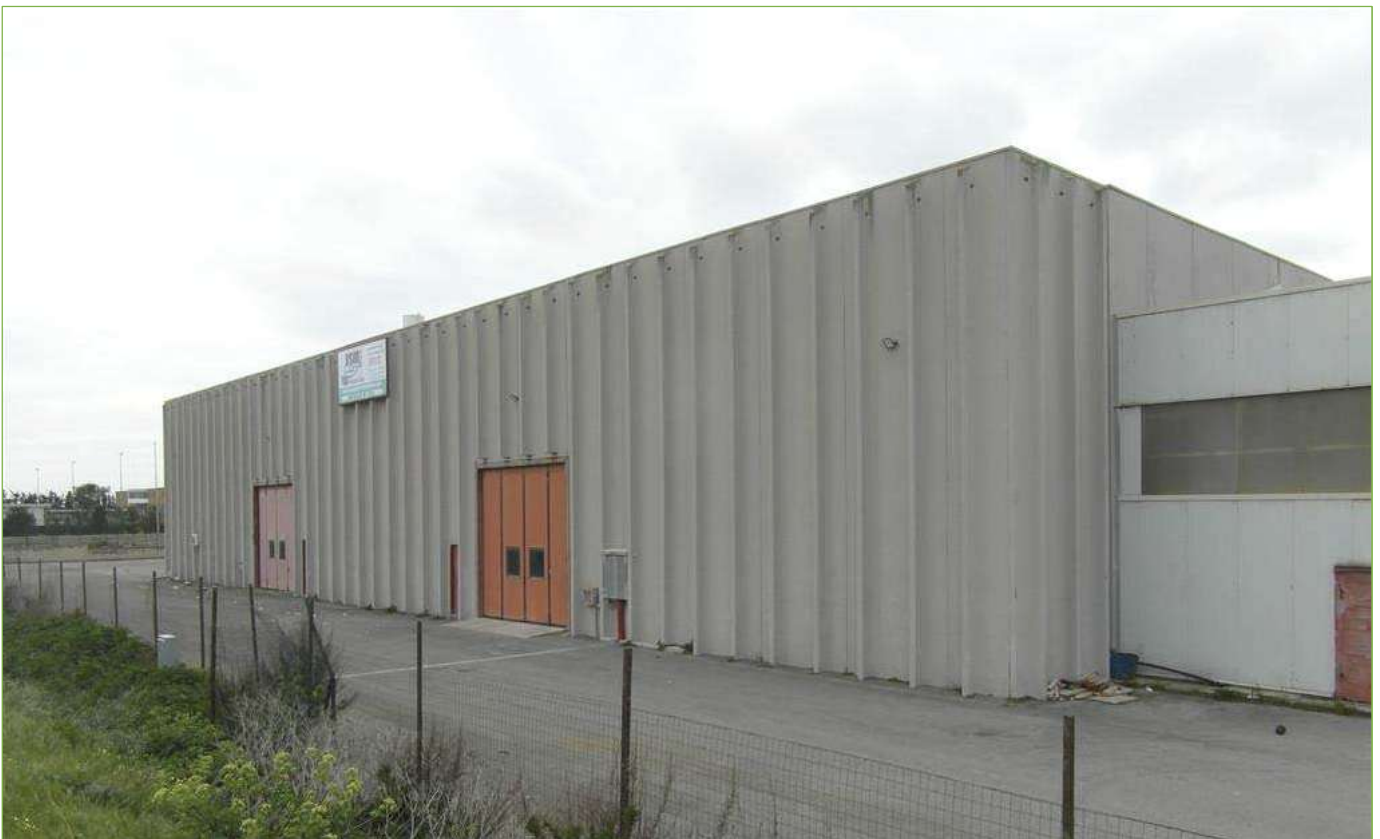
Foto n° 85: Capannone di nuova edificazione – Prospetto Est
