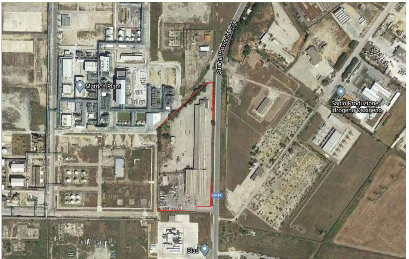
Foto n° 2: Vista aerea del compendio industriale in esame (fonte Google Maps – immagine anno 2020)
