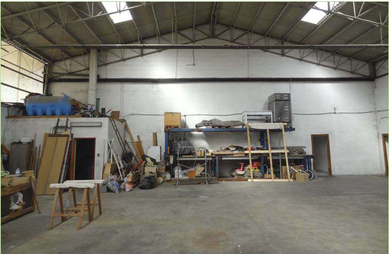
Foto n° 34: Capannone principale – Lato Nord
