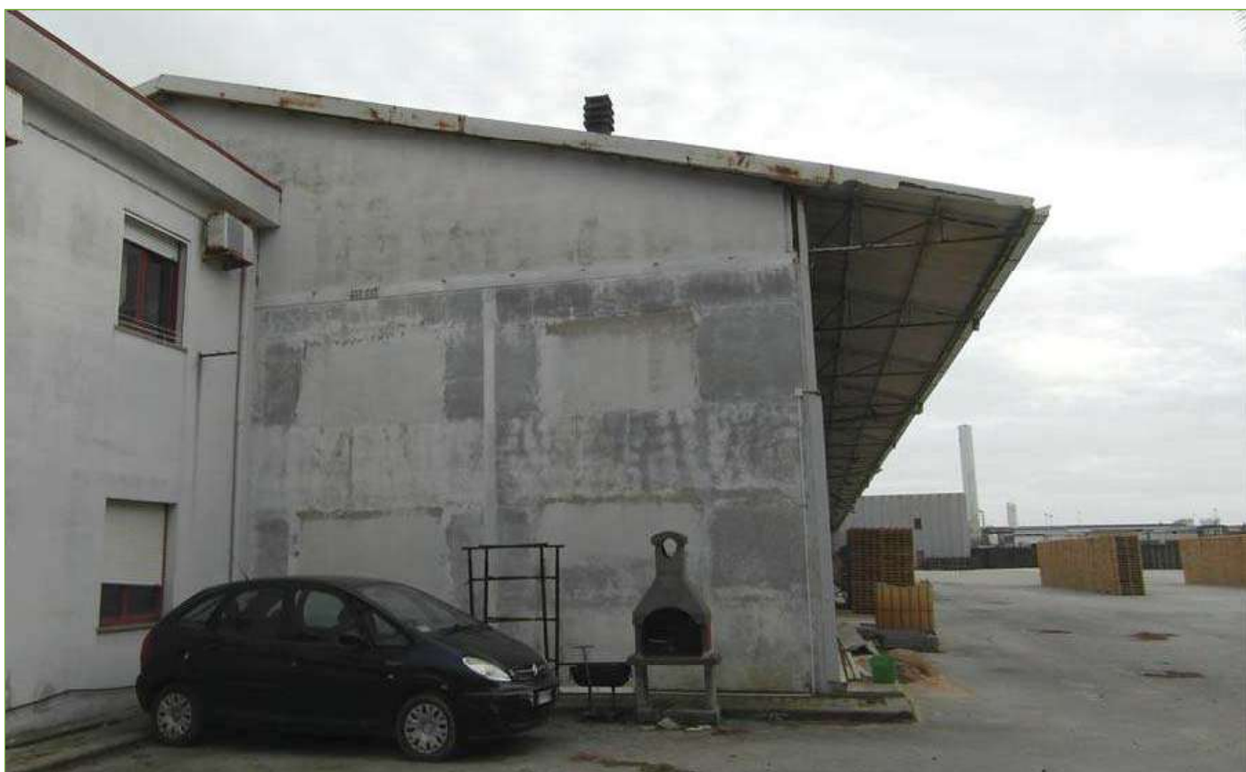
Foto n° 17: Capannone principale – Prospetto Nord
