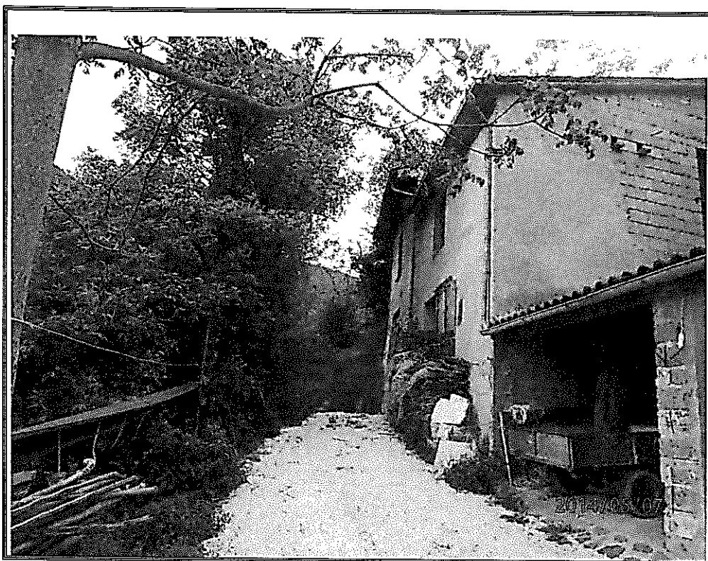
Foto n. 23 CT Nocera Umbra Foglio n. 19 part. 736 Strada di accesso a Fabb. Rurale Collabente
