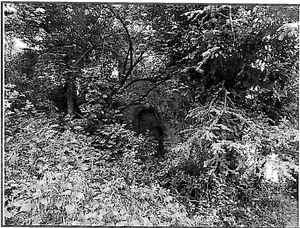
Foto n. 24 CT Nocera Umbra Foglio n. 19 part. 736 Fabbicato Rurale Collabente
