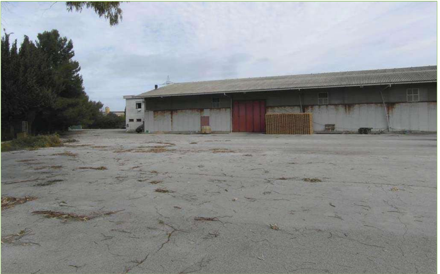
Foto n° 14: Capannone principale – Prospetto Ovest
