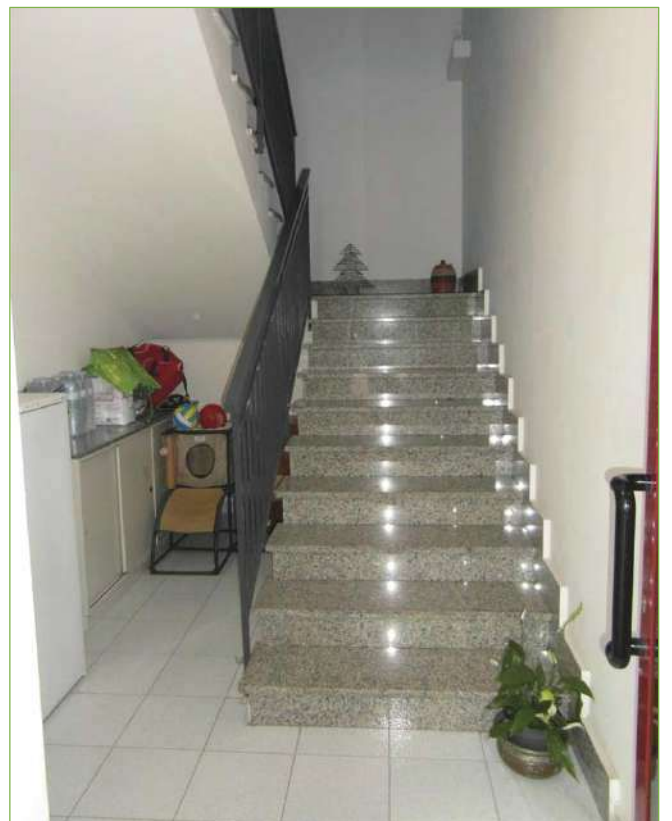
Foto n° 59: Palazzina – Vano scala
