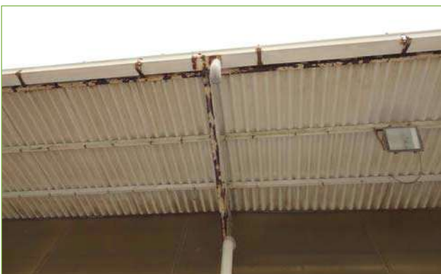
Foto n° 25: Capannone principale – Aggetto copertura
