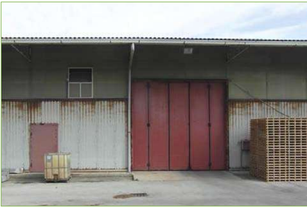
Foto n° 22: Capannone principale – Facciata lato Ovest
