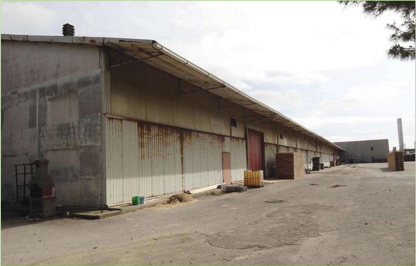
Foto n° 5: Vista del fabbricato da Nord-Ovest
