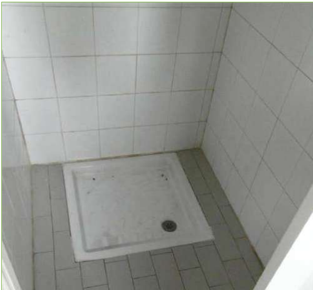
Foto n° 51: Palazzina – P. Terra – Servizi igienici
