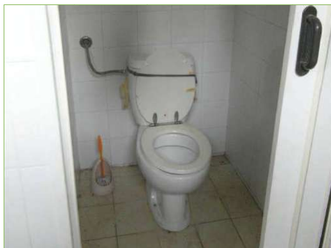
Foto n° 49: Palazzina – P. Terra – Servizi igienici
