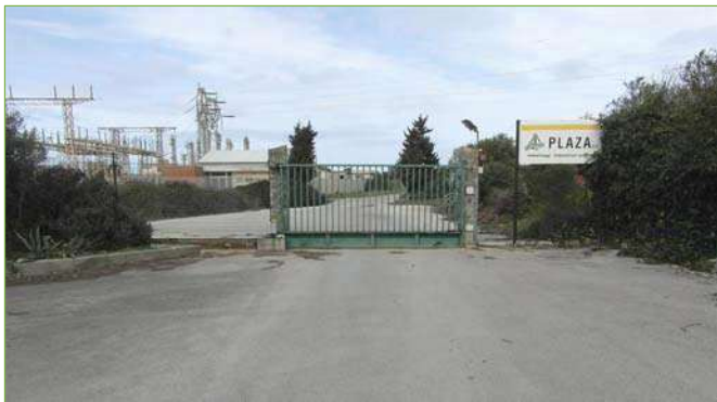
Foto n° 8: Cannello carrabile lato Nord
