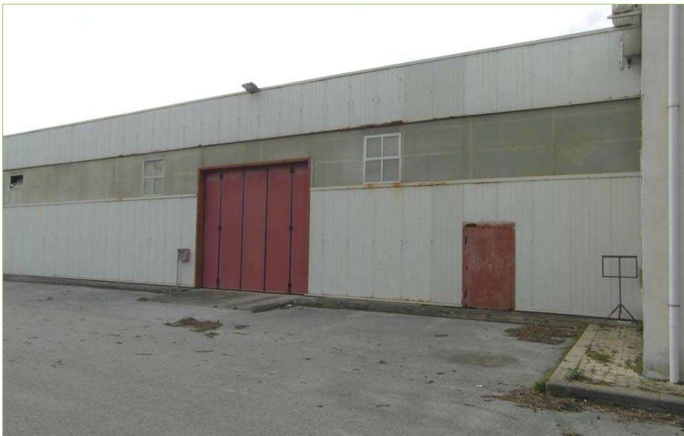
Foto n° 21: Capannone principale – Prospetto Est
