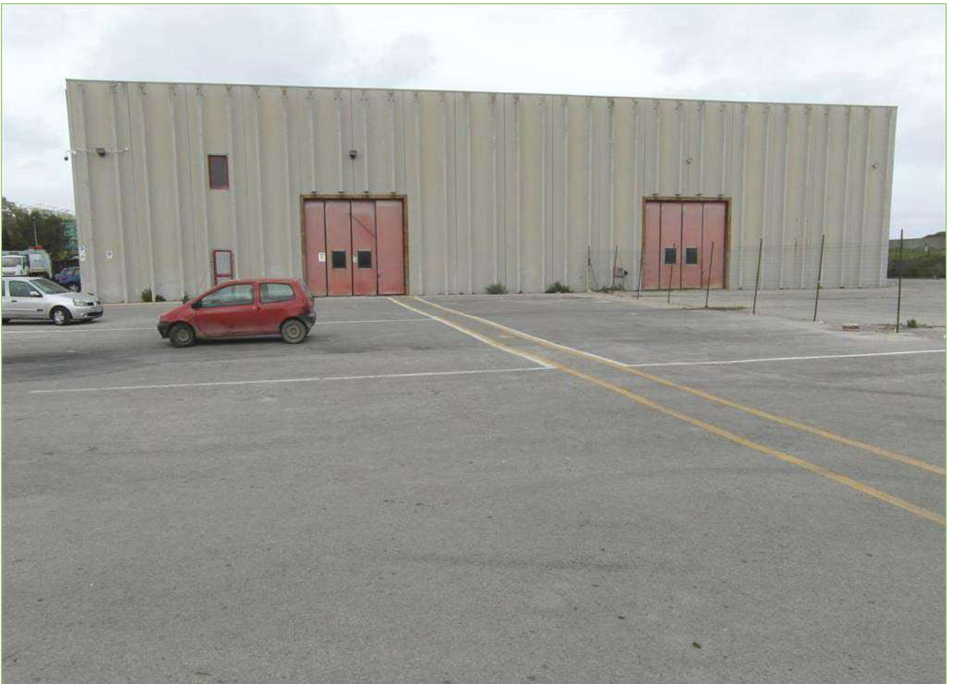
Foto n° 81: Capannone di nuova edificazione – Prospetto Sud
