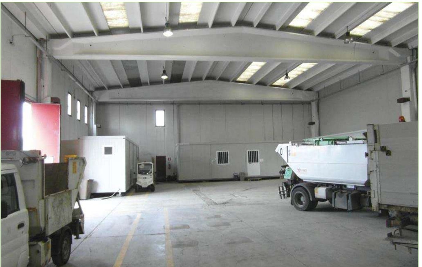
Foto n° 91: Capannone di nuova edificazione (Sub.4) – Interno
