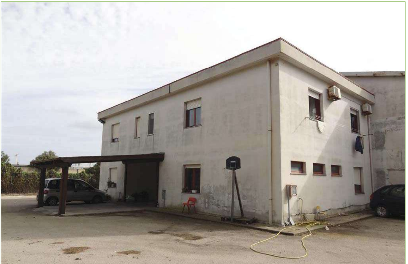
Foto n° 41: Palazzina – Prospetti Nord e Ovest
