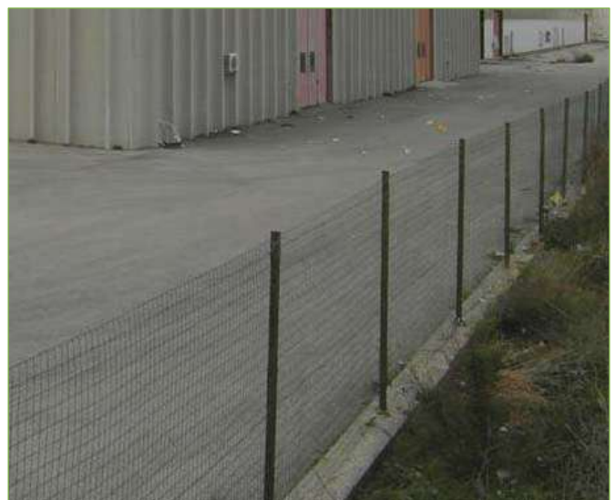
Foto n° 13: Recinzione lato Est
