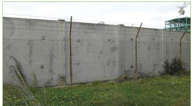
Foto n° 12: Recinzione lato Ovest
