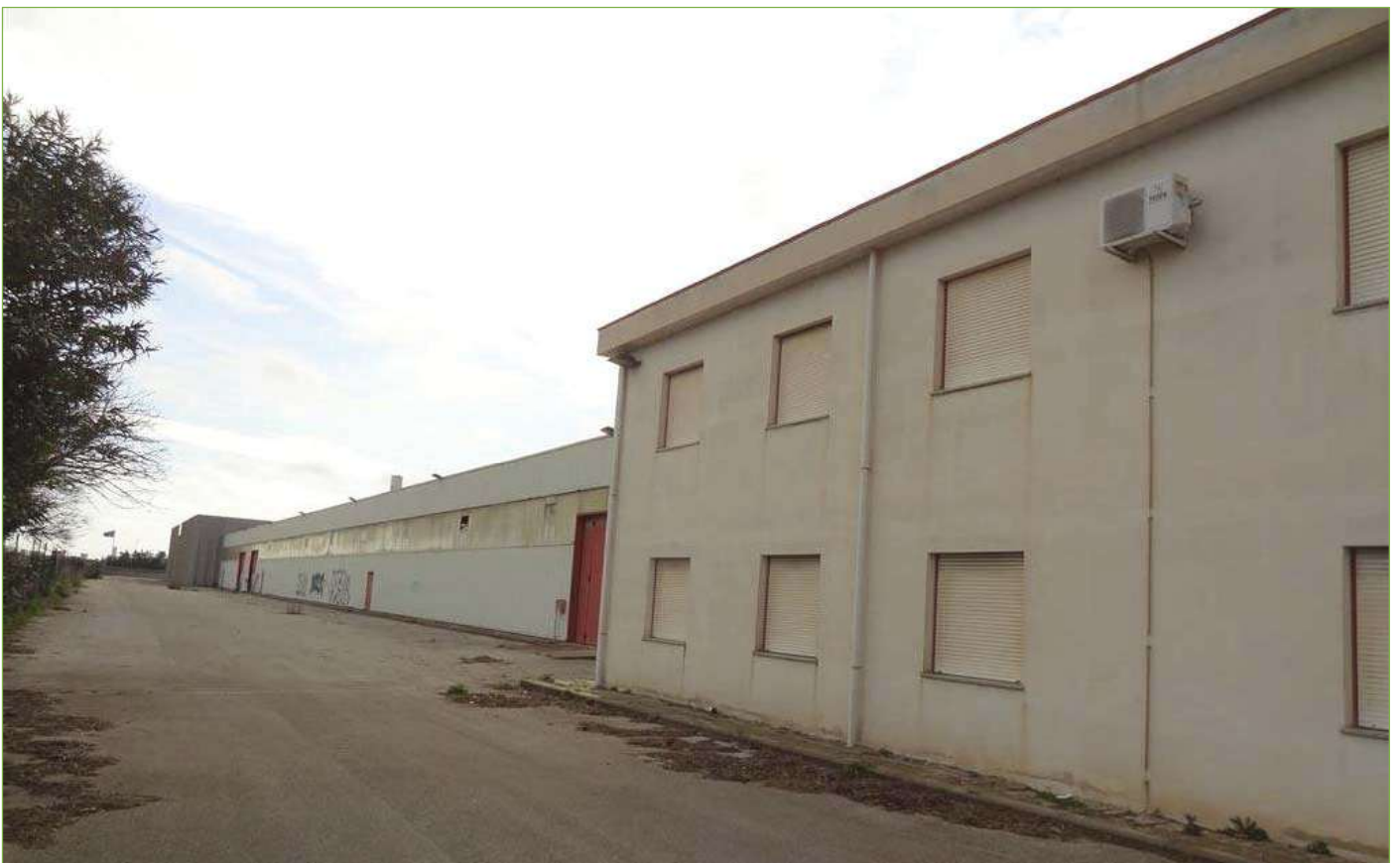
Foto n° 6: Vista del fabbricato da Nord-Est
