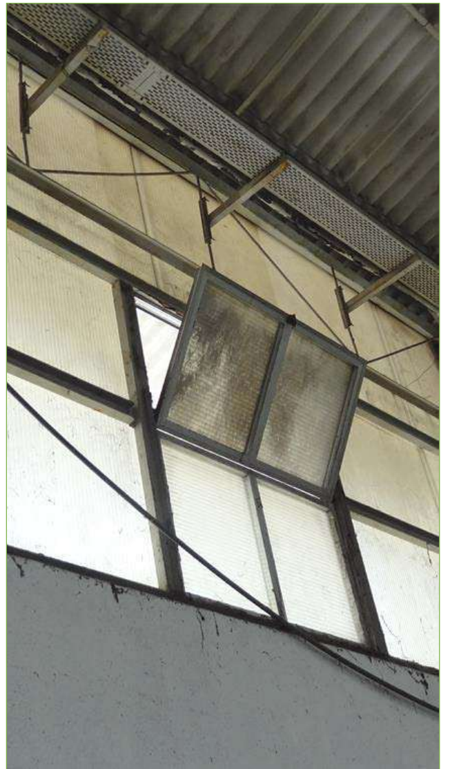
Foto n° 39: Capannone principale – Finestratura
