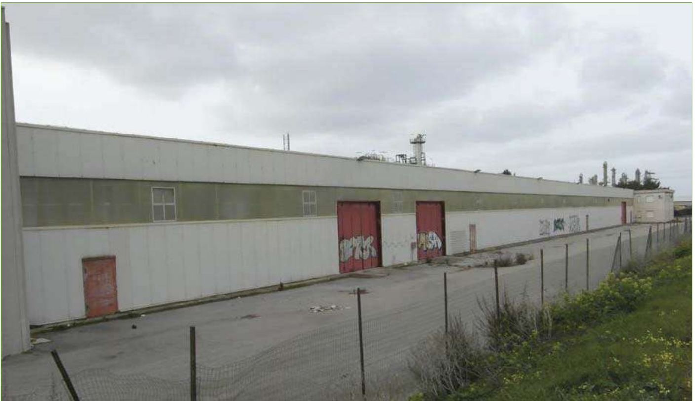
Foto n° 19: Capannone principale – Prospetto Est
