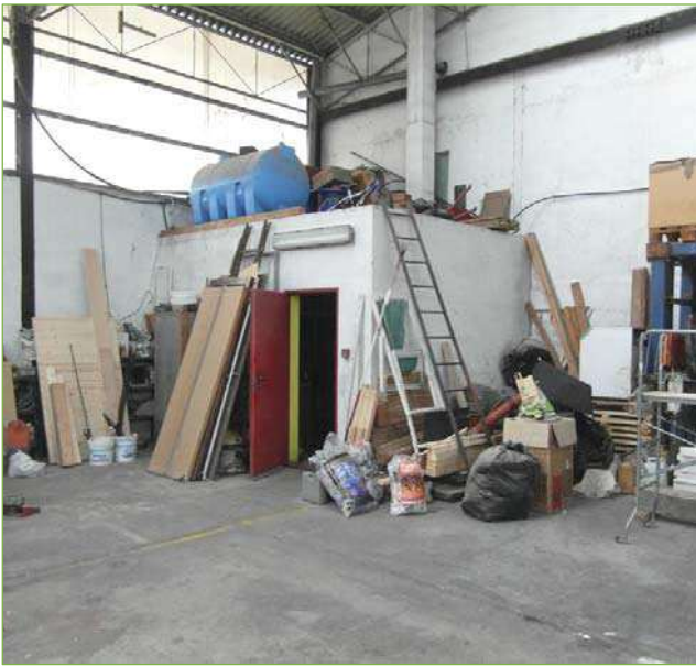
Foto n° 35: Capannone principale – Locale caldaia
