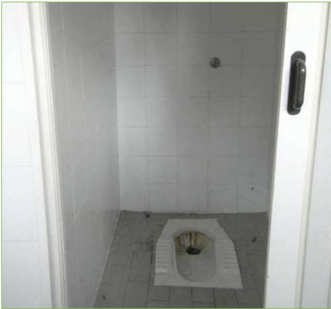
Foto n° 50: Palazzina – P. Terra – Servizi igienici
