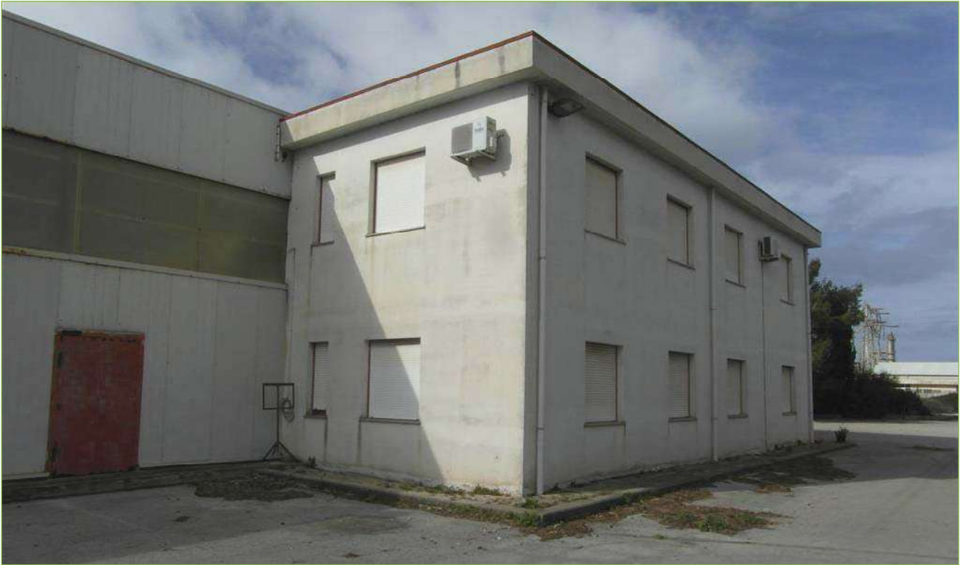
Foto n° 42: Palazzina – Prospetti Sud ed Est
