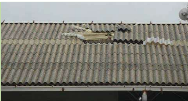
Foto n° 23: Capannone principale – Manto di copertura
