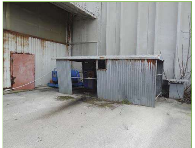
Foto n° 102: Baracca in lamiera (Sub.1)
