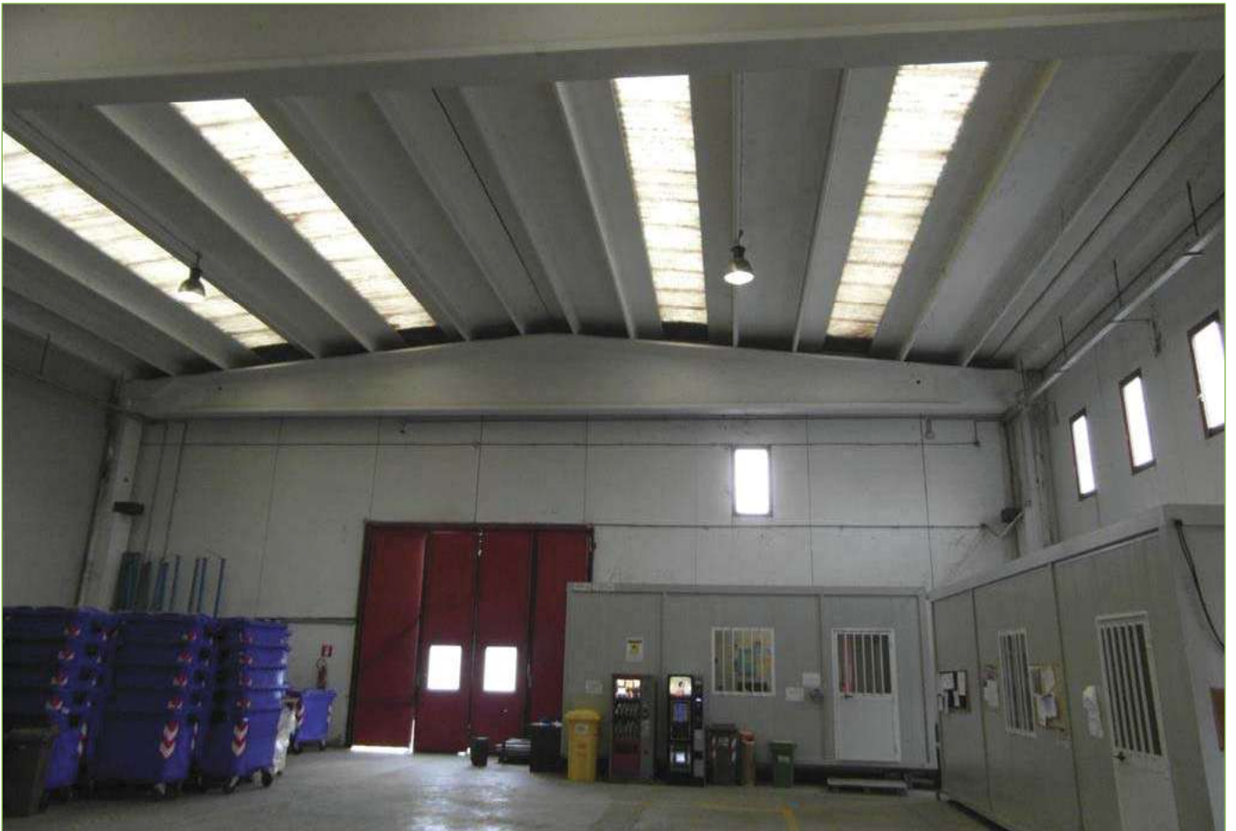
Foto n° 90: Capannone di nuova edificazione (Sub.4) – Interno
