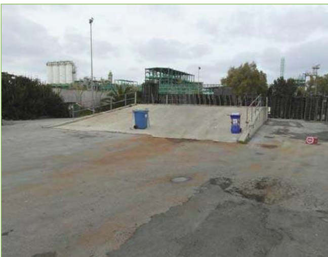
Foto n° 99: Rampa di carico materiali (Sub.4)
