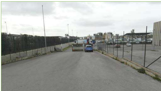
Foto n° 9: Rampa carrabile di accesso dal lato Est (Sub.6)
