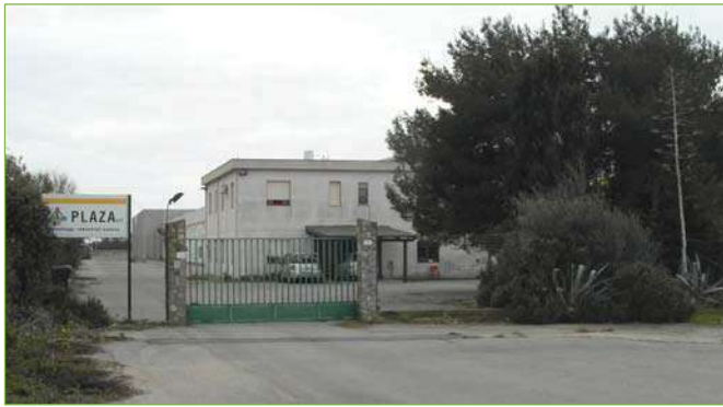
Foto n° 7: Ingresso al lotto lato Nord
