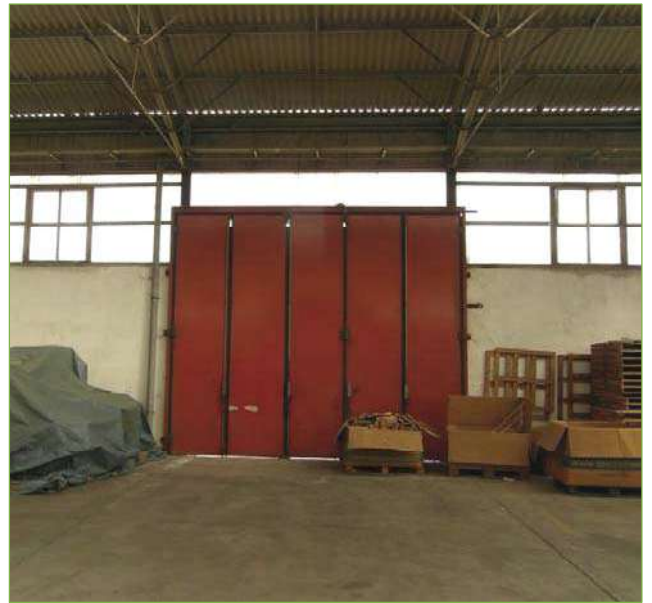
Foto n° 38: Capannone principale – Portelloni esterni
