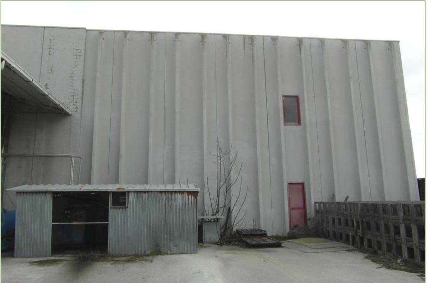
Foto n° 84: Capannone di nuova edificazione – Prospetto Nord
