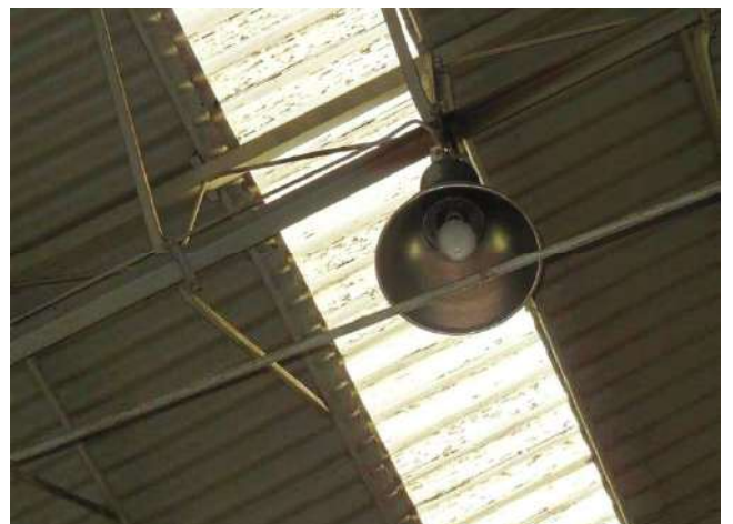
Foto n° 28: Capannone principale – Manto di copertura
