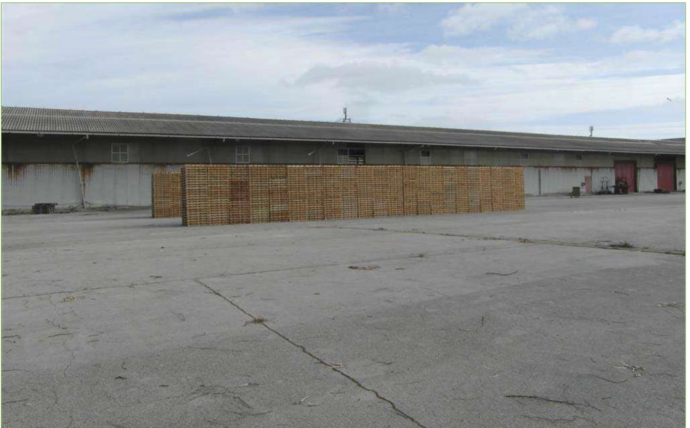
Foto n° 15: Capannone principale – Prospetto Ovest
