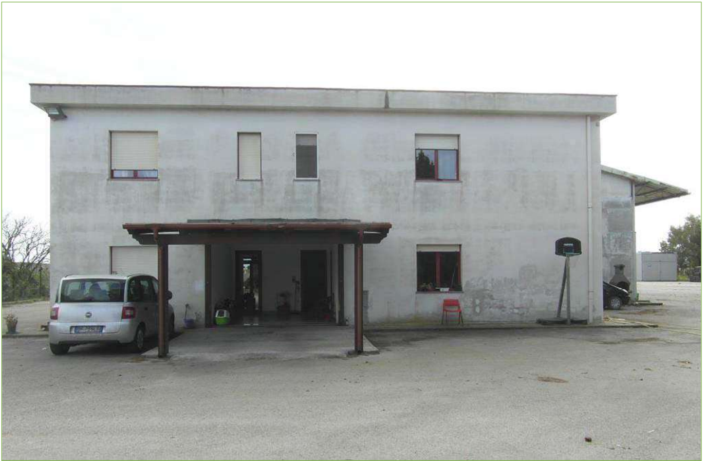
Foto n° 40: Palazzina – Prospetto Nord
