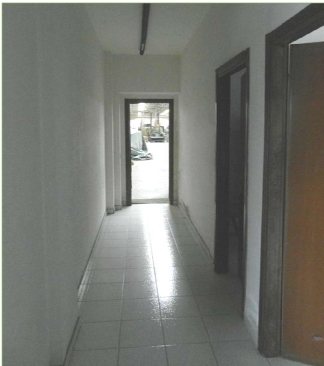
Foto n° 44: Palazzina – P. Terra – Corridoio zona servizi
