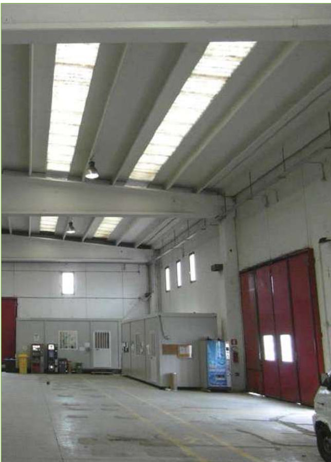
Foto n° 95: Capannone di nuova edificazione – Interno
