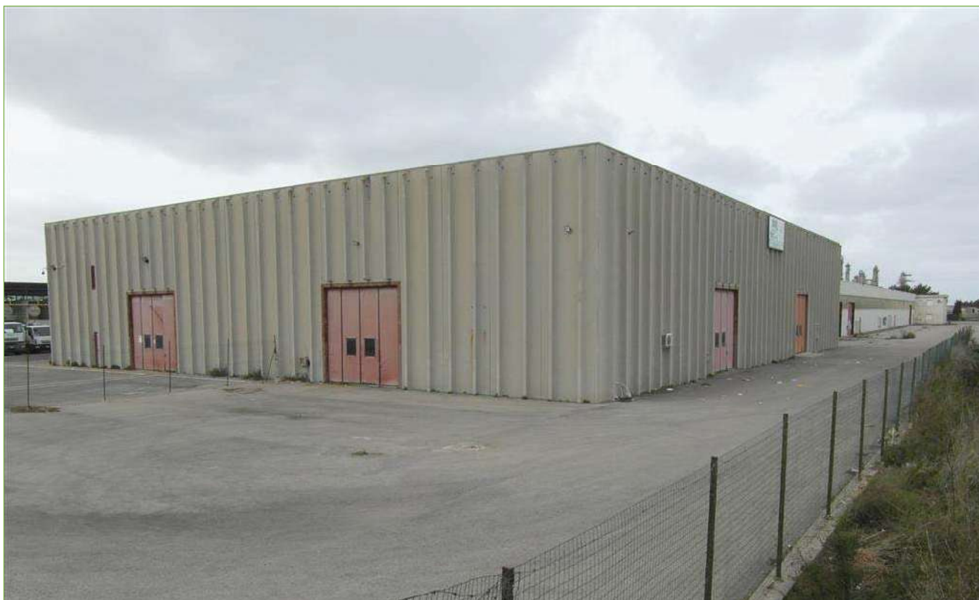
Foto n° 4: Vista del fabbricato da Sud-Est
