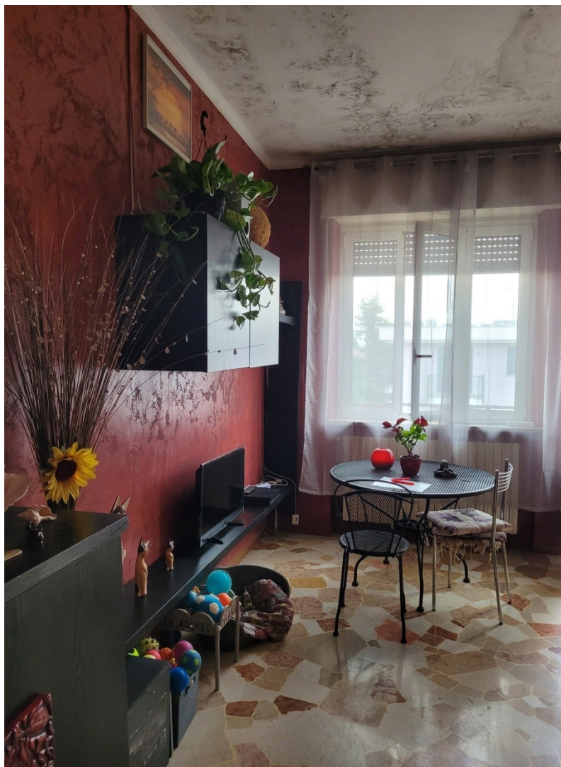
Soggiorno (si evidenzia in entrambe le immagini, l'ammaloramento del soffitto a causa dei danni provocati al manto di copertura dalla grandine, estate 2023)
