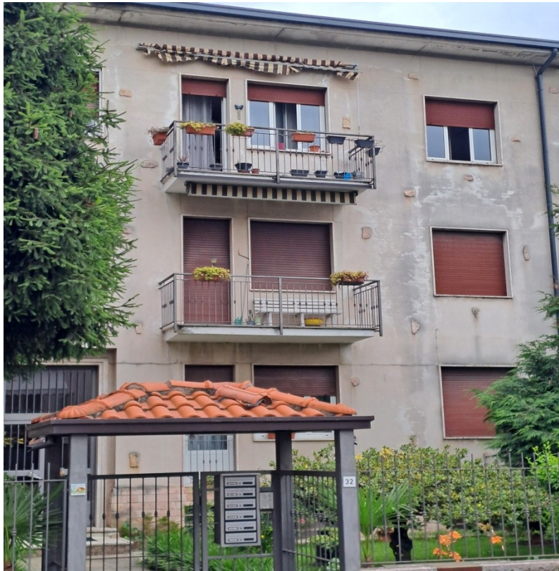
Vista della facciata del condominio da Via Cadorna
