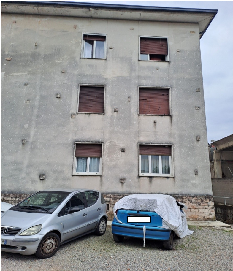
Facciata laterale del condominio su corte comune
