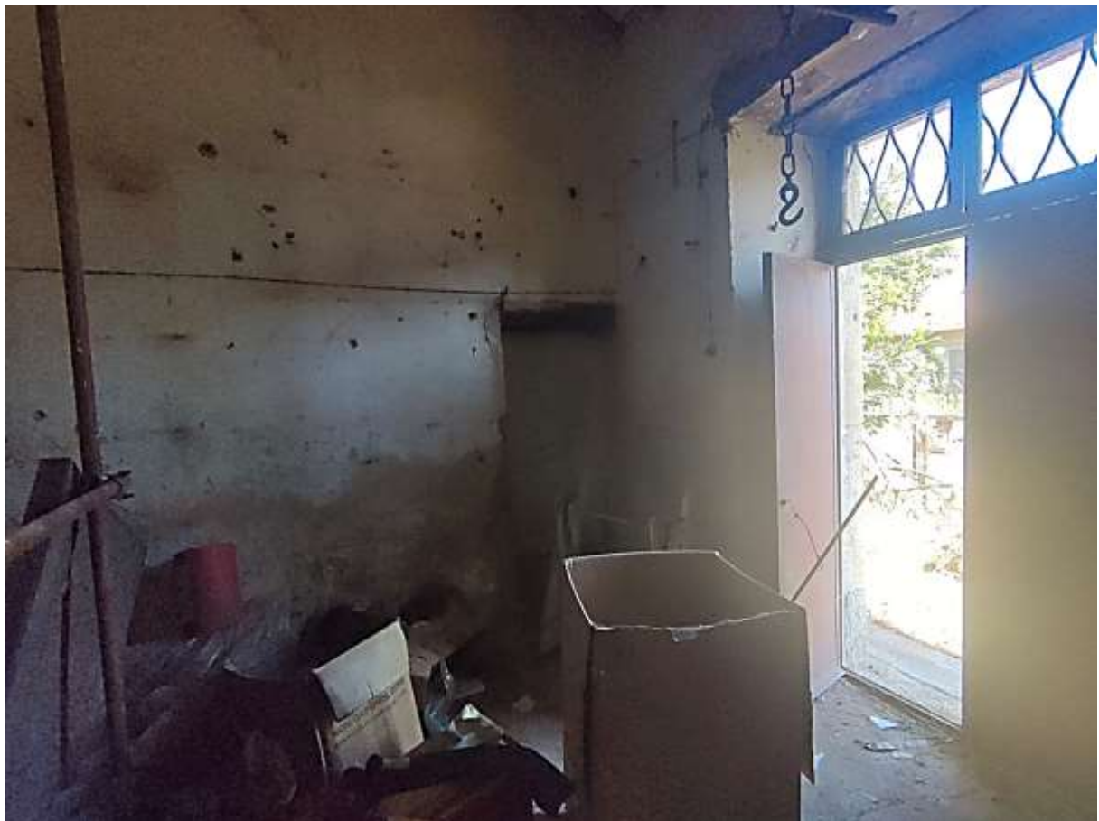
FOTO 08 – Fg. 89 P.Ila 9 (Cantina 1) Corpo 1E
