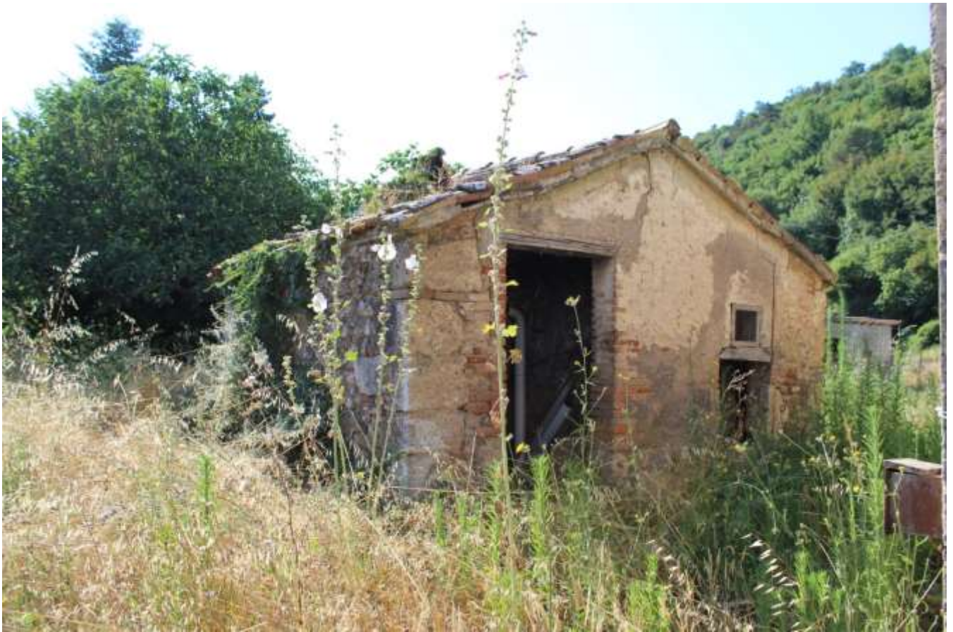
FOTO 09 – Esterno Fg. 89 P.Ila 9 (Forno) Corpo 1D
