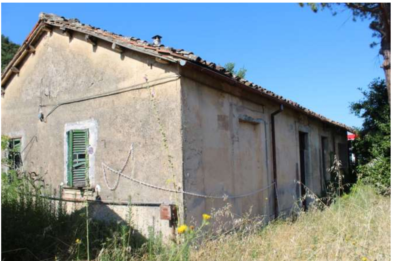
FOTO 02 – Esterno Fg. 89 P.Ila 9 (Abitazione – Corpo 1E)
