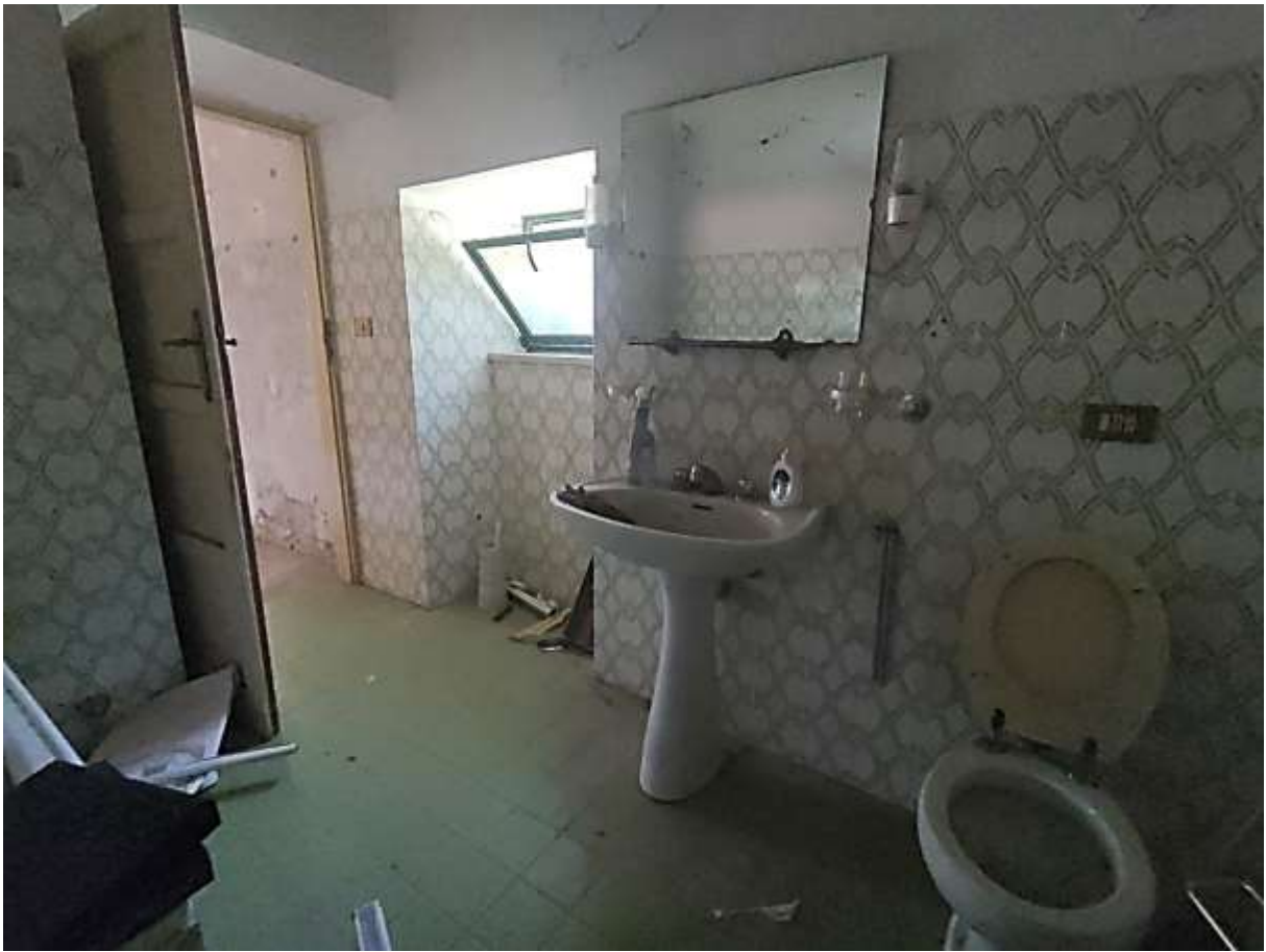
FOTO 05 - Fg. 89 P.Ila 9 (Abitazione - Bagno) Corpo 1E
