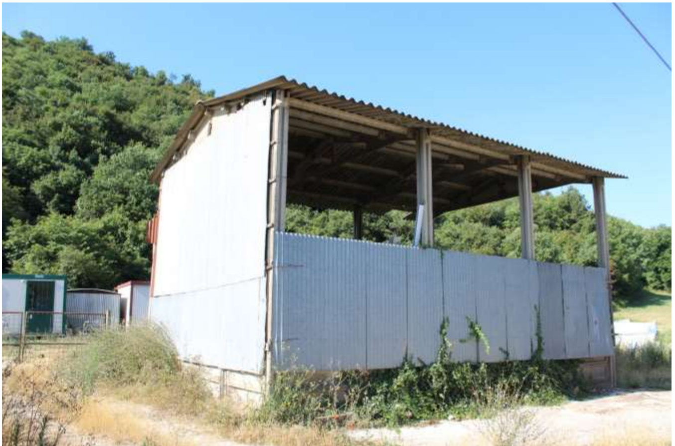
FOTO 10 – Esterno Fg. 89 P.Ila 267 (Locale di deposito) Corpo 2B
