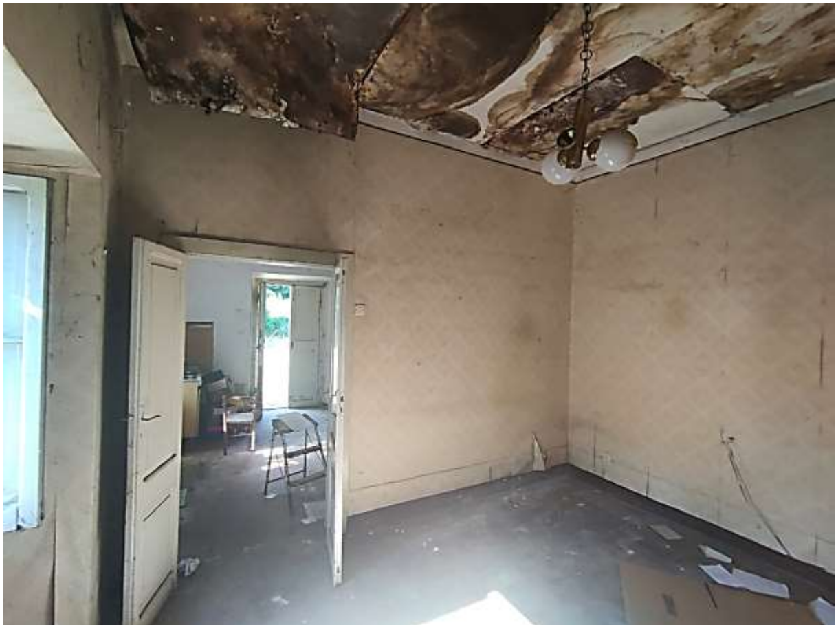
FOTO 04 – Fg. 89 P.Ila 9 (Abitazione – Camera 2) Corpo 1E
