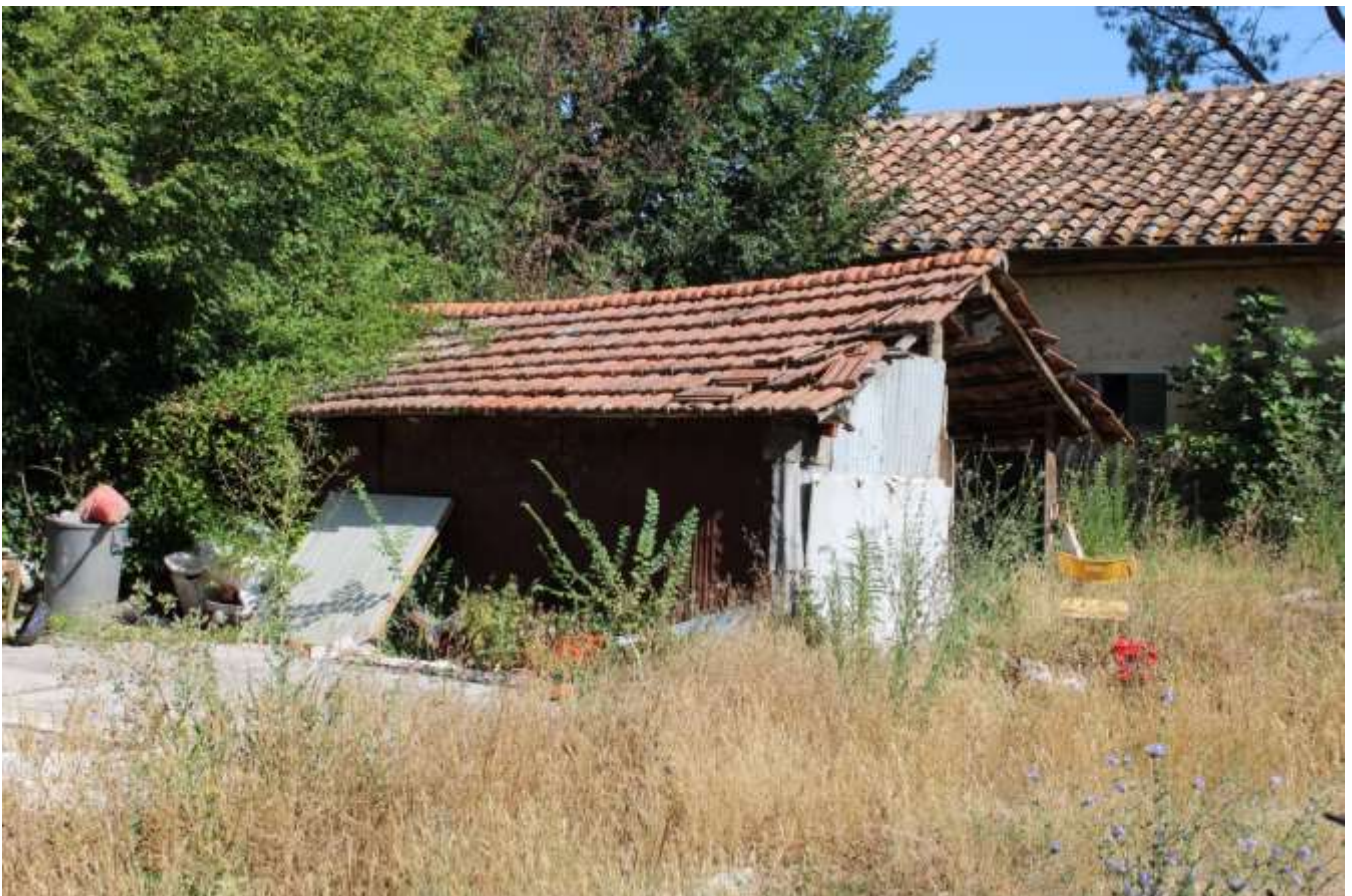
FOTO 10 – Esterno Fg. 89 P.Ila 9 (Cantina 2) Corpo 1C
