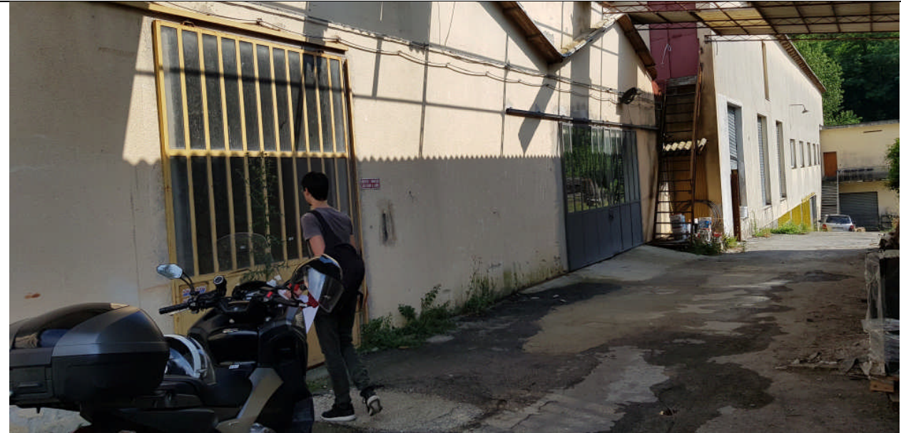
vista esterna lato ovest – portoni d'ingresso
