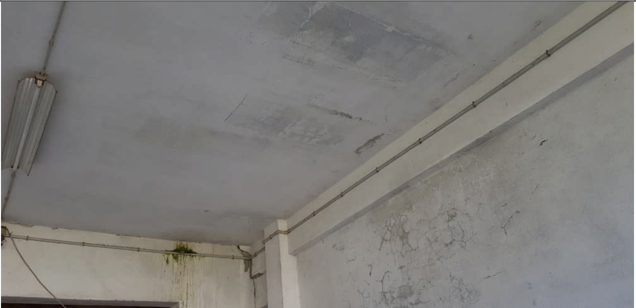
Vista interna Locale 2 – intradosso copertura
