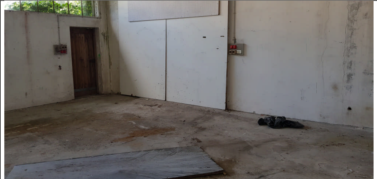
Vista interna Locale 2 – parete lato sud – confine interno
