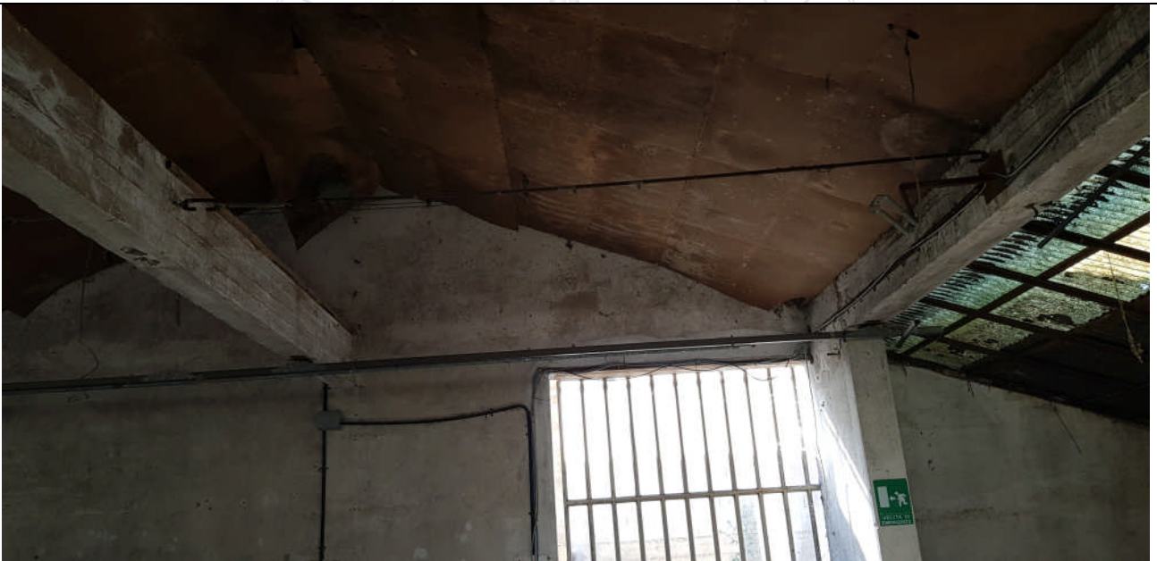
Vista interna Locale 1 – intradosso copertura
