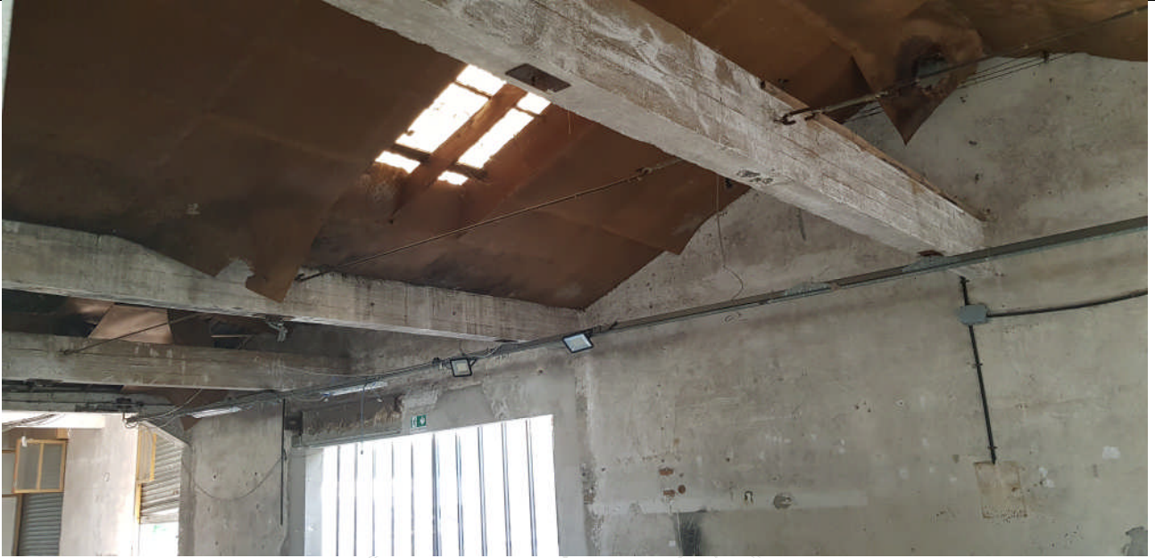
Vista interna Locale 1 – intradosso copertura
