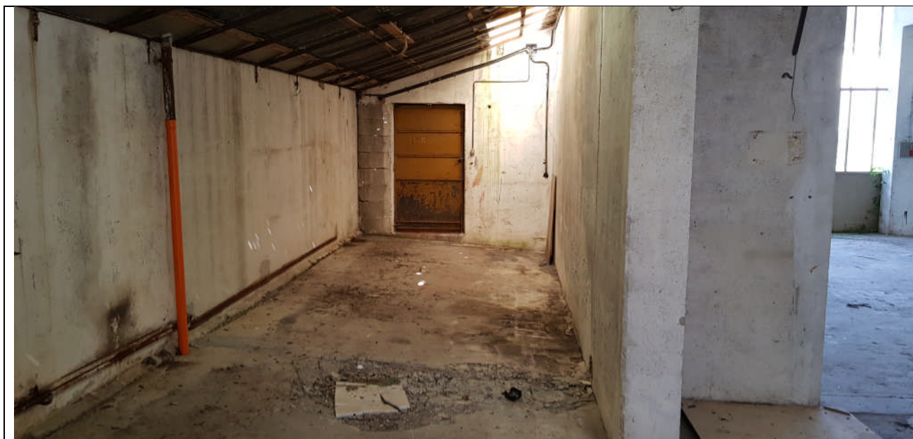
Vista interna Locale 3 – lato nord
