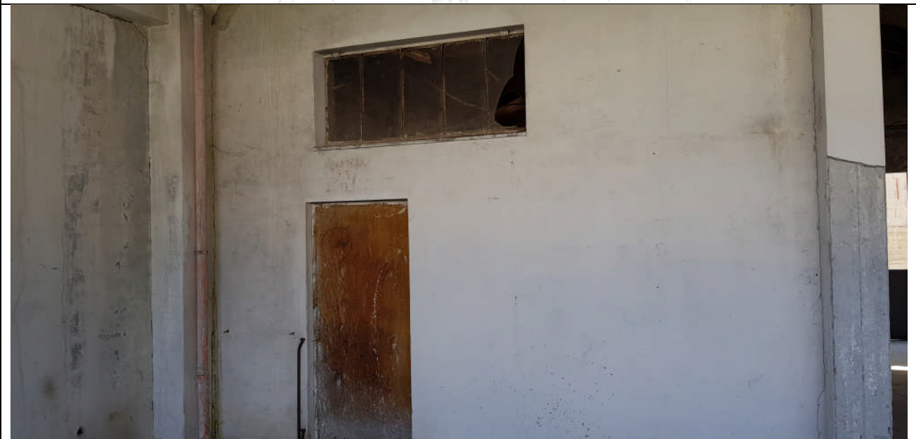
Vista interna Locale 2
