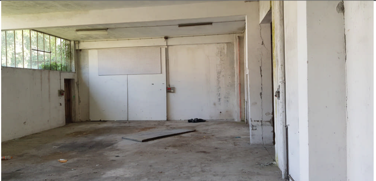
Vista interna Locale 2
