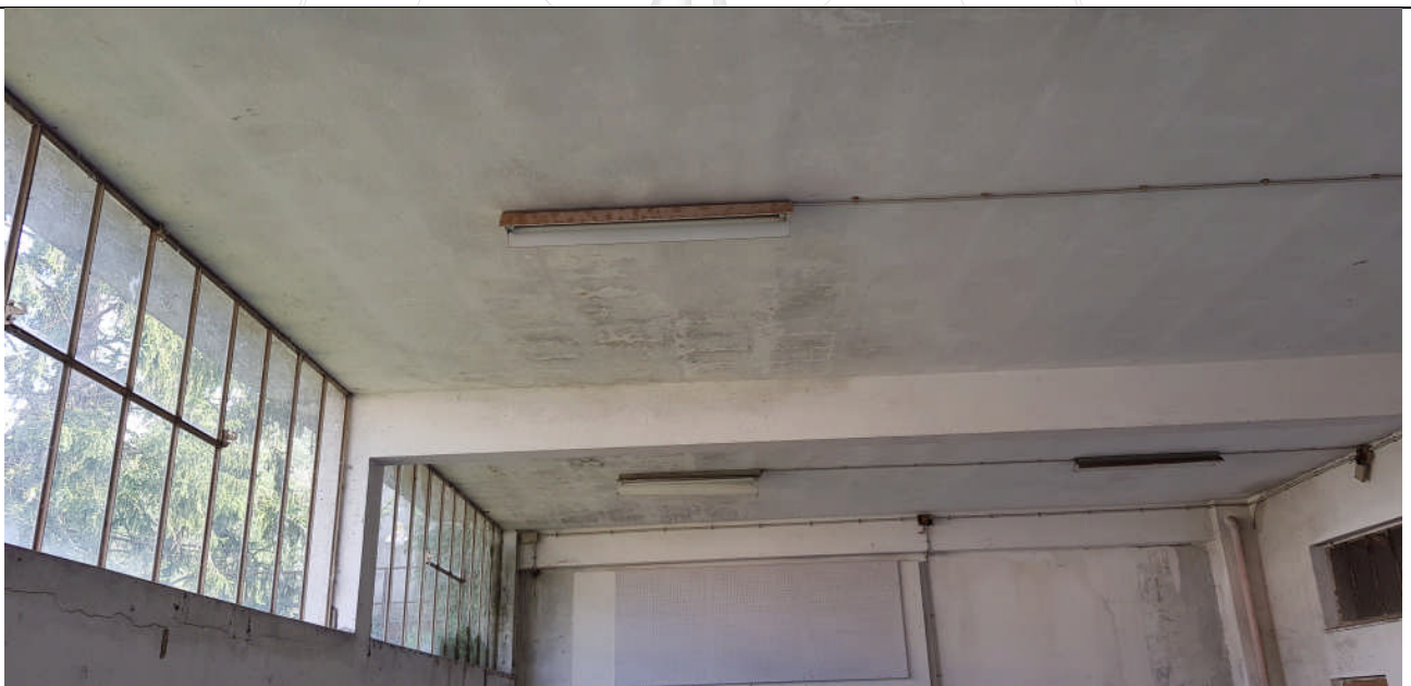
Vista interna Locale 2 – intradosso copertura
