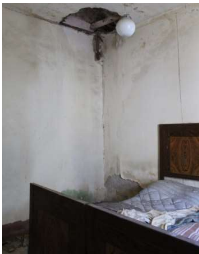
Foto 08 – Camera 3 (Piano Primo)
