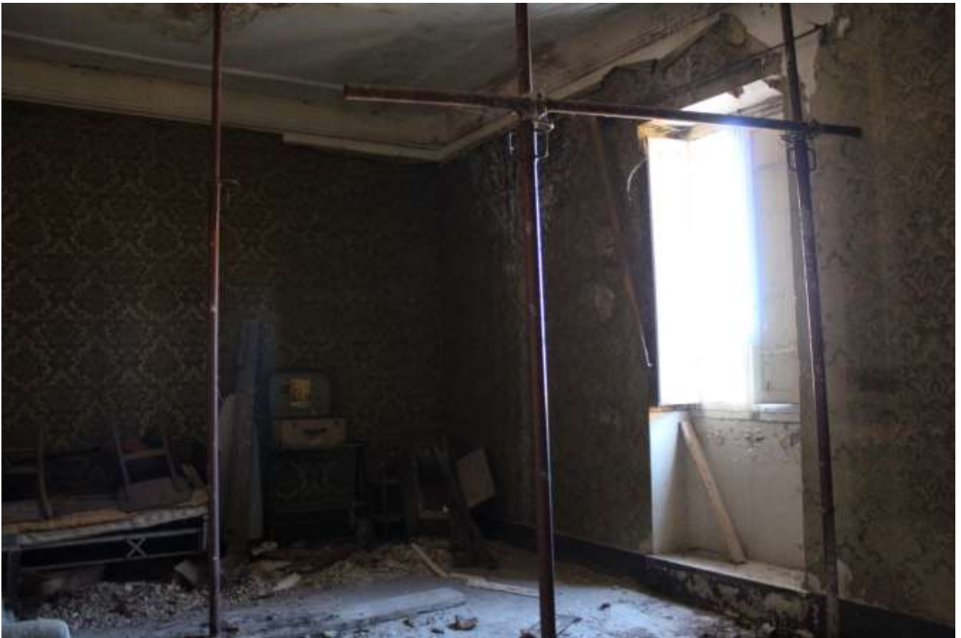
Foto 06 – Camera 1 (Piano Primo)
