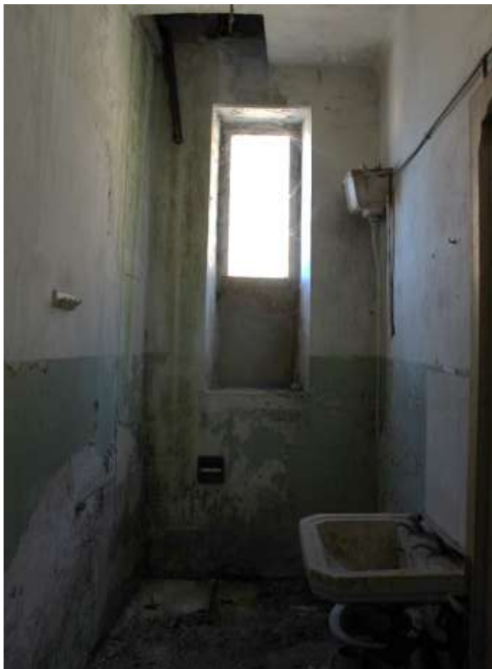
Foto 07 – WC (Piano Primo)
