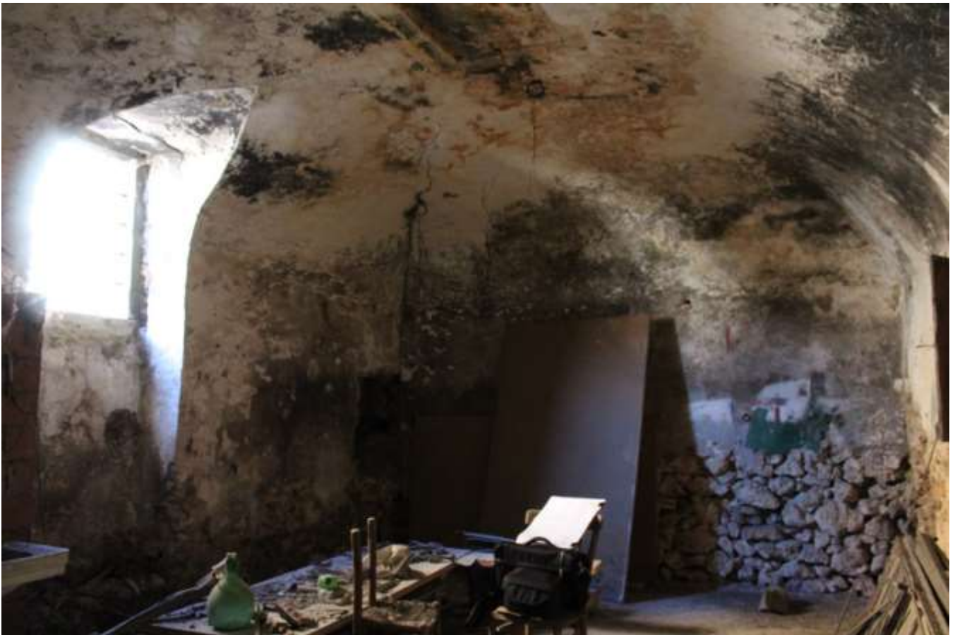
Foto 03 – Deposito 2 (Piano Terra)
