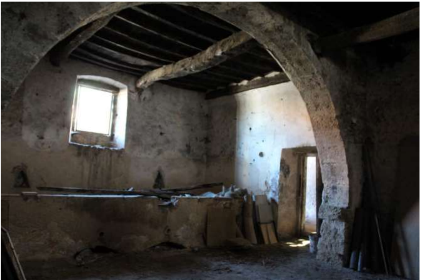
Foto 04 – Deposito 1 (Piano Terra)
