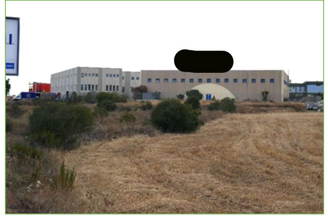
Foto n° 18: Viste di dettaglio dell'Immobile B
