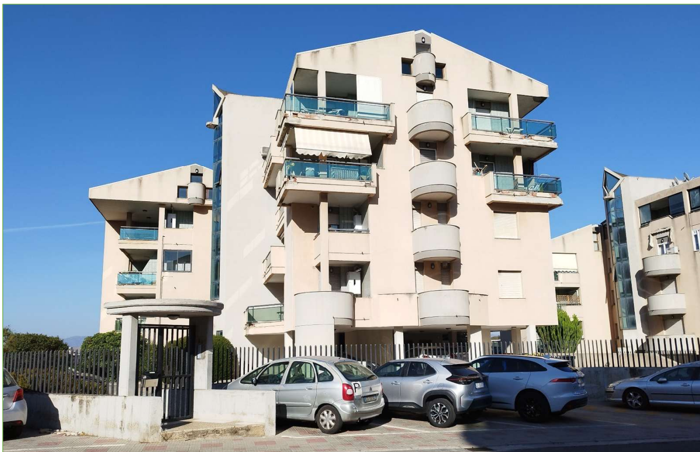
Foto n° 6: Vista del fabbricato condominiale e del cancello pedonale dalla via Simon Mossa
