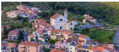
borgo di Feglino e individuazione del fabbricato oggetto di perizia
