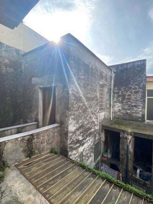
Foto 6: Immobile censito in C.F. al F.36 p.lla 60 sub 4
