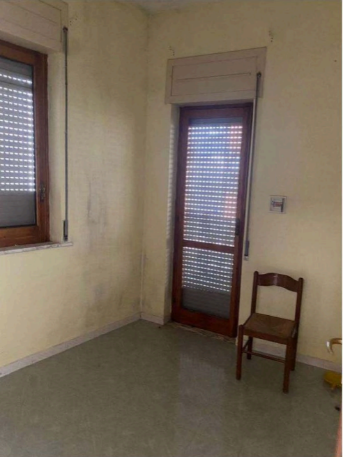
Foto 4: ambiente al piano primo
