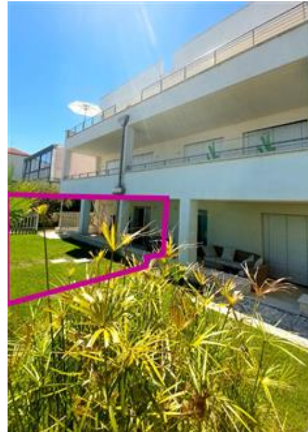
Vista esterna appartamento sub 15
