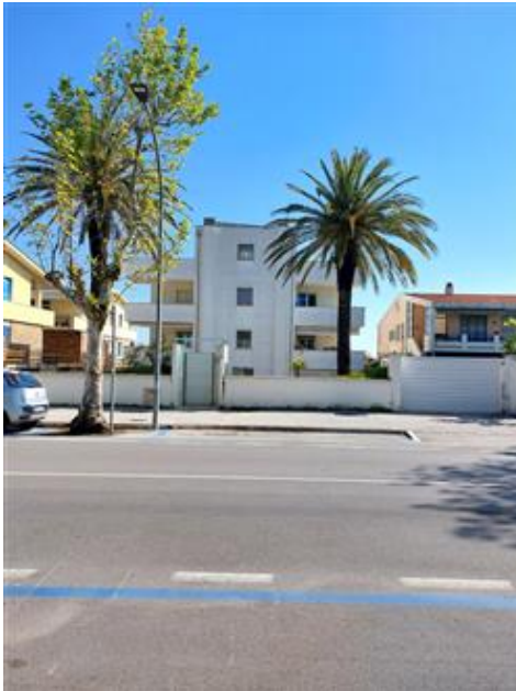
Vista esterna intero fabbricato
