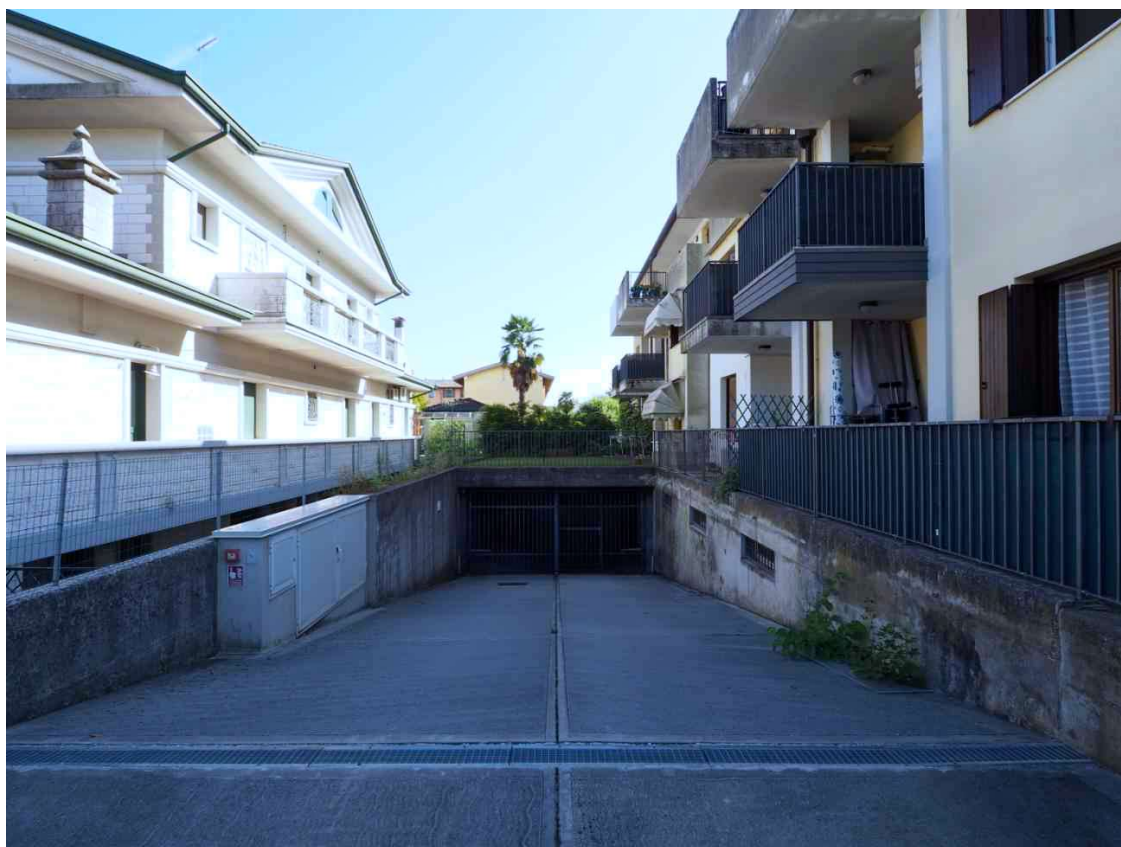
Cesarolo, via Cavalieri di Vittorio Veneto n. 3 – L'ingresso ai garage della palazzina.
