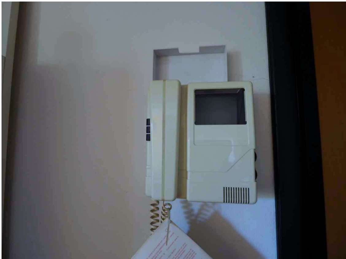
Cesarolo, via Cavalieri di Vittorio Veneto n. 3, int. n°. 14 – Sopra il quadro elettrico, sotto il citofono.
