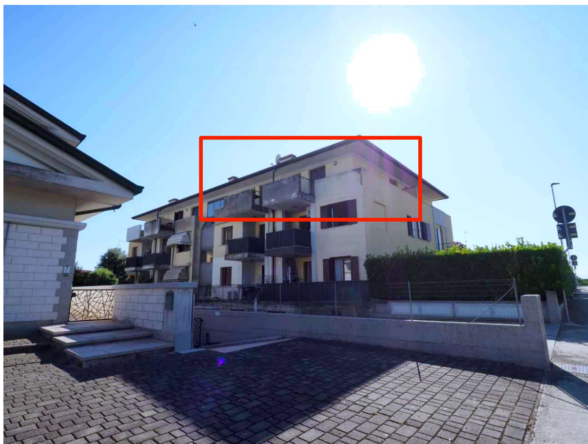
Cesarolo, frazione di San Michele Al Tagliamento, via Cavalieri di Vittorio Veneto n. 3 – Sopra l'aerofotogrammetria, sotto il prospetto est della palazzina.
