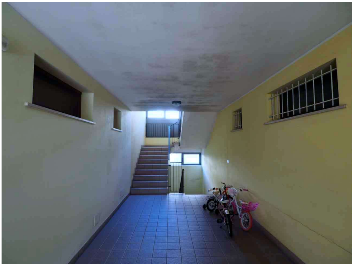
Cesarolo, via Cavalieri di Vittorio Veneto n. 3 – L'ingresso alla palazzina e il corpo scala.
