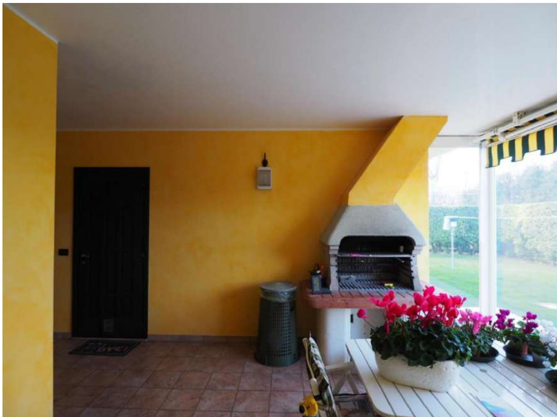
Porcia, via Romagna n. 30, P.T. – Particolare dell'impianto fotovoltaico e del barbecue esterno.
