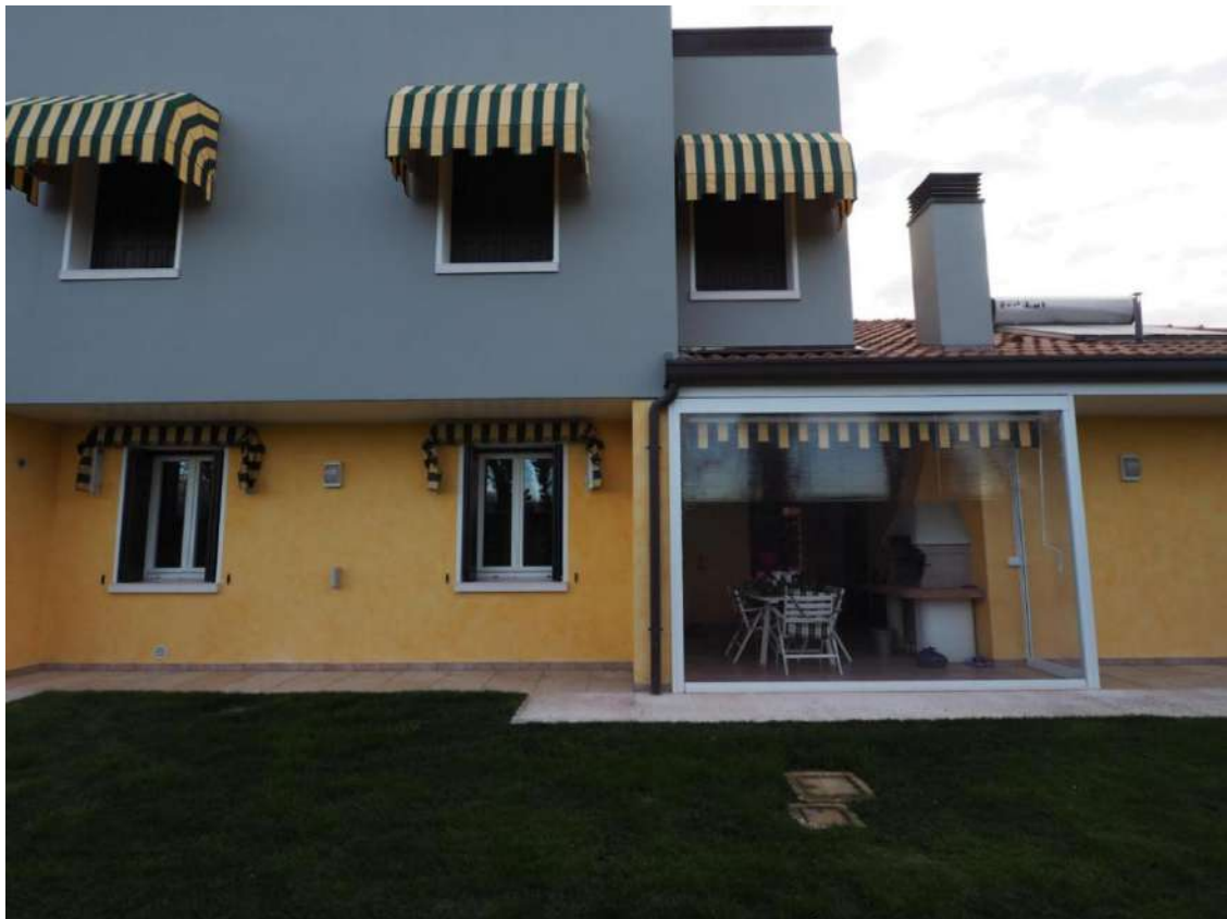
Porcia, via Romagna n. 30 - Il prospetto ad ovest della villetta a schiera.
