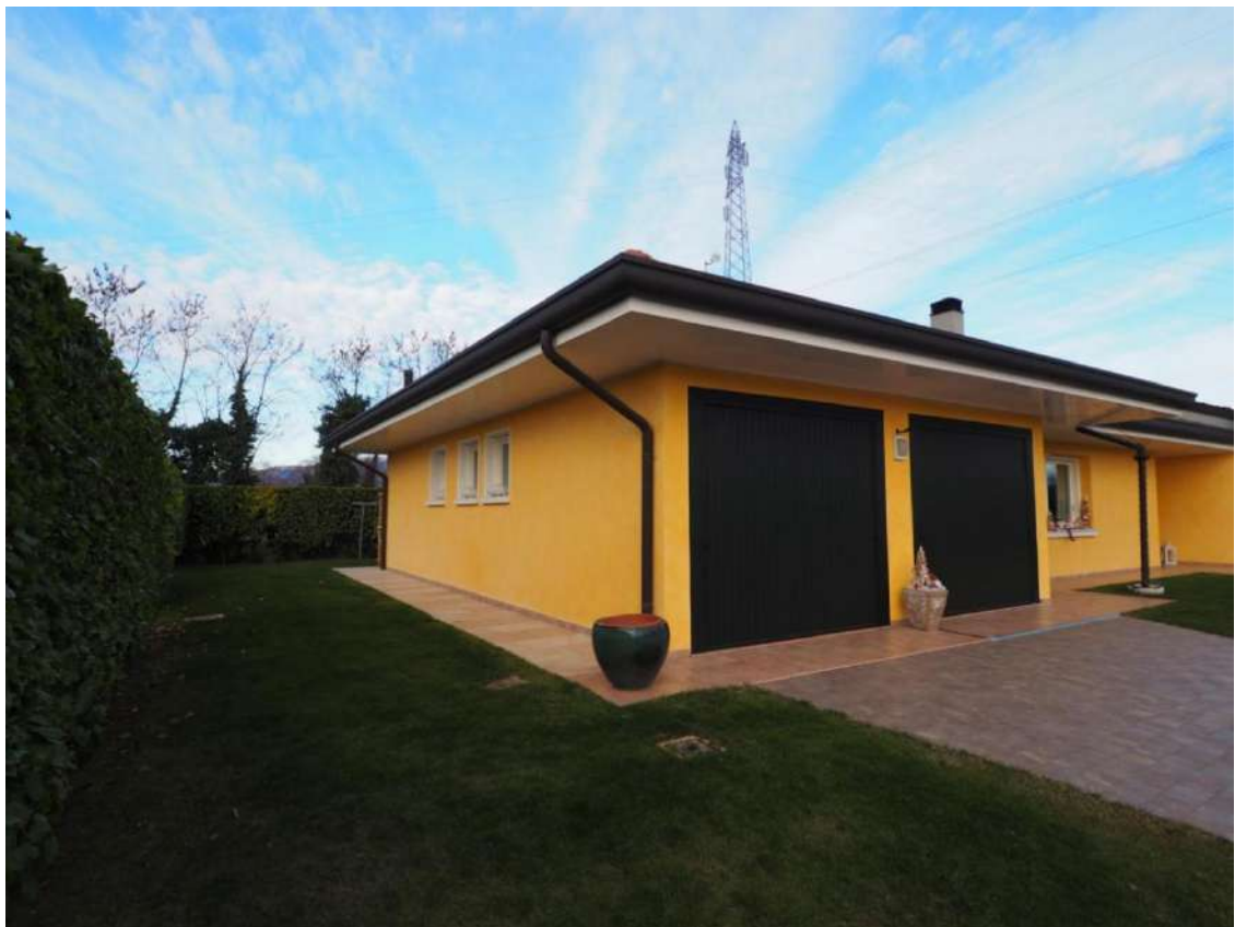
Porcia, via Romagna n. 30 - I prospetti a sud ed a est della villetta a schiera, la corte esterna.
