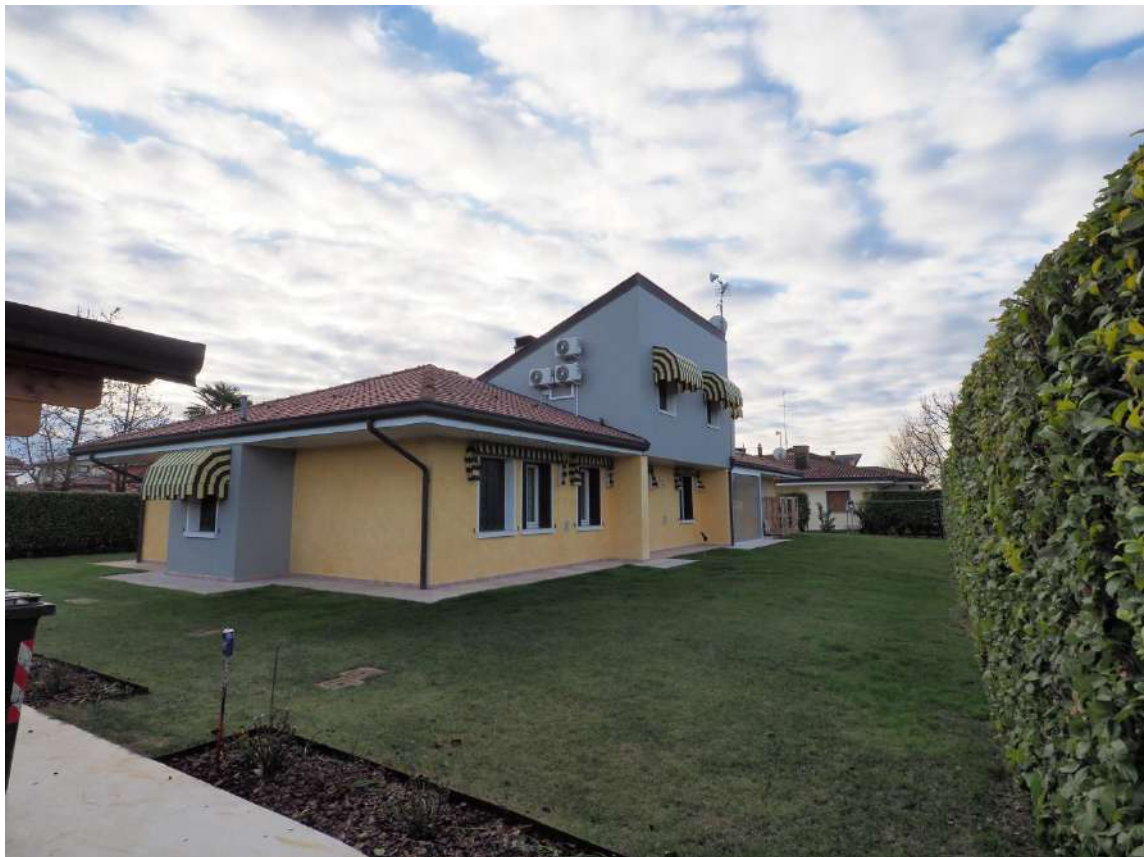
Porcia, via Romagna n. 30 - La corte esterna e il prospetto ad ovest della villetta a schiera.
