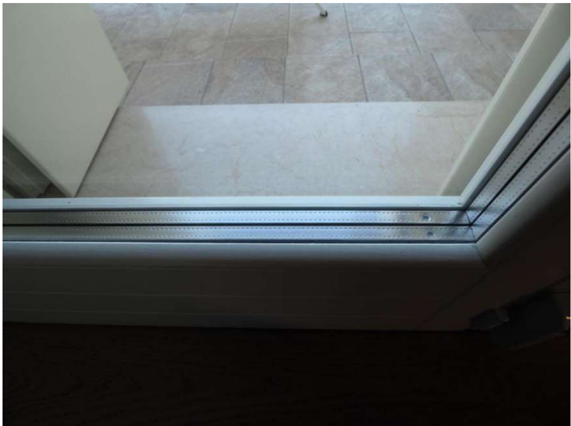
Pordenone, via Montereale n. 64 – Particolari dell'infisso esterno.
