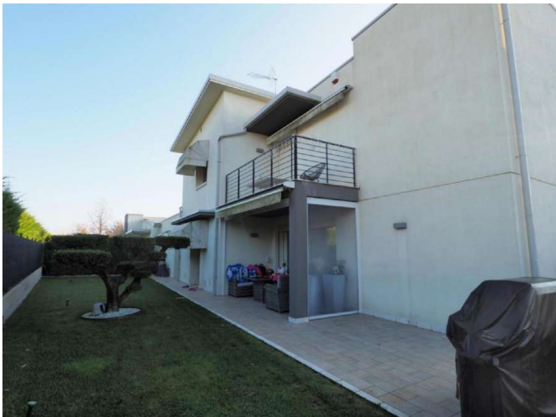
Pordenone, via Montereale n. 64 - Il prospetto a sud-ovest della villetta a schiera e la corte esterna.
