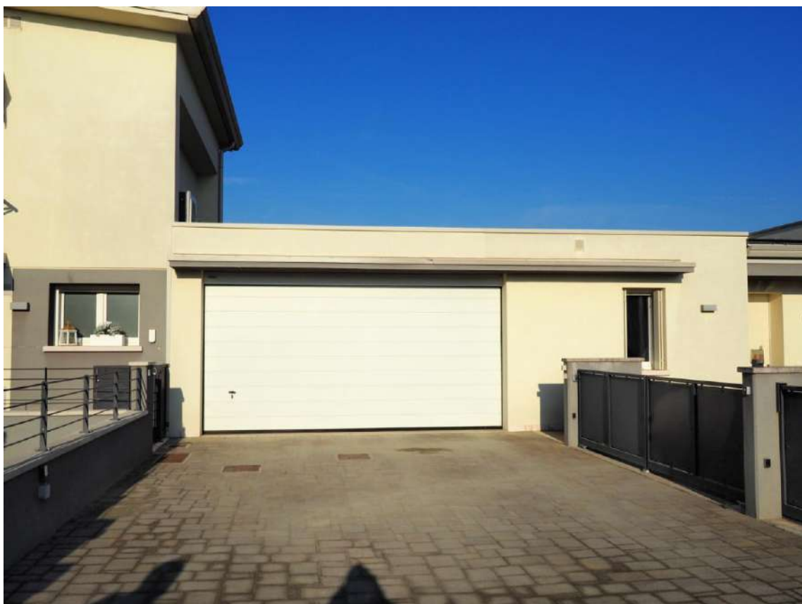
Pordenone, via Montereale n. 64 - I prospetti a nord-est ed a sud-est della villetta a schiera e , l'ingresso al garage.
