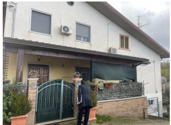
Particolare facciata del fabbricato ed ingresso
