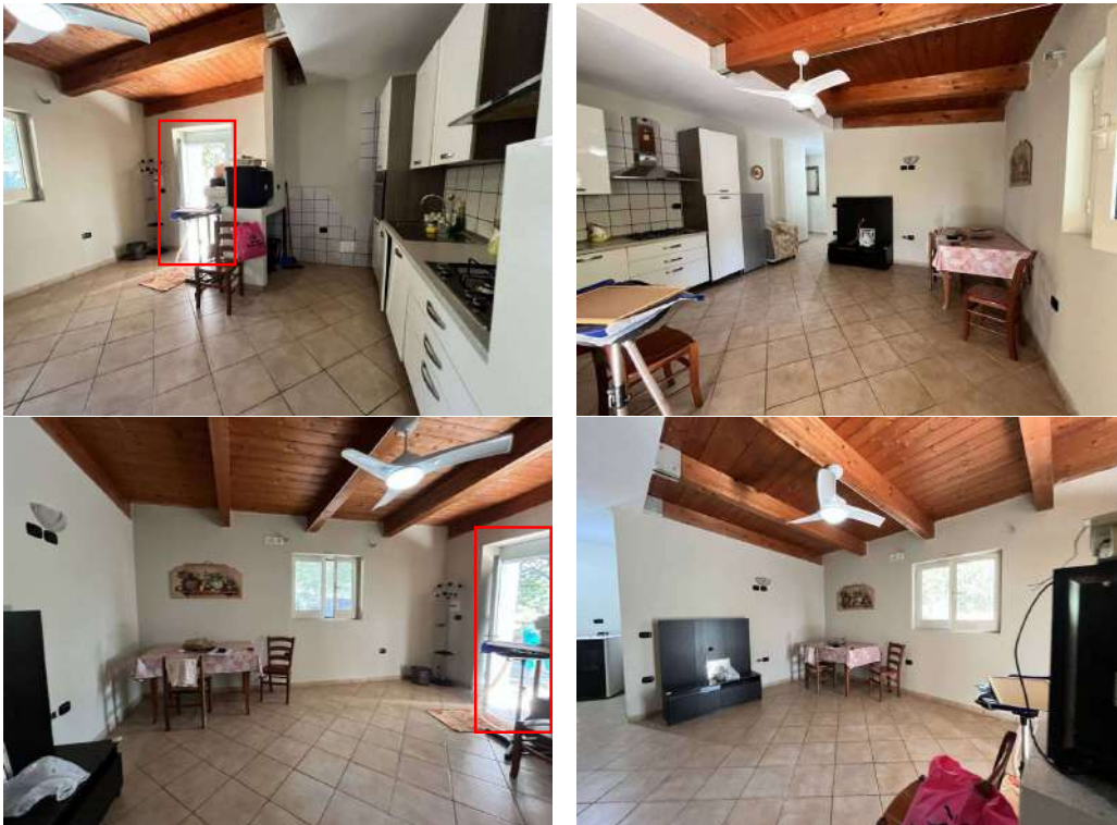
Rilievo fotografico CTU del 09.09.2025: Riprese da diverse angolazioni della zona di ingresso-zona giorno afferente all'ABITAZIONE 2 ispezionata in sede di II° accesso CTU: in rosso è evidenziata la porta di ingresso. Detta unità abitativa, risulta ristrutturata di recente. Parte del tetto è stata realizzata con copertura a una falda inclinata con travi in legno lasciate a vista.
