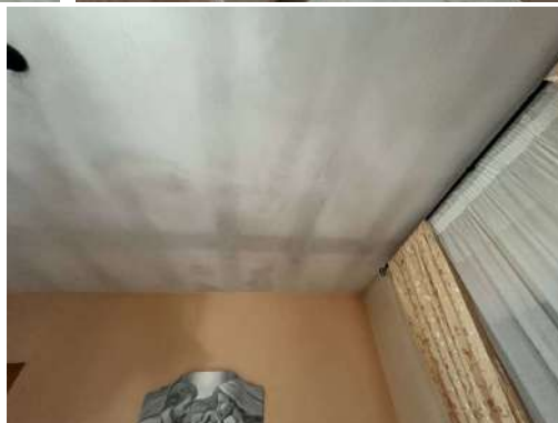
Rilievo fotografico CTU del 10.07-09.09.2025: Vano letto matrimoniale, dotato di macchie di umidità, annerimento e sfogliatura vernici , presenti in svariate zone sia del solaio di copertura che delle pareti.
