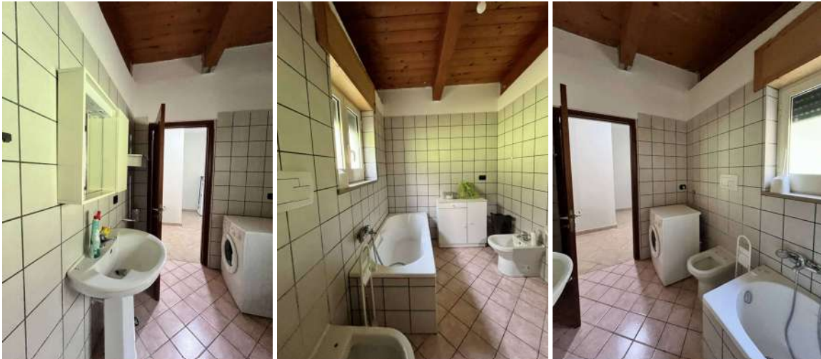
Rilievo fotografico CTU del 09.09.2025: Bagno dotato di vasca e zona lavanderia, in buone condizioni di conservazione e manutenzione, anch'esso con tetto in legno.
