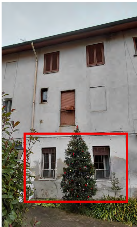
Vista fabbricato dal cortile viale Piave, 12 (Mappale 92) - Solo affaccio
