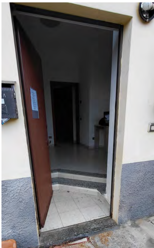
Piano terra – Ingresso appartamento dal cortile comune
