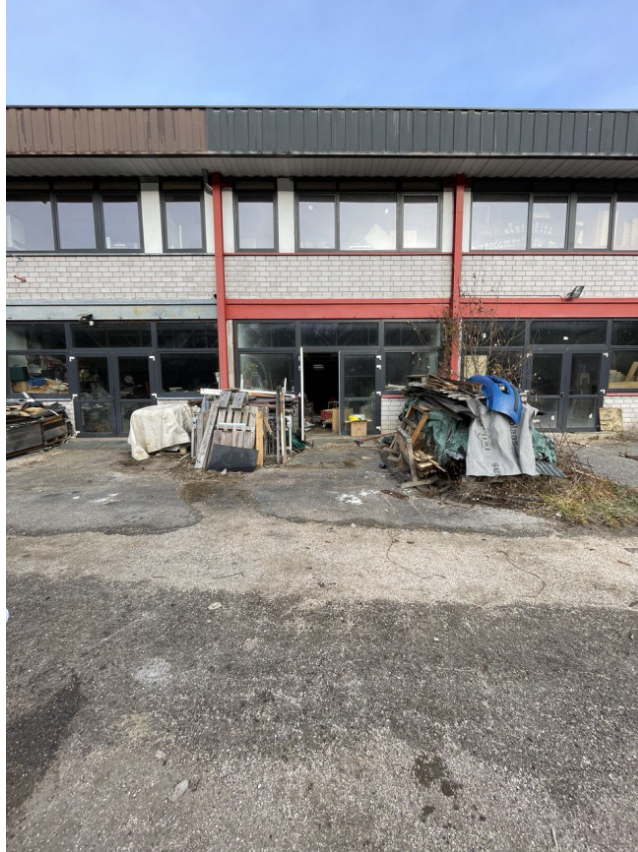
Lato Sud particella 281/sub 8
