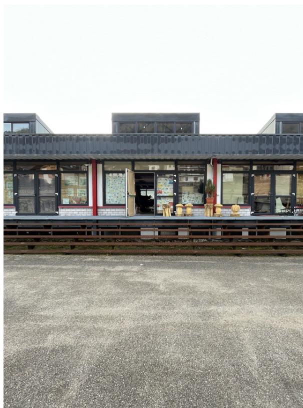
Lato Nord particella 281/sub 8
