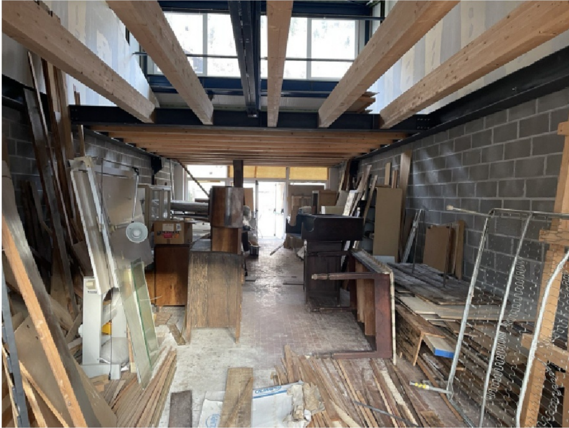
Locale al P1; il P2 è un soppalco solo in parte realizzato (travature)
