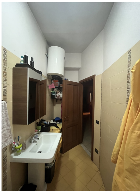
Foto 13 - Servizio igienico (wc2)
