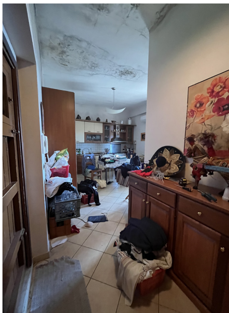
Foto 21 - Vano cucina presente al secondo piano
