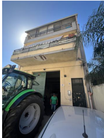
Foto 2-Vista esterna del fabbricato
