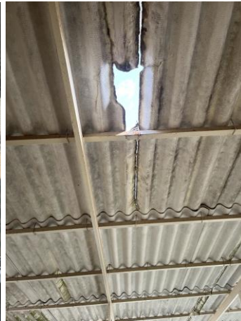
Foto 11-Particolare copertura ETERNIT
