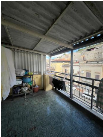
Foto 10-Terrazza con tettoia in ETERNIT
