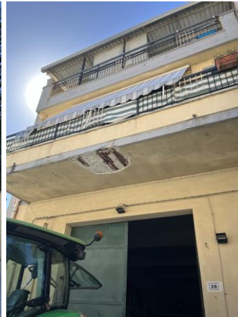
Foto 3-Vista esterna del fabbricato
